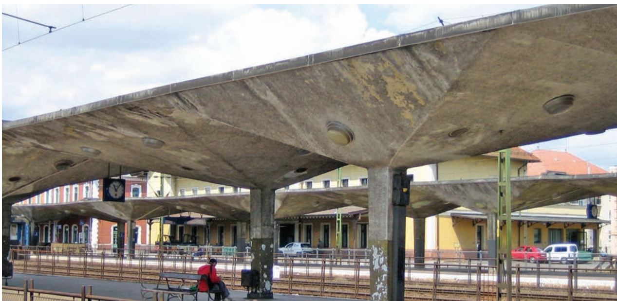
4. ábra. Miskolc-Tiszai pályaudvar meglehetősen leromlott állapotú vasbeton perontetői, 2007
