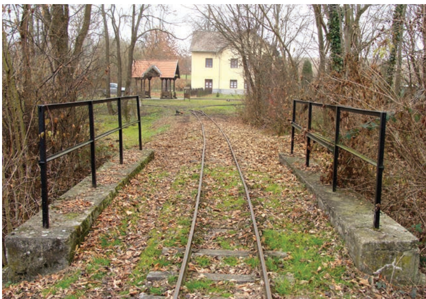
4. ábra. Az 1+36 hm szelvényben lévő, 4,00 m nyílású teknőhíd Almamellékénél (Fotó: Koller László)
