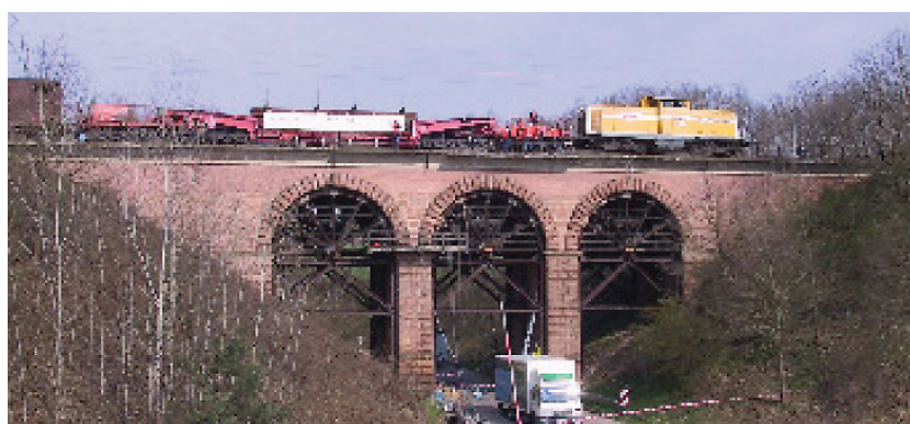
5. ábra. BELFA-DB terelőjármű egy falazott boltozott hídon
