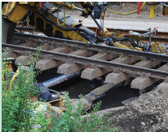
5. ábra. A Szajol–Kisújszállás és Kisújszállás–Püspökladány vonalszakasz vasútínpályá-korszerűsítésénél RDG geotextília beépítése nagygépes technológiával (Fotó: Gönczi Emese)
