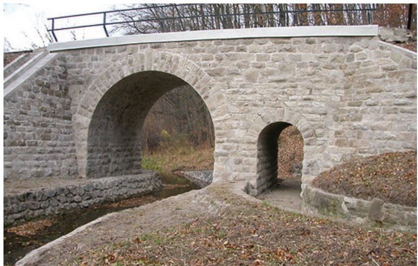
5. ábra. A Vác–Diósjenő vasútvonal 1850-ben épült berkenyei hídja
