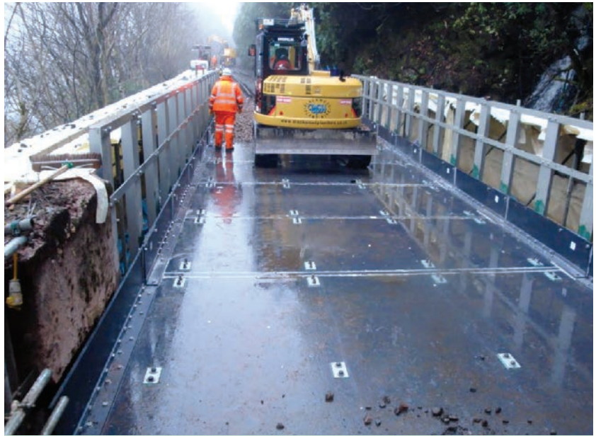
12. ábra. FRP hídpálya beépítése ugyanarról a vágányról
