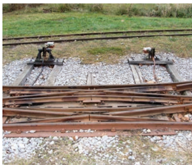
10. ábra. Almamellék állomás 1. kitérője az egyetlen 600 mm nyomtávolságú átszelési kitérő keresztezési része a csúcssínekkel (Fotó: Koller László)
