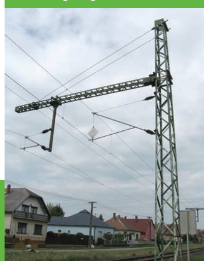
4. ábra. ...és a korróziós károk 3-4 m magasságban...
