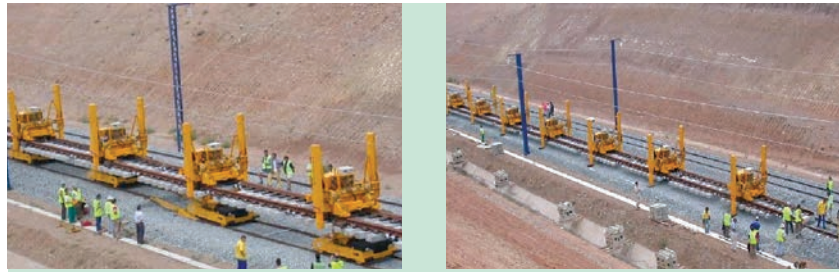
15. ábra. Fotók egy nagysebességű kitérő beépítéséről Geismar-Fasseta rendszerrel (Forrás: COMSA)
