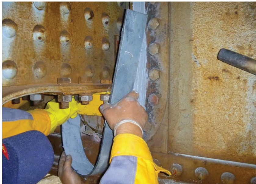
2. ábra. A rétszilasi acélhíd hossztartó megszakítás megerősítése
