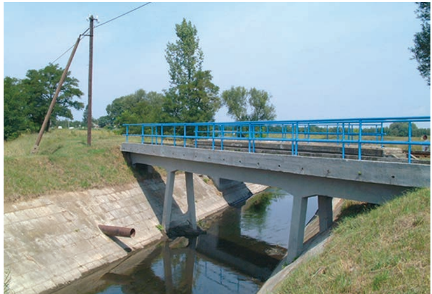
6. ábra. A Nyíregyháza–Dombrád vasútvonal 1905-ben épült vasbeton hídja
