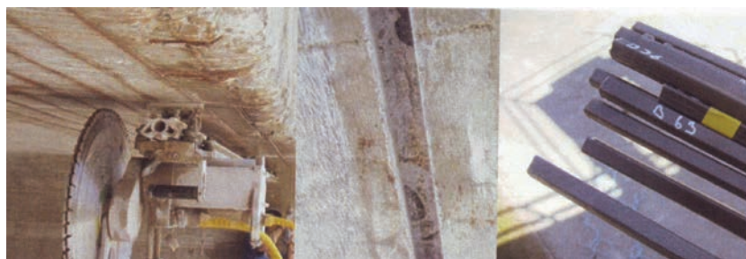
3. ábra. Horonyvágás a betonfelületben (bal oldalon), szénszállal erősített polimer rudak (jobb oldalon)
