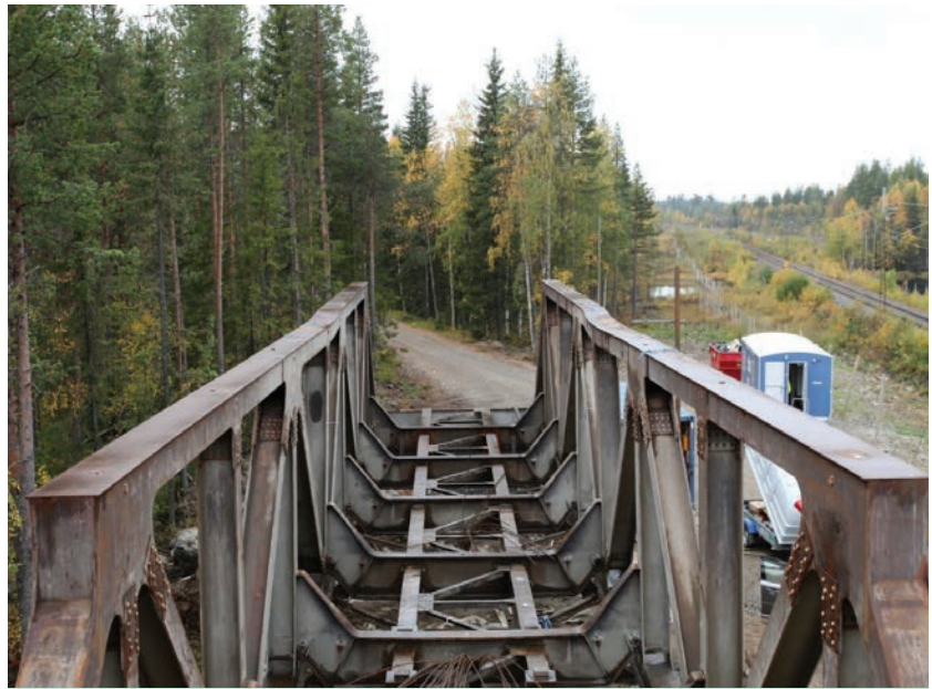
6. ábra. Tönkremenetelig terhelte rácsos tartó
