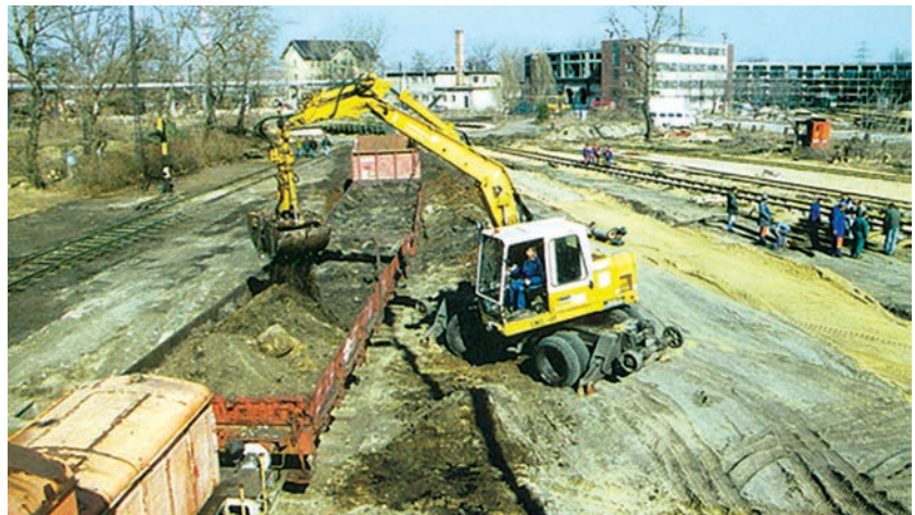
7. ábra. Talajcsere, az olajszenyezett talaj eltávolítása, 1996
