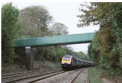
8. ábra. Üvegszál-erősítésű polimer gyalogoshíd, St. Austell, Egyesült Királyság, 2010
