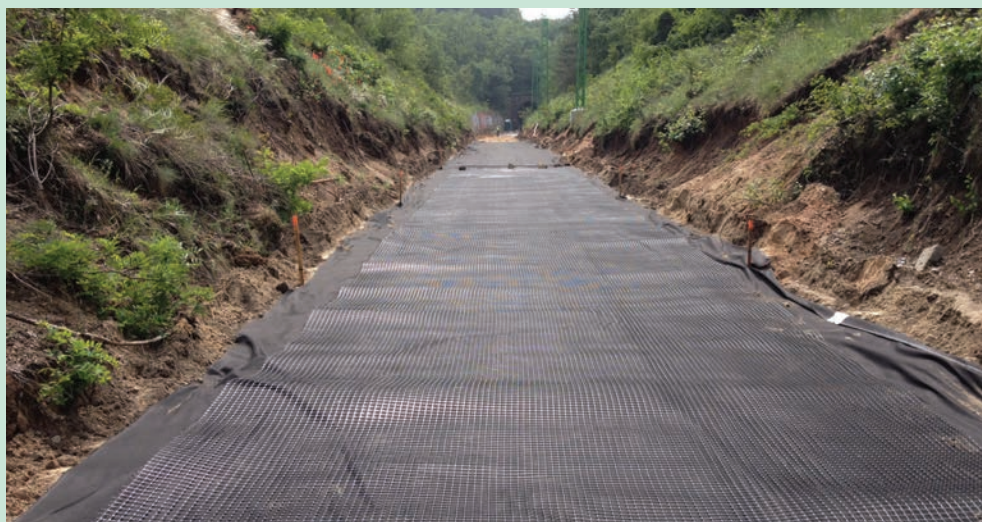
6. ábra. A Pilisvörösvár–Esztergom vonalszakasz pályaépítésénél RDG geotextília beépítése hagyományos, nyílt földmunkás technológiával (Fotó: Gönczi Emese)
