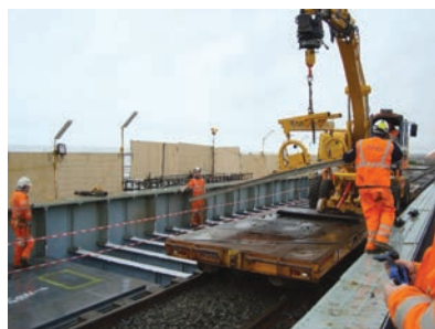
11. ábra. FRP hídpálya belépítése a szomszéd vágányról
