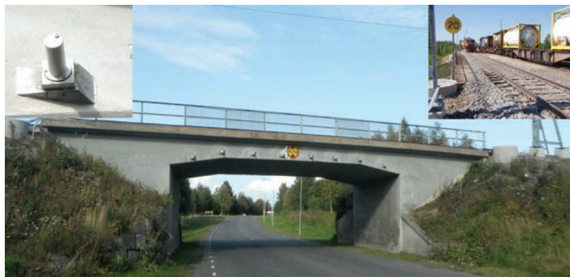
4. ábra. Vasúti híd megerősítése keresztfeszítéssel
