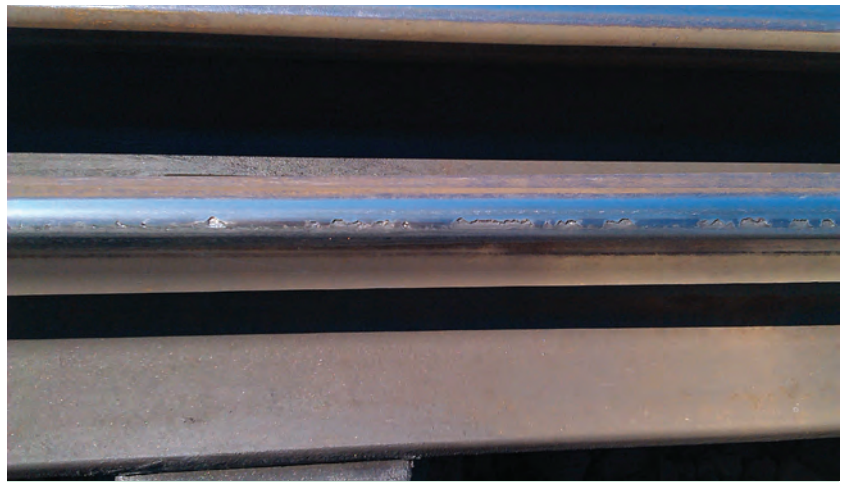
4. ábra. A sínfej-hajszálrepedés kialakulása
