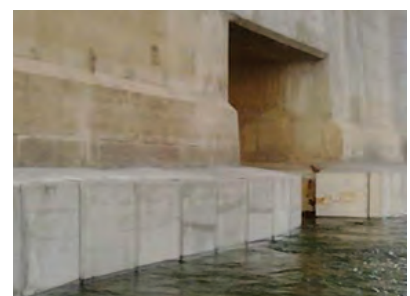
12. ábra. Felújított pillér a Déli összekötő hídon
