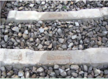
6. ábra. Keresztaljak éléinek letöredezése
