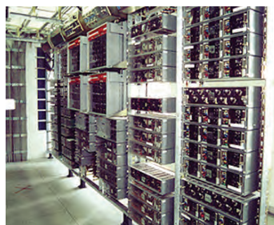
22. ábra. Domino-70-es berendezés állványsora
