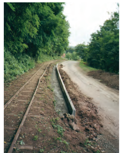
5. ábra. Támfalépítés (Fotó: Gerlang Ferenc)
