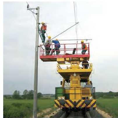
18. ábra. Felsővezeték szerelése
