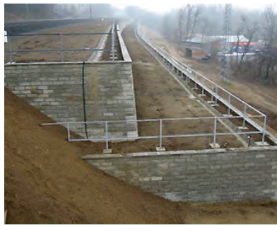
9. ábra. Töltés helyreállítása kiselemes talajtámfallal a Vác–Verőce szakaszon
