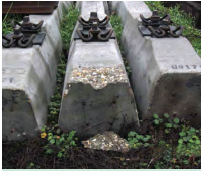
3. ábra. Pályába be nem építhető, sérült vasbeton alj (1)
