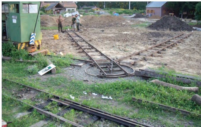
14. ábra. Múzeumi tárolóvágányok építése (Fotó: Szűcs Zoltán)
