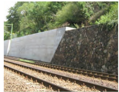
10. ábra. Görgetegfogó fal meghosszabbítása a Nagymaros–Szob szakaszon
