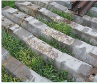
4. ábra. Pályába be nem építhető, sérült vasbeton alj (2)
