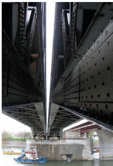
11. ábra. Pillérhomogenizálás a Déli összekötő hídon
