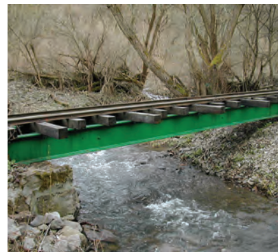
13. ábra. Felújított hídszerkezet (Fotó: Németh István)
