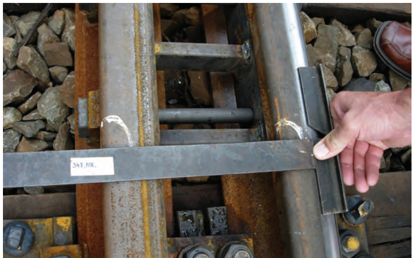
39. ábra. A csillagpontok helyzetének ellenőrzése az újonnan beépített félváltónál
