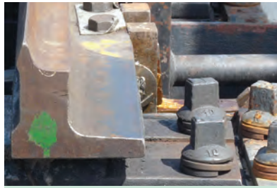
49. ábra. B 54 XIV. rendszerű kitérők régi (az erőátadási síktól távoli) rövid rúdjának bekötése
