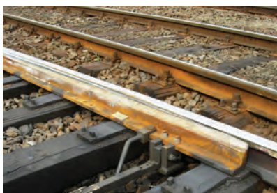
48. ábra. Régebbi (görgő nélküli) kitérő sínzékeinek állapota, gondozottsága
