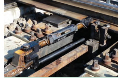
50. ábra. B 54 XIV. rendszerű kitérő új (az erőátadási síkhoz közeli), rövid rudazata
