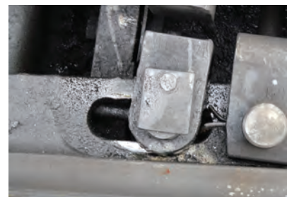
44. ábra. B 60 XIV. rendszerű kitérők középső csúcseinjeit összekötő kapcsolat
