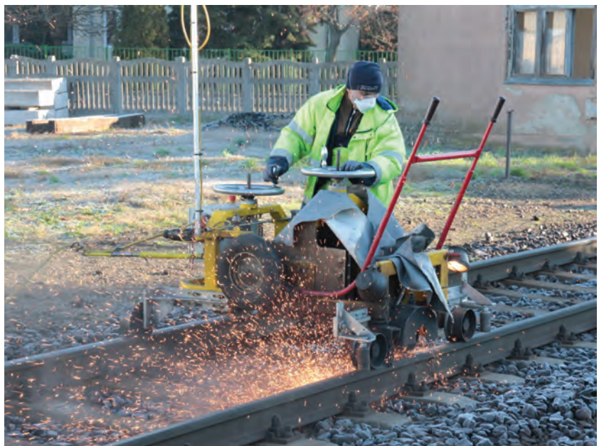
1. ábra. RailshapeEco nagy teljesítményű sínköszörű kisgép
