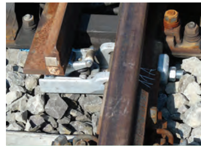
26. ábra. Saferoll (osztrák) csúcstípustalpa görgő
