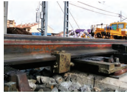
27. ábra. A csúcstípustalpa lengését csillapító készülék
