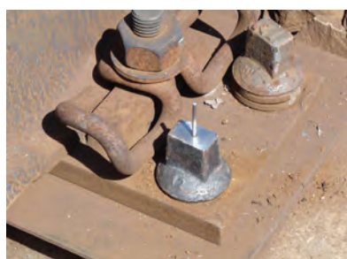
54. ábra. Speciálisan megmunkált KL síncsavar központosított tuskével
