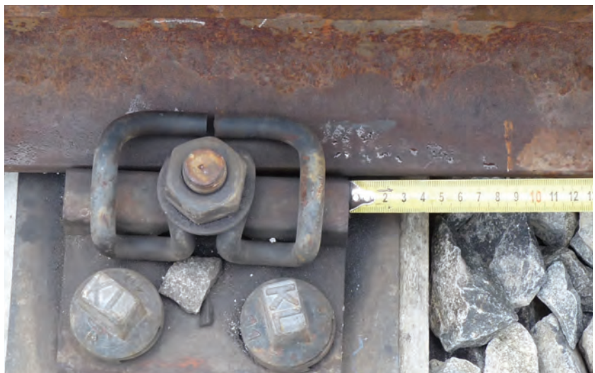
38. ábra. Elferdült vasbeton alj
