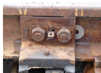
43. ábra. Tempflex típusú zárszerkezet öntvényházának bélelése
