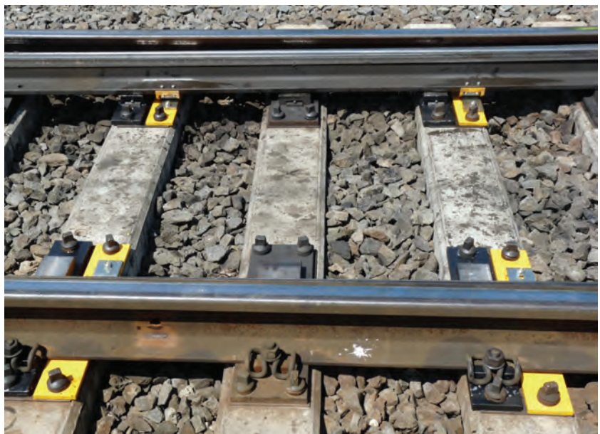
32. ábra. Sínszék mellé szerelt görgők
