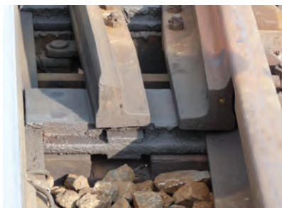
47. ábra. Görgők nélküli kitérő sínzéke
