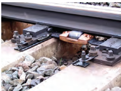
24. ábra. Austroroll (osztrák) csúcssíngörgő
