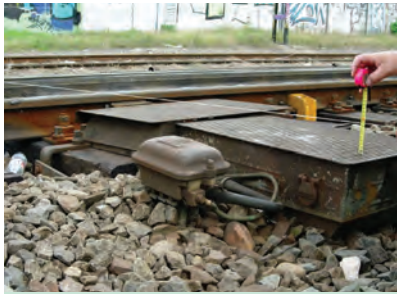
45. ábra. Ívesített kitérőre helytelenül felszerelt hajtómű
