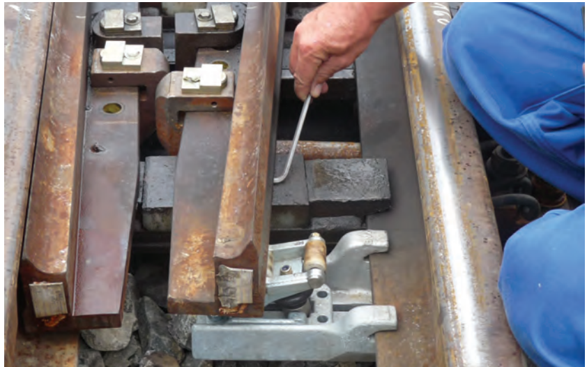
37. ábra. B 60 XIV. rendszerű kitérő középső csúcsúsnjei
