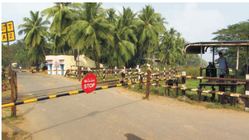
3. ábra. Biztosított szintbeni vasúti átjáró Indiában (Forrás: i.ytimg.com)
