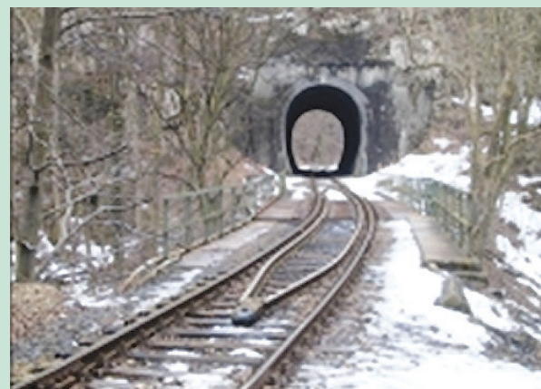
Az I. sz. alagút északi kapuzata, előtte a Gubányi Károly nevét viselő Cuha-patak-híd
