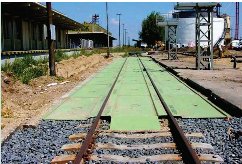
1. ábra. Green Track rendszer a beépítés után, Nagyigmánd – bioetanolgyár [6]
