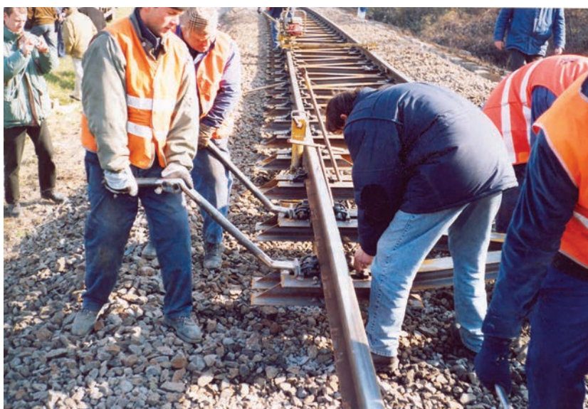
2. ábra. Y-aljak beépítése
