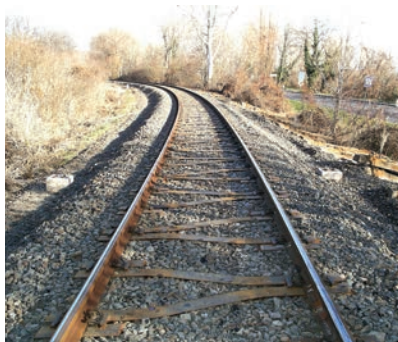
12. ábra: A vágány fényképe a beépítés után
