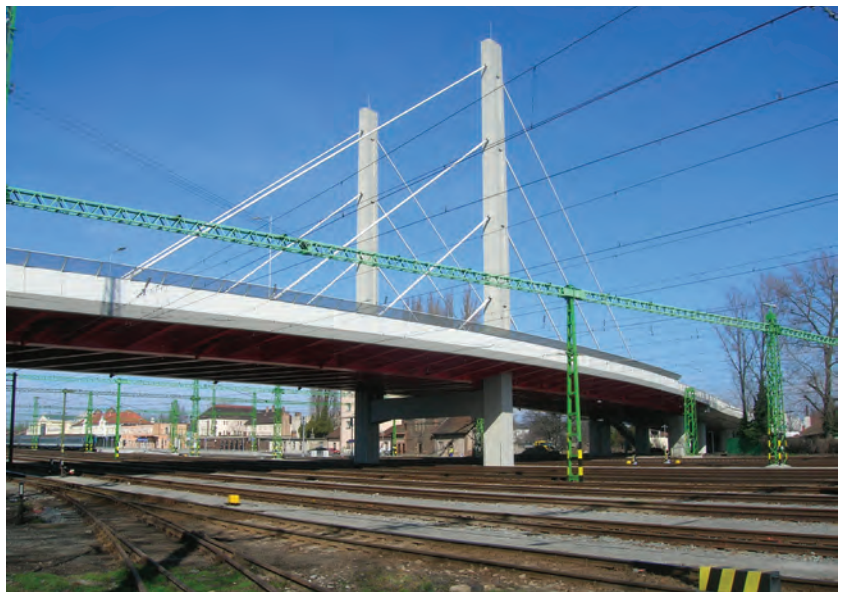
4. ábra. Az Orosházi úti ferde kábeles acélhíd
