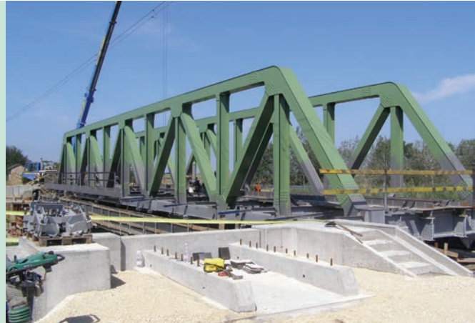
4. kép. Az Apavári híd új bordás kiegyenlítő lemeze (Fotó: Fülöp Zoltán)
