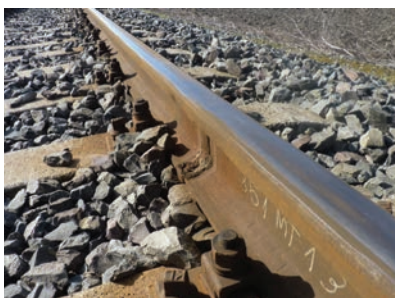
4. ábra. 106+75 jobb AT hegesztés más irányban fektetett síneknél
