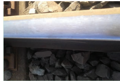
10. ábra. Leváló legyűrődés ívben
