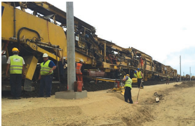
2. ábra. PM 200-2 alépítmény-javító géplánc átépítés közben
