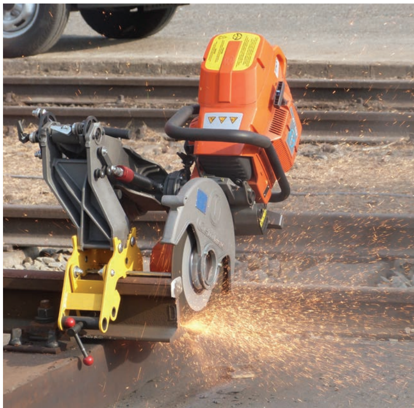
4. ábra. A sínvágó berendezés munka közben (Fotó: Bíró Sándor)
