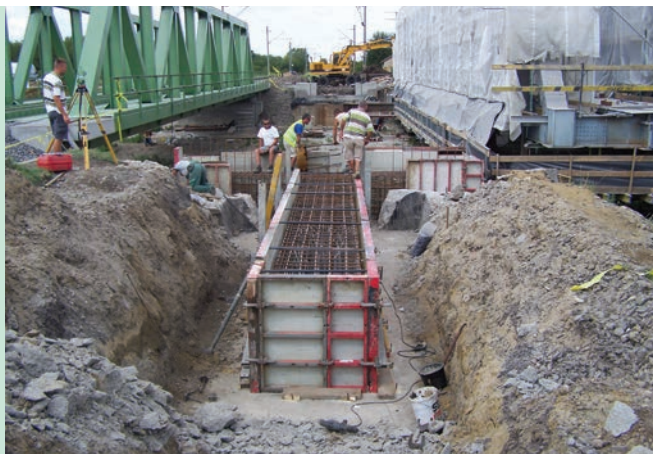
3. kép. Az Apavári híd kitolt állapotban és az új cölöp- összefogó gerenda (Fotó: Fülöp Zoltán)
