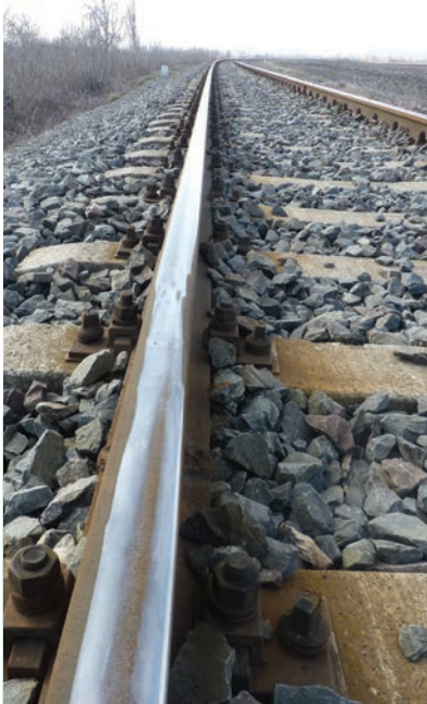
8. ábra. Hegesztésnél lemmunkált legyűrődés
