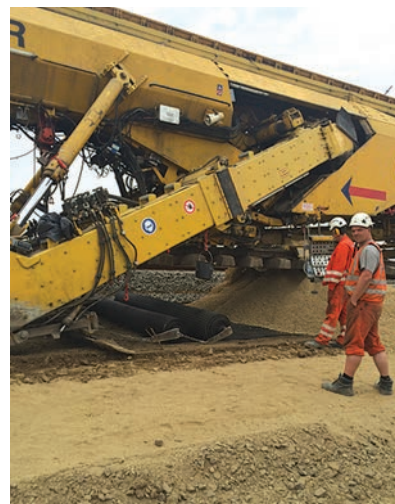
3. ábra. Geoműanyagok fektetése lavírsíkra
