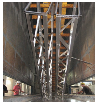
2. ábra. Rácsos oszlopszerkezet tűzihorganyzása
