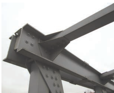
4. ábra. A tartószerkezeti elemek csavarozott kapcsolatai
