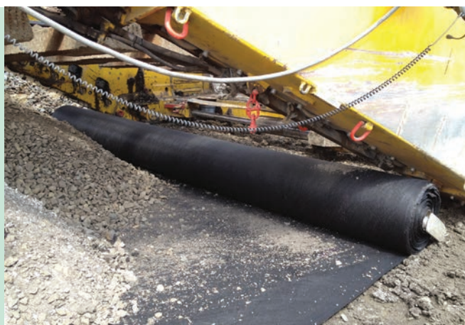
4. ábra. Nem szőtt geotextília beépítése
