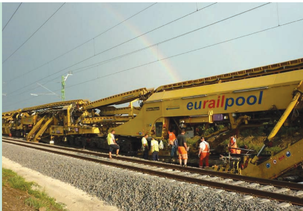
6. kép. Alépítmény- építő géplánc
