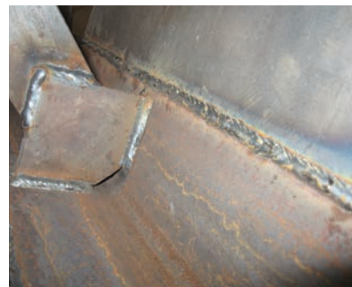
7. ábra. Bekötőlemez lesarkalása
