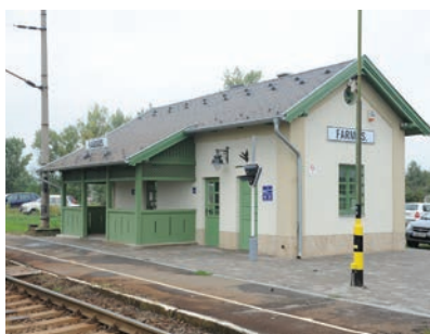
11. ábra. Farnos korhű stílusban felújított felvételi épülete
