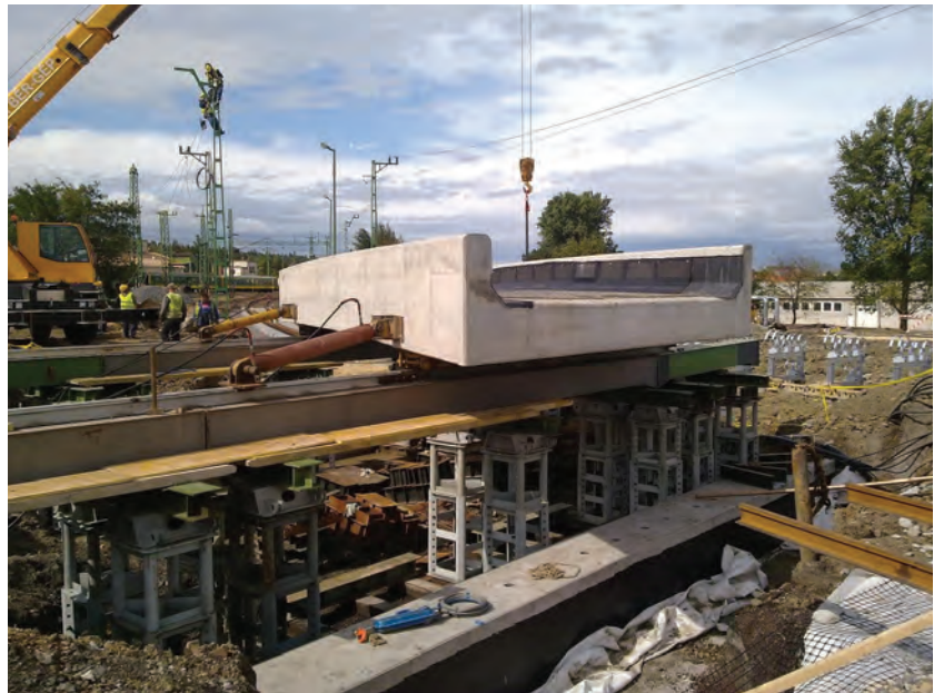
2. kép. A Kőszegi úti csomópont műtárgy építése Sopronban
