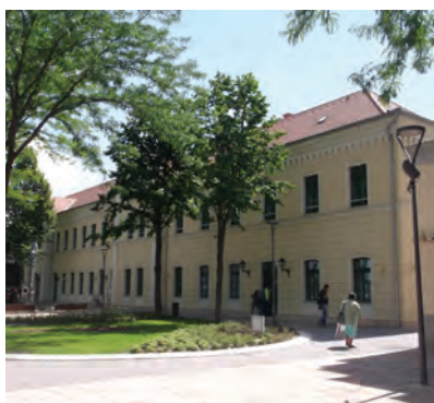
5. kép. A felújítás utáni homlokzat a város felől
