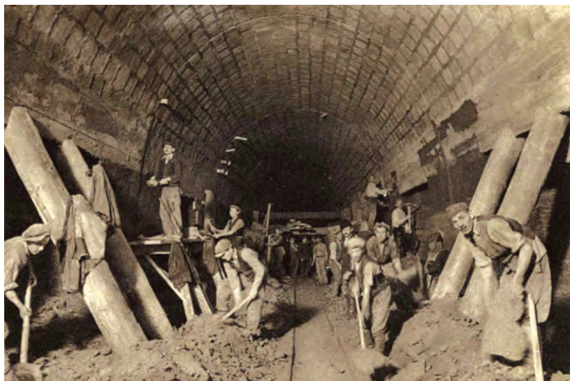
9. ábra. A nagyalagút építése belga rendszerrel [2]
