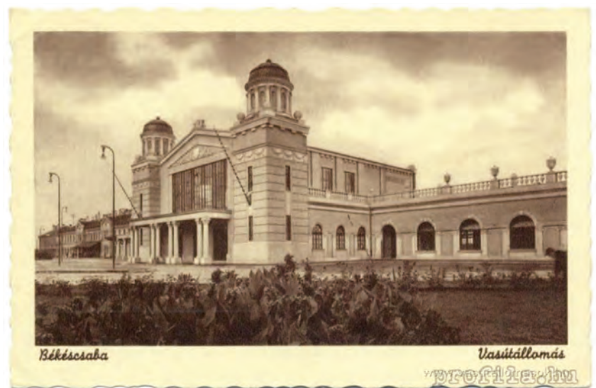
3. kép. A háború után újjáépült felvételi épület a déli pavilonnal a város felől
