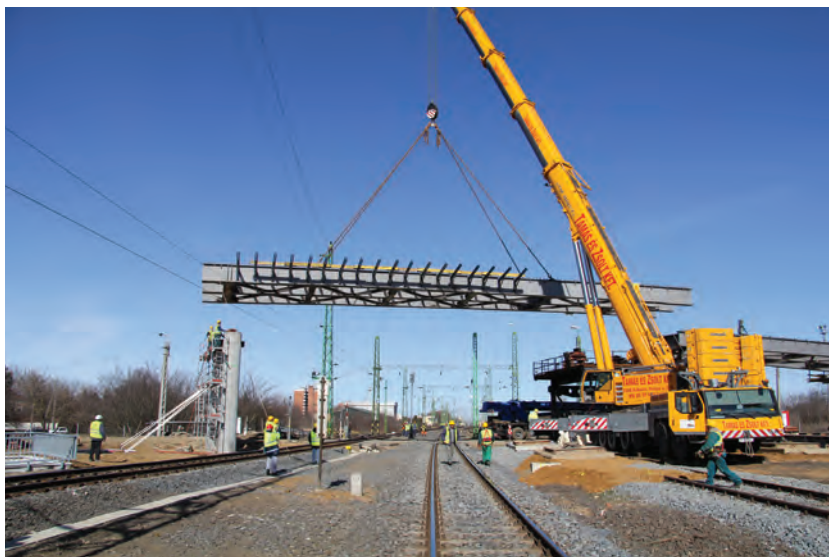
1. kép. A Csaba utcai felüljáró építése Szombathelyen (Fotó: Maller László)
