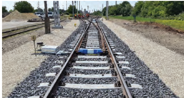
8. kép. Kitérőcsere a PFT Csorna II., GYV SZ, hidász szakaszok kivitelezésében
