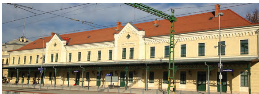
7. kép. A felújított homlokzat a vágányok felől
