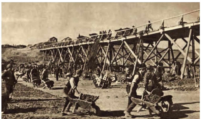
7. ábra. Töltésépítés csillével és talicskával [2]
