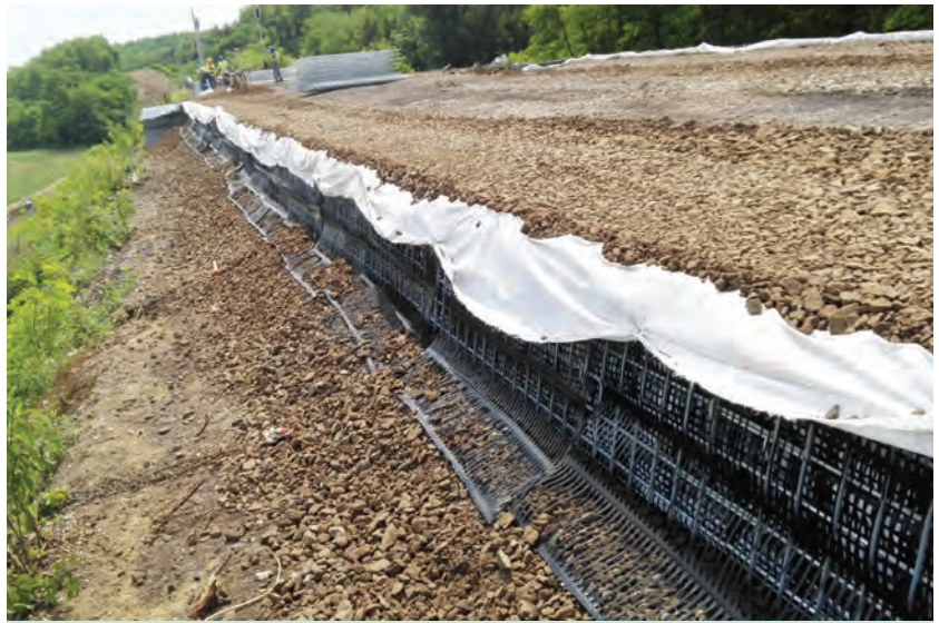
6. kép. Gradex padka építése Vasvár és Pácsony között
