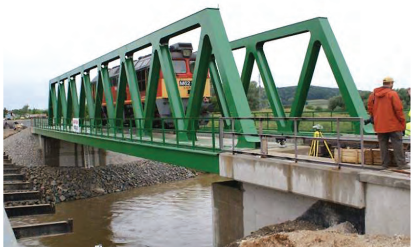
3. kép. A Lapincs-híd próbaterhelése
