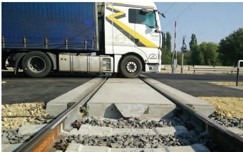
5. kép. Szálerősített elemekkel kialakított vasúti átjáró (Fotó: Nagy József)
