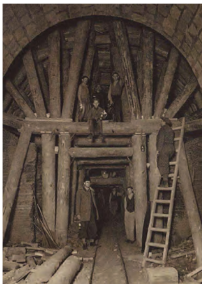
8. ábra. A nagyalagút építése osztrák rendszerrel [2]
