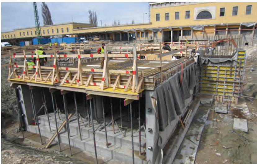
19. kép. Az új utasaluljáró építése (Fotó: Simon Ferenc)
