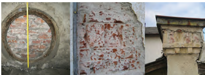
9. ábra. Feltárt, cson- kolt dísztéglalízénák, szerkezeti elemek (Fotó: Pálinkás Ferenc)
