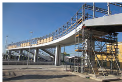
12. kép. Intermodális csomópont gyalogos-felüljáró első ütemének építése (Fotó: Simon Ferenc)
