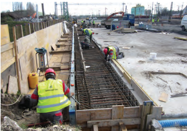
10. kép. A Széchenyi úti műtárgy felszerkezetének szélesítése (Fotó: Simon Ferenc)
