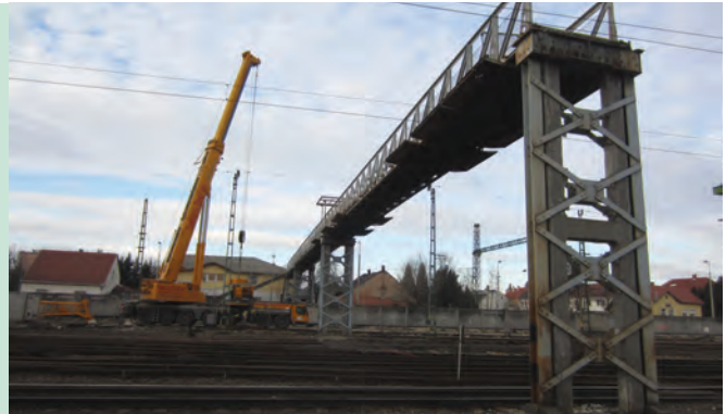
5. kép. Gépész gya- logos-felül- járó bontása (Fotó: Szőke Ferenc)
