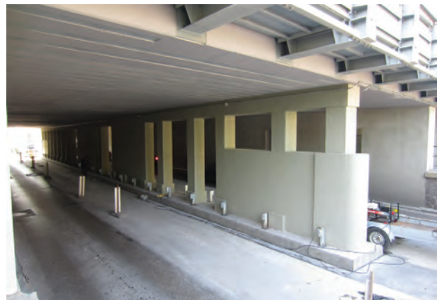
11. kép. A Széchenyi úti műtárgy felújítása a pillérek megerősítésével (Fotó: Simon Ferenc)
