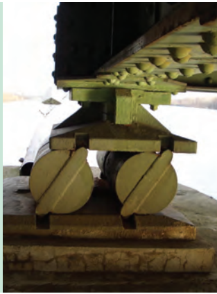
11. ábra. A kremsi Duna- híd középső mederpillérének tönkremenetele
