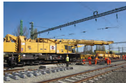
2. kép. Vasbeton aljas kitérő beépítése az állomás végponti oldalán (Fotó: Simon Ferenc)
