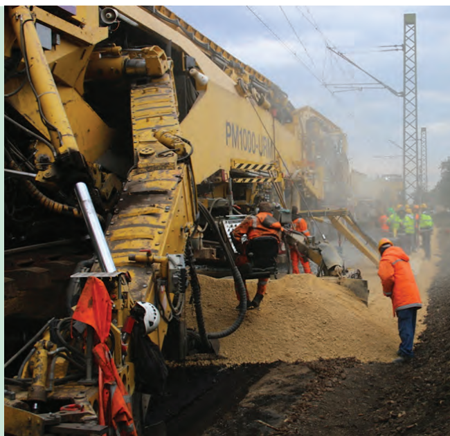
7. kép. PM1000-URM az alépitmé- nyi anyag beépítése közben
