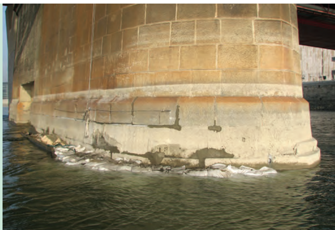
5. ábra. Az ürege- sedés meg- szüntetése utáni állapot a budapesti Összekötő vasúti híd V. számú pillérére
