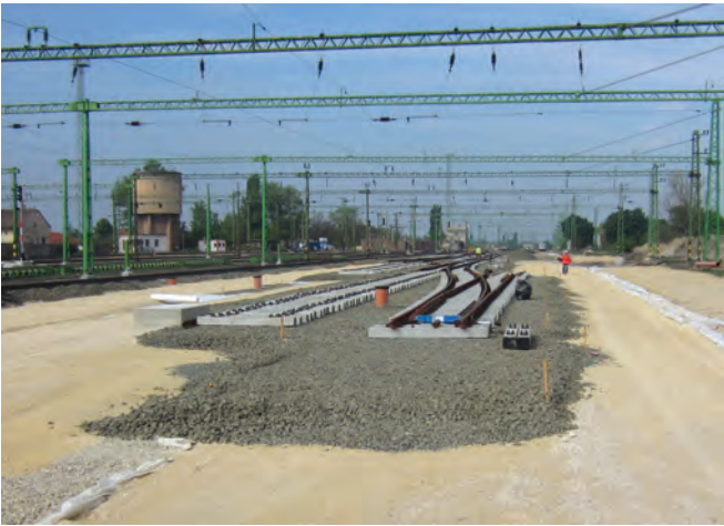
15. kép. Beépített védőréteg az állomás végponti oldalán (Fotó: Simon Ferenc)
