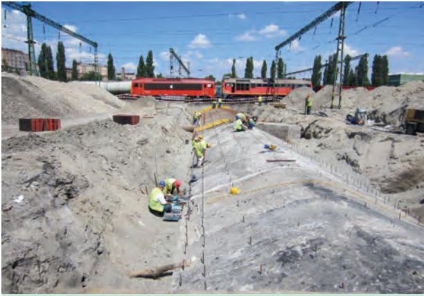
8. kép. Az Aszalvölgyi árok műtárgy szigetelése (Fotó: Simon Ferenc)
