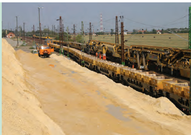
6. kép. Beépítésre váró alépit- ményi anyag
