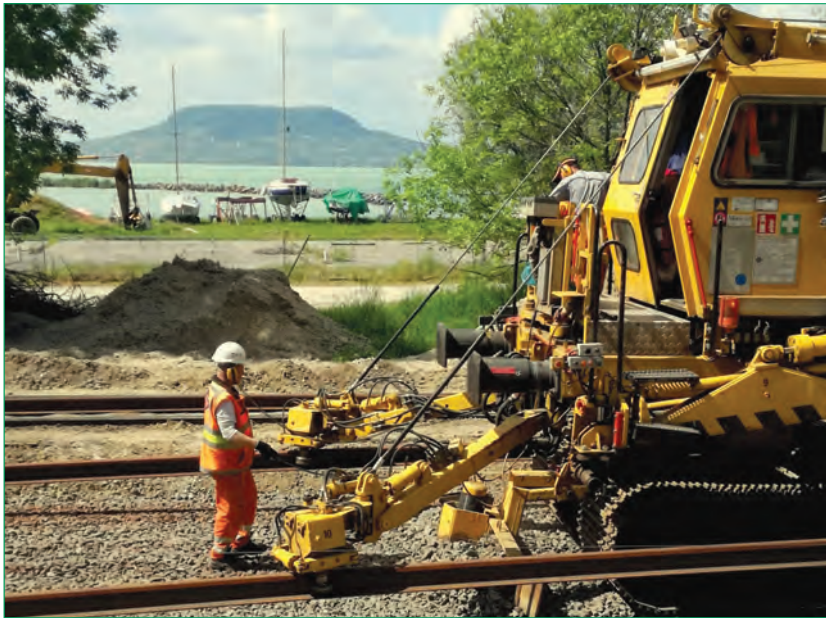
9. ábra. Vágányfektetés a dél-balatoni vasútvonalon (Fotó: Eller Balázs)
