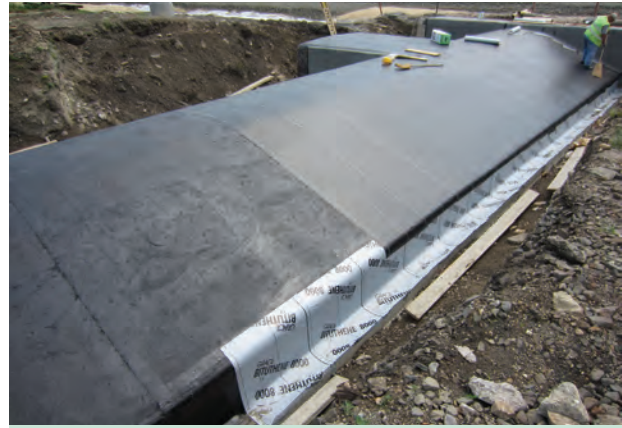
9. kép. Az Aszalvölgyi árok műtárgy boltozati rész megerősítése (Fotó: Simon Ferenc)
