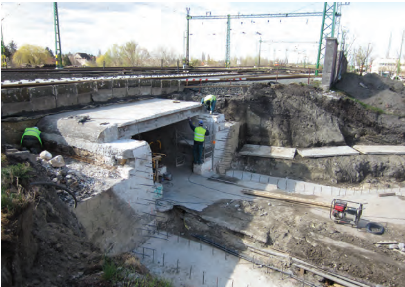
20. kép. A Hosszúsétatéri gyalogos-aluljáró felújítása (Fotó: Simon Ferenc)
