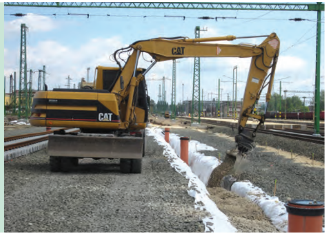
3. kép. Szivárgó építése (Fotó: Simon Ferenc)
