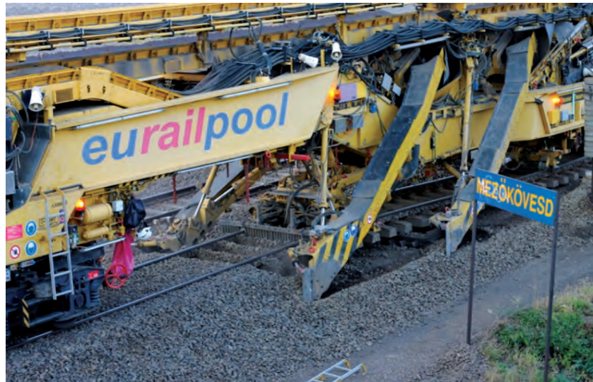
2. kép. Munkában a PM1000-URM alépítmény-cserélő járműszerelvény
