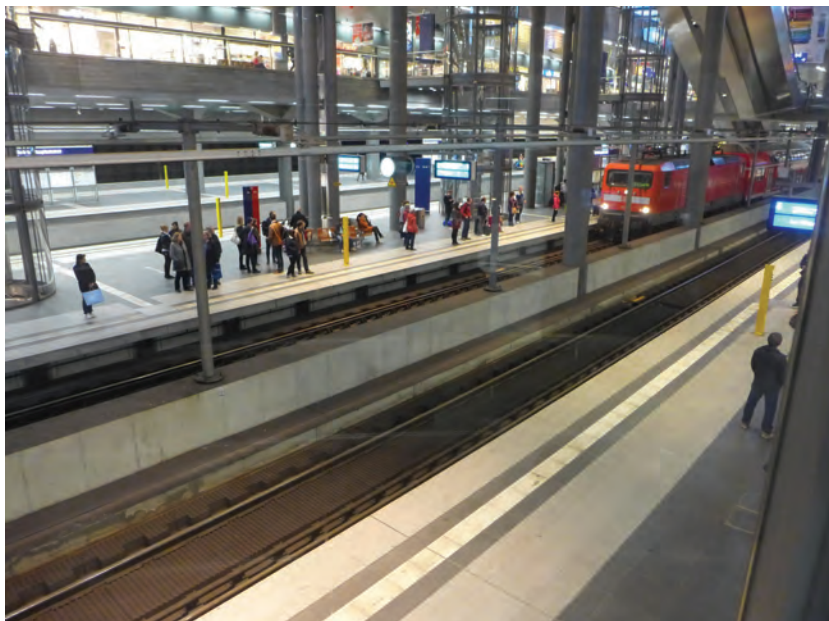
1. kép. Berlin, Hauptbahnhof – az állomás új típusú városi helyet hozott létre, ahol a közlekedési és a kereskedelmi funkciók szervesen összeépülnek
