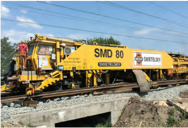
15. ábra. Felépítménycsere az SMD-80 géplánccal (Fotó: Balogh Péter)
