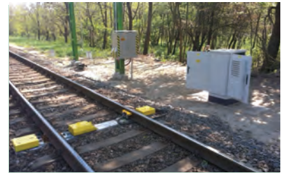
1. kép. A vágányba épített érzékelők és a pálya mellé telepített SCT terminál
