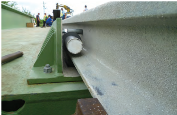
13. ábra. A tapadó híddal ellátott síncsatorna- és sínfelület, távtartókkal és alátétekkel kiszabályozott sínszalak a rugalmas kiöntés előtt (Fotó: Balogh Péter)
