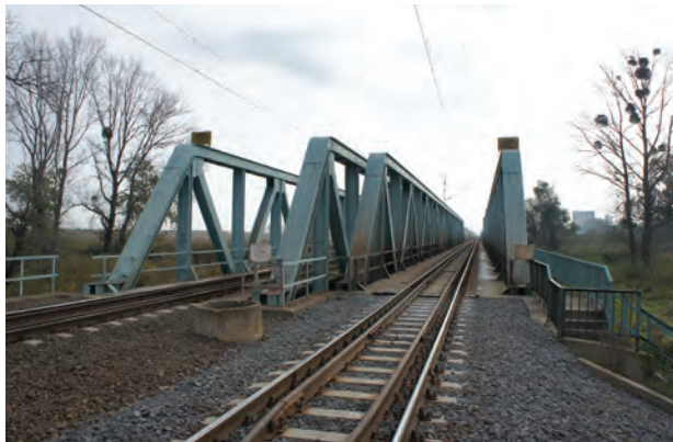
8. ábra. A Budapest-Keleti–Szerencs vasútvonal 1949+72 szelvényben lévő kétvágányú, 109,36 m össznnyílású böcsi Hernád-híd (Fotó: Frigyk Bence)
