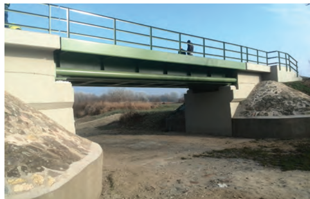
12. ábra. A Szerencs–Hidasnémeti vasútvonal 492+61 szelvényében lévő Hernád ártéri híd az átépítés után (Fotó: Balogh Péter)
