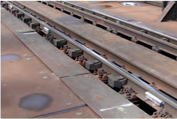
9. ábra. A tengelyterhelés-mérő szenzor telepítése
