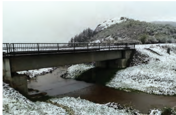
9. ábra. A Kisterenye–Kál-Kápolna vasútvonal 254+67 szelvényében lévő, 15,60 m nyílású utófeszített, recski vasbeton Tarna-híd (Fotó: Balogh Péter)
