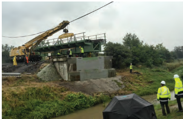
14. ábra. A Tolcsva-patak hídjának felújítás utáni beemelése (Fotó: Balogh Péter)
