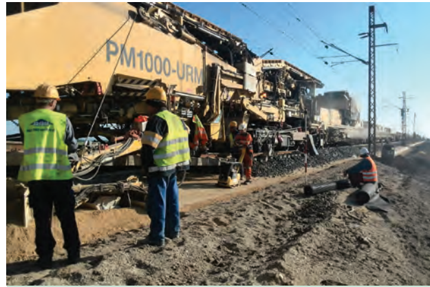
16. ábra. Alépítmény-átépítés a PM-1000 géplánccal (Fotó: Balogh Péter)
