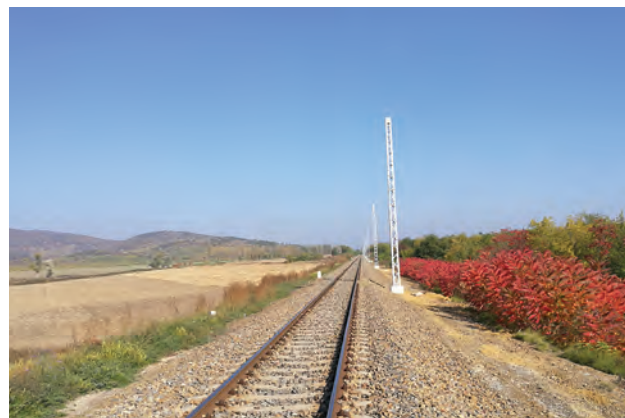
18. ábra. Az átépített vágány az elhelyezett felsővezeték-tartó oszlopokkal (Fotó: Balogh Péter)
