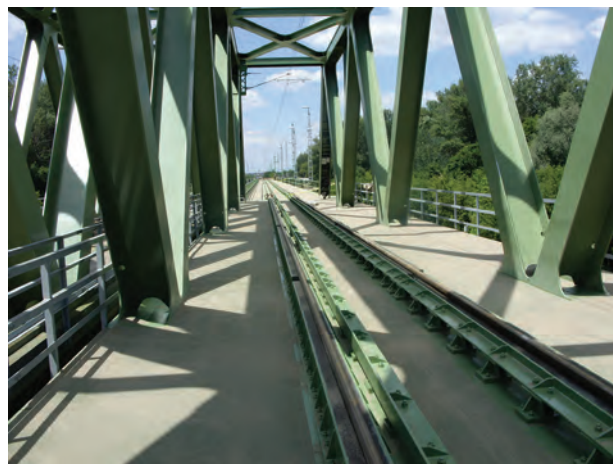
21. ábra. Az átépített szolnoki Tisza-híd Edilon felépítmény-nyel (Fotó: Tóth József)
