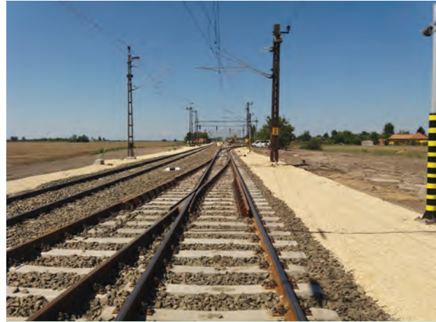
15. ábra. Tápiógyörgye állomás átépítés után (Fotó: Móró Gyula András)
