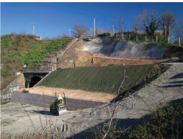
24. ábra. A Déli pályaudvar–Kelenföld közötti alagútnál a megcsúszott részű helyreállítása (Fotó: Szánthó Géza)
