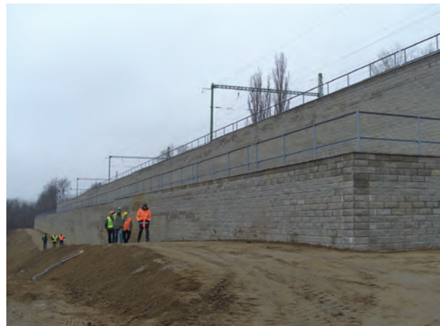
25. ábra. A Vác–Verőce állomásközben megépített töltéstámasztó súlytámfal (Fotó: Pokorny Bence)
