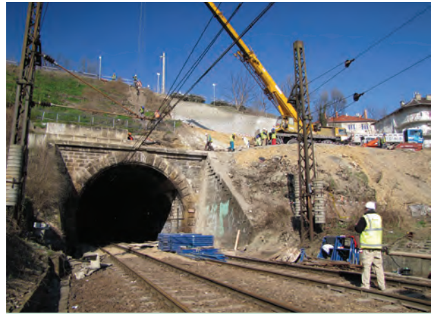
23. ábra. A Déli pályaudvar–Kelenföld közötti alagútnál a megcsúszott részű helyreállításának megkezdése (Fotó: Szánthó Géza)
