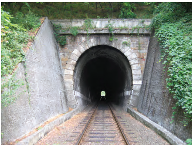
20. ábra. A Becskei alagút (Fotó: Szánthó Géza)
