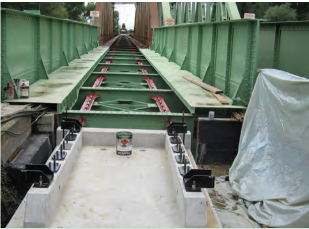
22. ábra. Kiegyenlítőlemez beépítése a Rába-híd hídfőjénél (Fotó: Farkas József)
