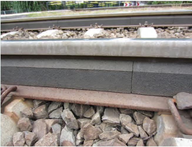
8. ábra. Singerincre ragasztott zajcsökkentő elem Velence– Velencefűdő megállóhe- lyek között (Fotó: Bíró Sándor)
