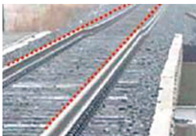
2. ábra. Süllyedés a hídfő környezetében
