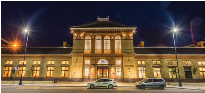
5. ábra. Kaposvár felvételi épületének város felőli homlokzata
