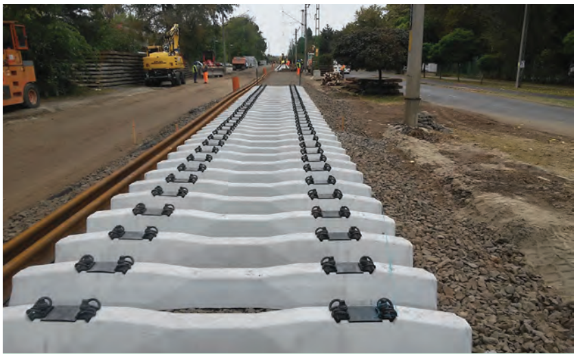
5. ábra. Pályaépítés Balatonlelle felsőn földmunkás technológiával (Fotó: Szigethy Tamás)
