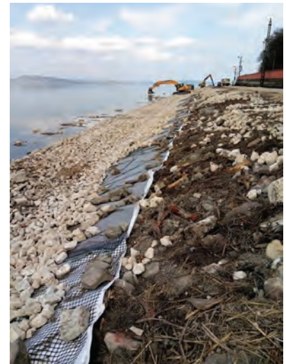
8. ábra. Bélatelep – hullámtörő építése (Fotó: Szigethy Tamás)
