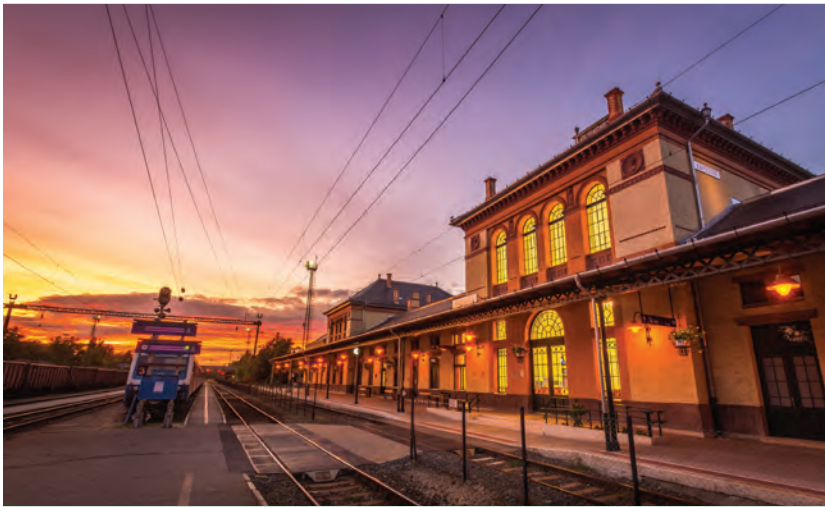
4. ábra. Kaposvár felvételi épületének vágányok felőli homlokzata
