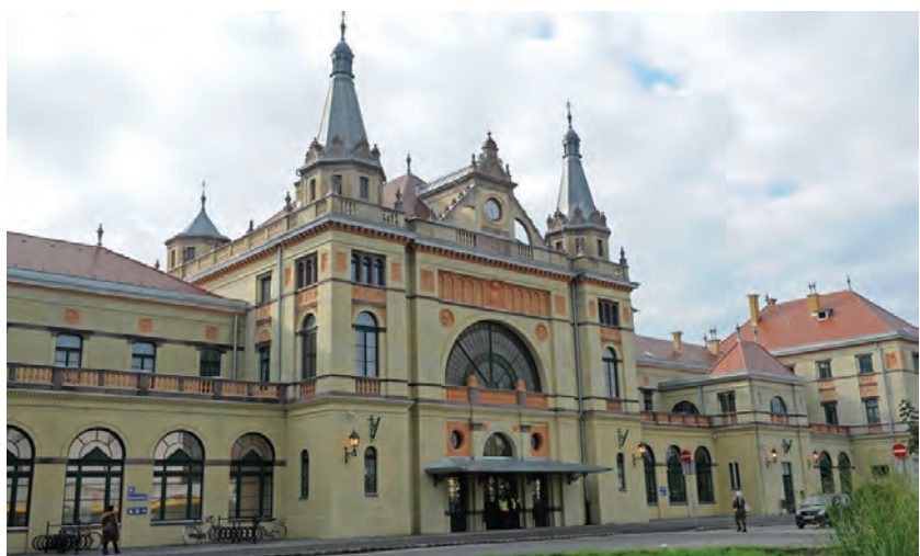
3. ábra. Pécs felvételi épületének város felőli homlokzata
