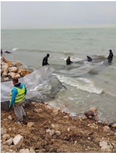
10. ábra. Búvárok fektetik a georácsot a partvédmű építésekor (Fotó: Puch Ferenc)
