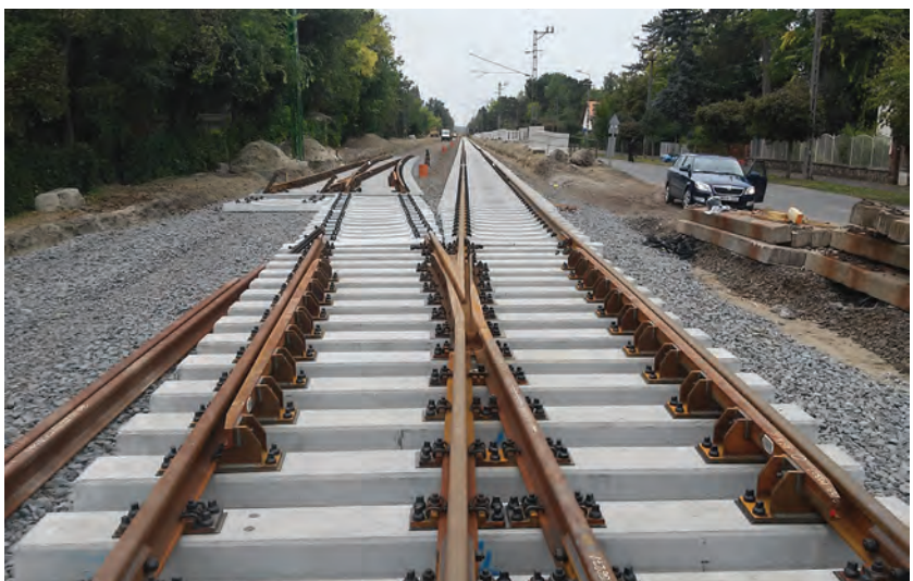
6. ábra. Beton-aljas kitérő helyben fektetése (Fotó: Szigethy Tamás)
