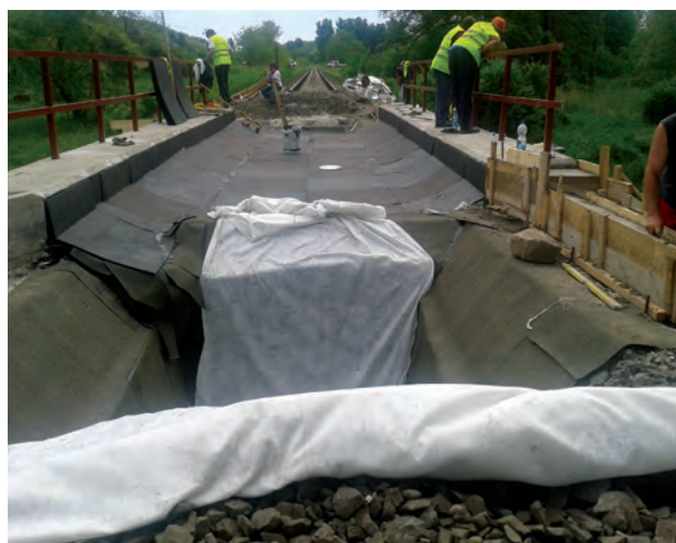
3. ábra. Servidek-Servipak szigetelési rendszer alkalmazása
