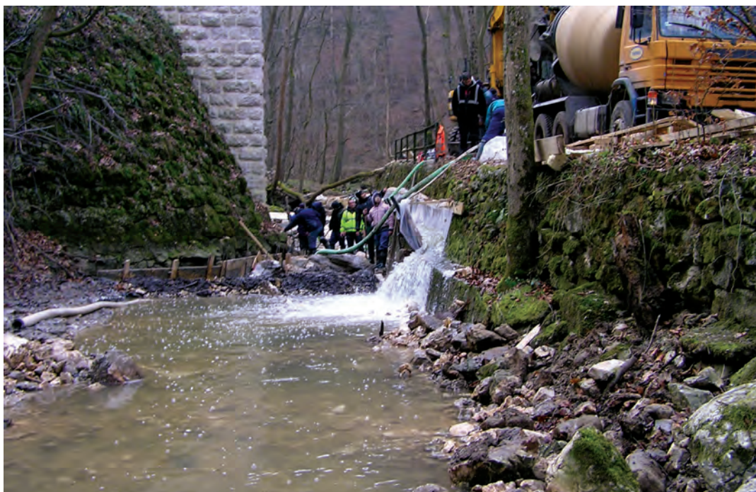
11. ábra. Cuha patak, támfal alá- betonozása
