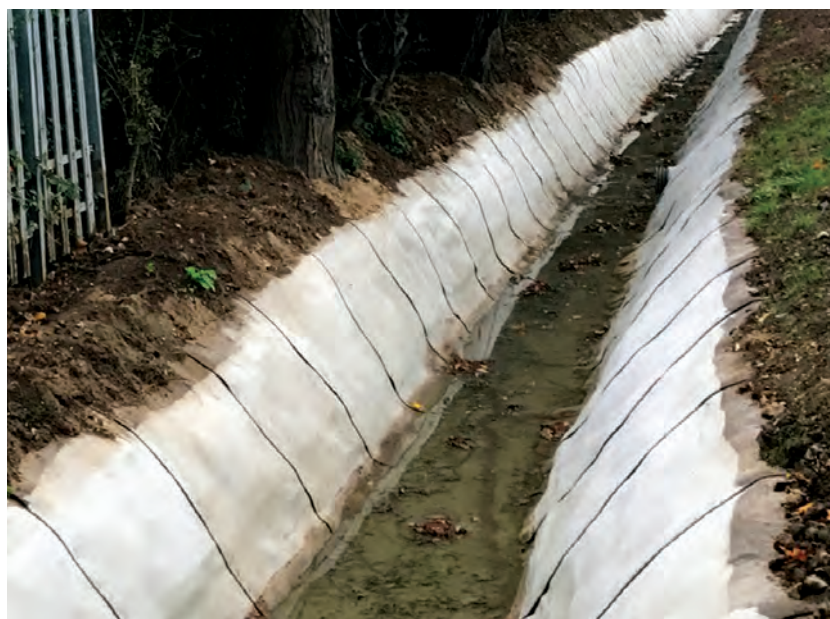
2. ábra. Concrete Canvasszal burkolt árok (Fotó: SoDeGo Ltd.)
