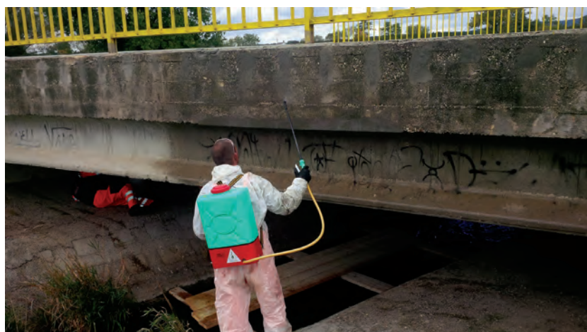
3. ábra. TPS II felhordása háti permetezővel (Fotó: Bánhegyi-Nagy István)
