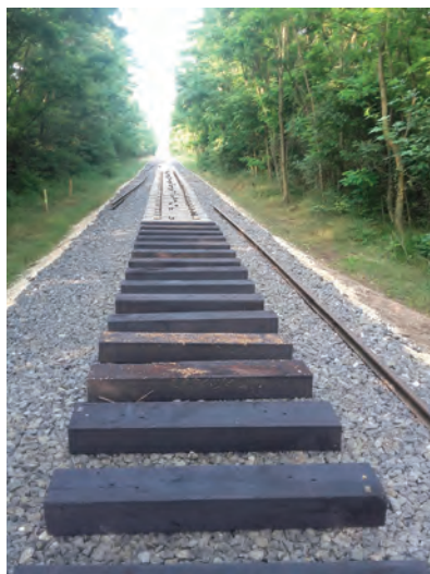
4. ábra. Alfektetés az ágyazaton
