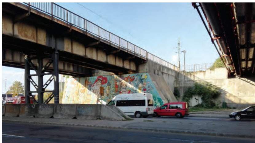
3. ábra. A budai hídfő korábban átalakított hídfője
