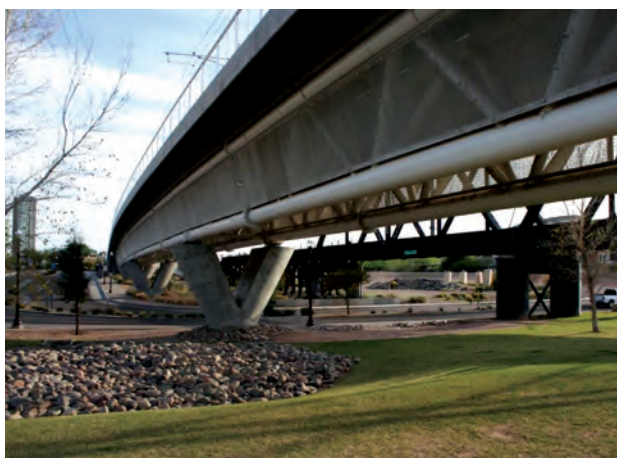
20. ábra. Tempe Town Lake Metro híd [24]
