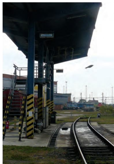
1. ábra. Üzemanyagtöltő kút vasbeton tálccával (Fotó: Tóth András)
