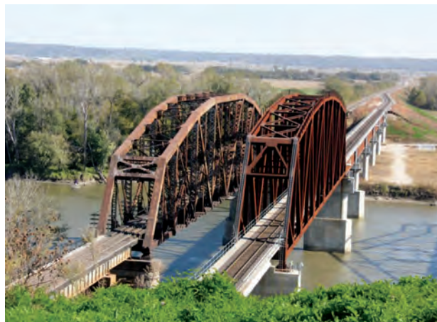
19. ábra. Plattsmouth vasúti híd [23]
