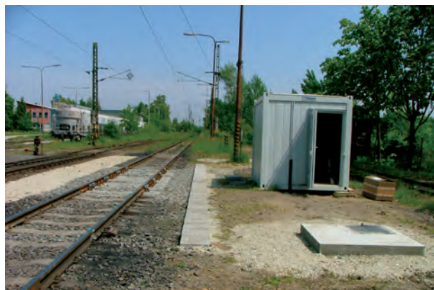
15. ábra. ARDIN típusú statikus, dinamikus elektronikus vasúti járműmérleg (Fotó: Alkér András)
