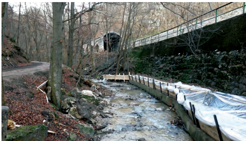
2. kép. A 410–413 hm-szelvények közötti támfal felújítás közben, háttérben a galéria (Fotó: Bach László)
