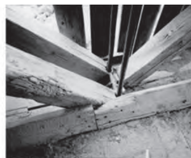
6. ábra. Tipikus Howe-féle kialakítás: 1857-ben átadott közúti híd (Au Sable folyó, Jay, New York) [7]
