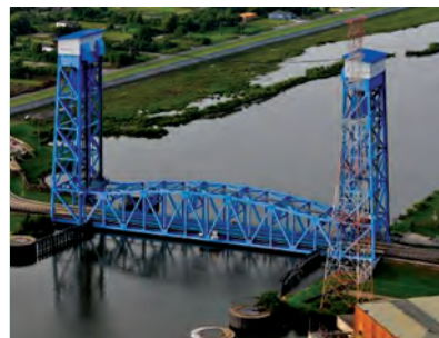
24. ábra. Florida Avenue híd, Louisiana, New Orleans [28]
