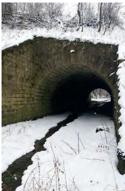
5. kép. A 607/08 hm-szelvényben, műemléki környezetben lévő, 6,00 m nyílású boltozat
