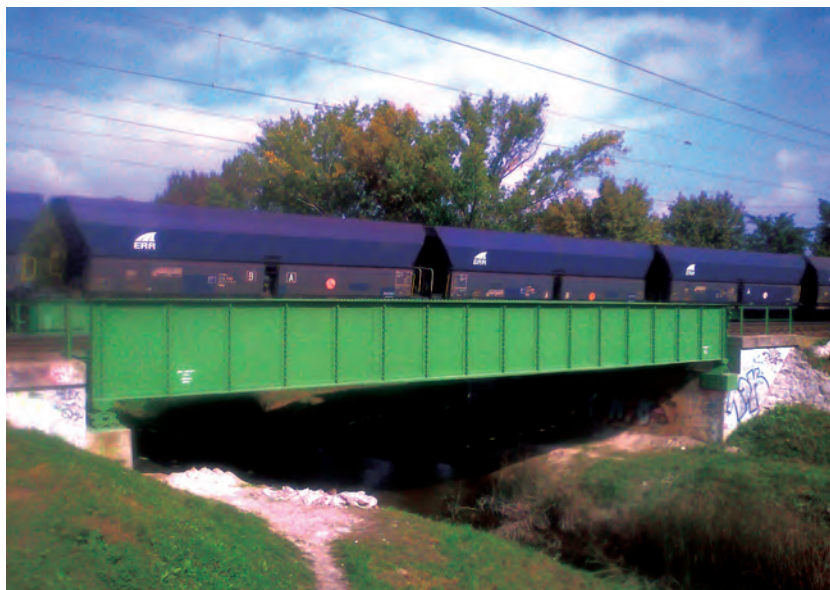
9. ábra. Heréd patak, gerinclemezes vasúti híd korrózióvédelem után
