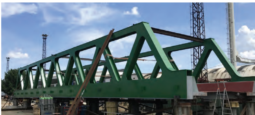
14. ábra. Az elkészült hídszerkezet
