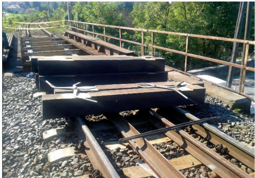
6. ábra. Az előzetesen megmunkált hídfák a végleges beépítés előtt
