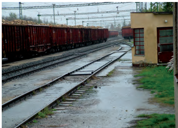
11. ábra. Egyaknás, vágánymegszakítás nélküli vasúti jármű- mérleg (Fotó: Erdődi László Zoltán)
