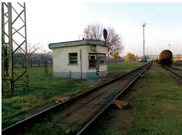
12. ábra. Ikeraknás, vágánymegszakításos vasúti jármű- mérleg (Fotó: Erdődi László Zoltán)
