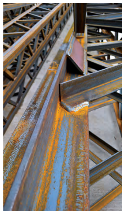
6. kép. Nincs technológiai rész, a termék így nem horganyozható
