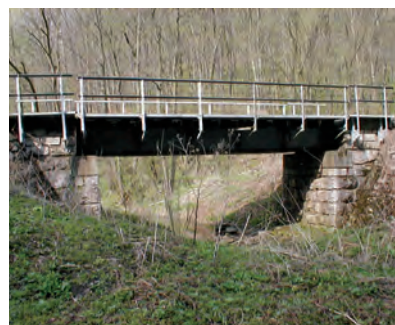
7. kép. A 460/61 hm-szelvényben található, átépítésre váró, szegecselt acélszerkezetű Cuha-híd
