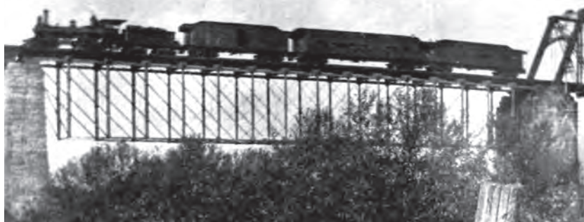
13. ábra. A Parkersburg vasúti híd [17]
