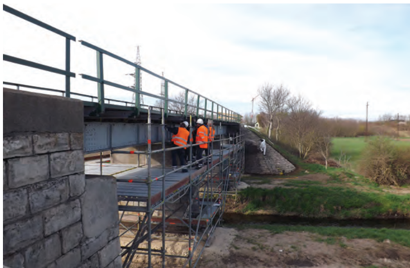
5. ábra. Az Ikva patak hídjának felújítása
