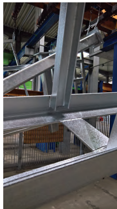
4. kép. Az U szelvényes rácsrúd csatlakozása az L acél főszárhoz
