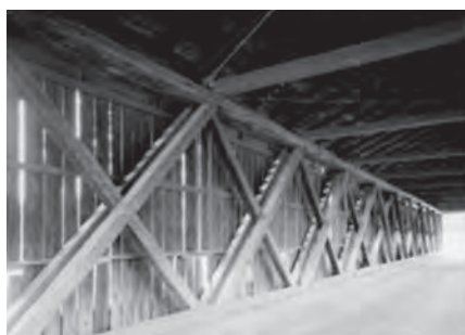
6. ábra. Tipikus Howe-féle kialakítás: 1857-ben átadott közúti híd (Au Sable folyó, Jay, New York) [7]
