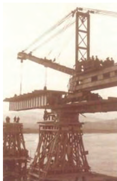
5. kép. A szükséghíd építése 1945 tavaszán
