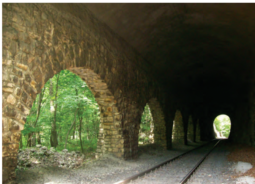
1. kép. Sziklafogó galéria a II. számú alagút folytatásában (Fotó: Radvánszky Réka)
