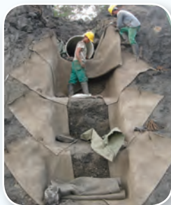
2. kép. A betonpaplan flexibilitása
