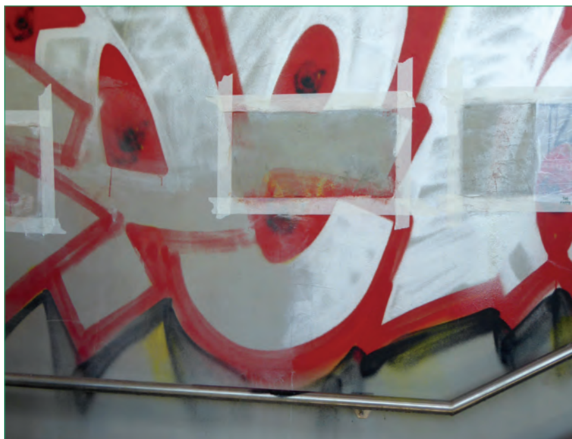
6. ábra. Peelaway paszta használat közben
