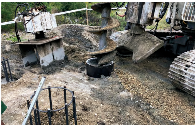
2. ábra. A próbacölöpözés
