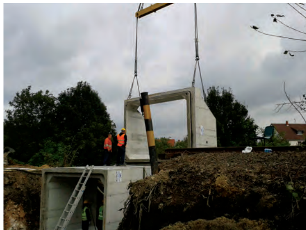
5. ábra. A kerethídépítésnél a fejelem beemelése
