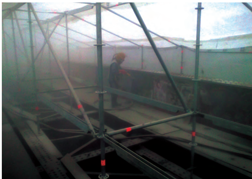
8. ábra. Heréd patak, gerinclemezes vasúti híd homokszórása
