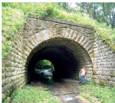
6. kép. Csőáteresz kifolyási oldala a Cuha-völgyi szakaszon
