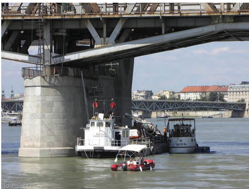
A meglévő Déli összekötő vasúti Duna-híd pillérjavítási munkái 2012-ben (Fotó: Gyukics Péter)
