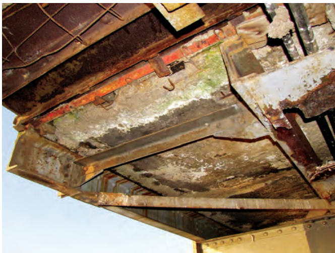
15. kép. Sérült járda- elem a budai parti közút felett
