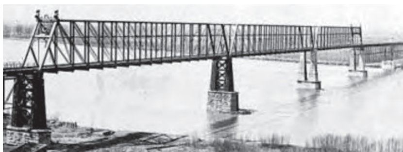
17. ábra. Glasgow vasúti híd [21]
