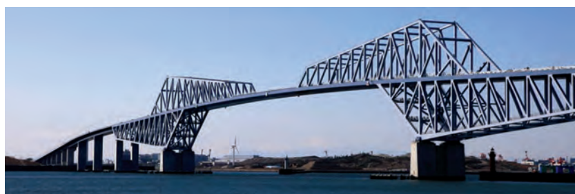
1. ábra. A Tokyo Gate Bridge oldalnézete – BHS500 és BHS700 anyagból készült [1]
