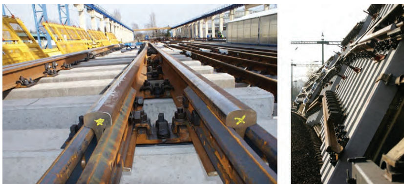
5. ábra. Előszerelés és szállítás ferde szállítókocsin
