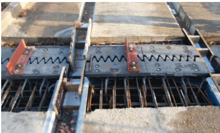
11. ábra. Az új fésűs dilatáció beépítése
