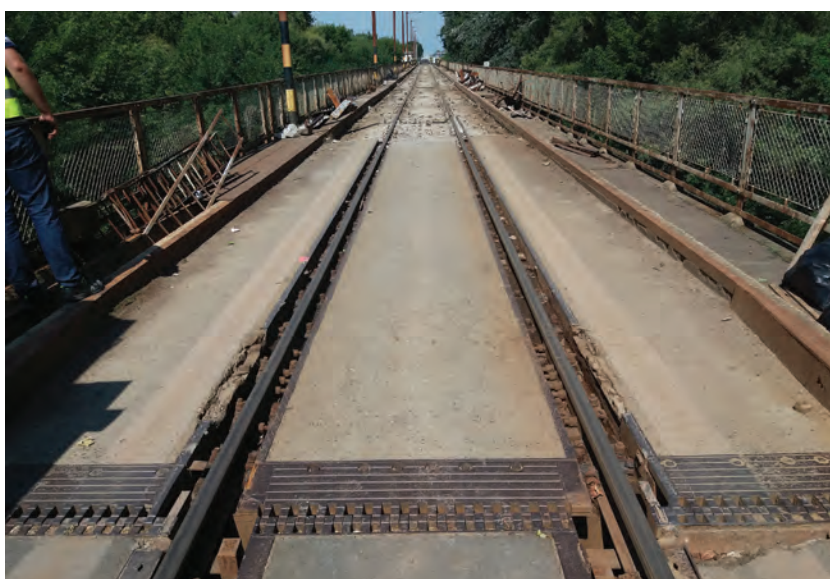
7. ábra. A tönkrement régi fésűs dilatáció
