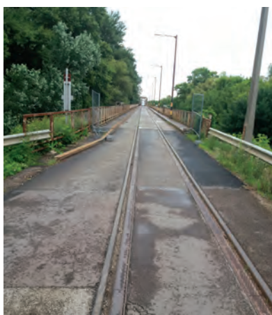
5. ábra. Kisköre felőli út csatlakozás
