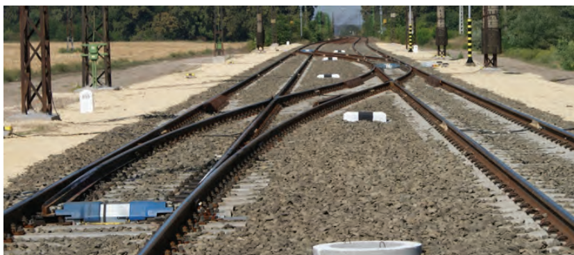
7. ábra. Az új kitérők a beépítés után
