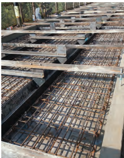
10. ábra. A pályalemez betonozásra előkészítve (ártéri szerkezet)
