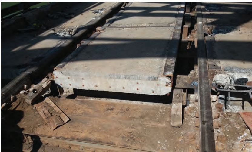
8. ábra. Pályatábla darabolása a mederszerkezeten
