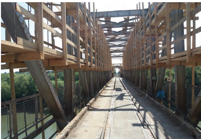
16. ábra. Állványerdő a korrózióvédelemhez
