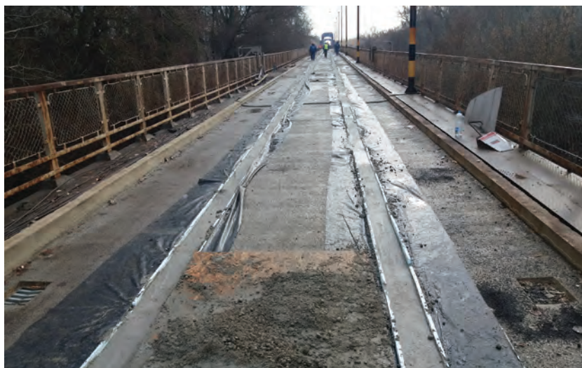
14. ábra. Az ideiglenesen kibetonozott síncsatorna
