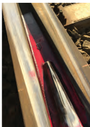
17. ábra. Repedésjavítás feltöltő hegesztéssel a 8. számú kitérőben
