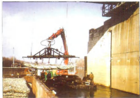
Csongrádi Tisza-híd pillérbiztosítási munkái
