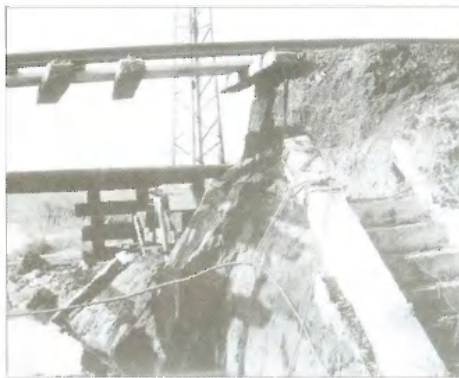
10. ábra. Vasúti pálya alól elmosott híd (Sajó ártér, 1974)
