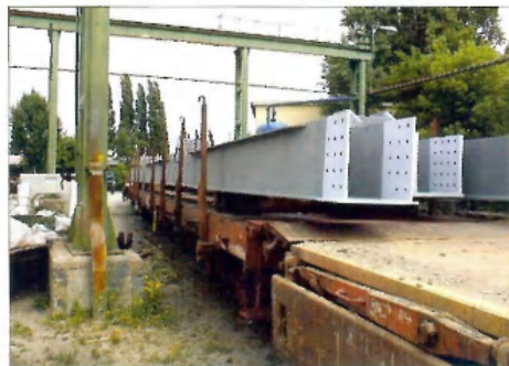
3. kép. Vagonba rakott főtartó felsőövek
