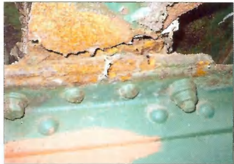
Teljes keresztmetszetű átrozsdásodás
