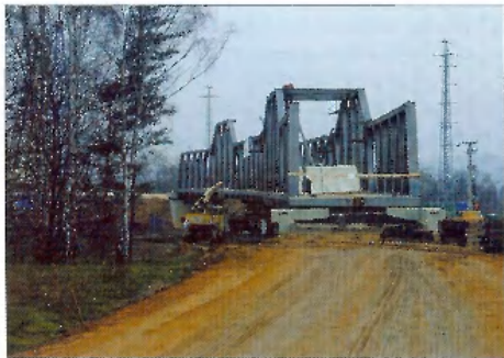
1. ábra. A csaknem elkészült híd
