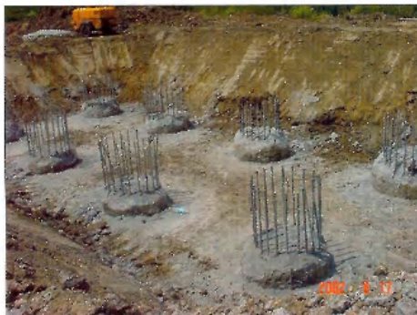
6. ábra. A 3. j. pillér visszavésett SOIL-MEC cölöpjei
