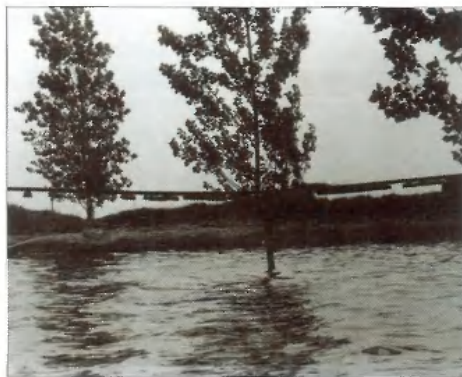
6. ábra. Elmosott vasúti töltés (1974)
