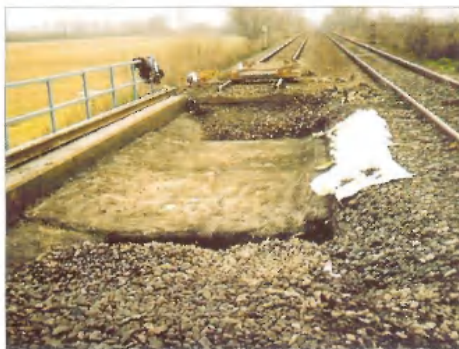
7. ábra. Ágyazati anyag elbontása a jobb vágányban
