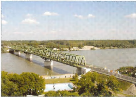
3. kép. A dunaföldvári Duna-híd látképe
