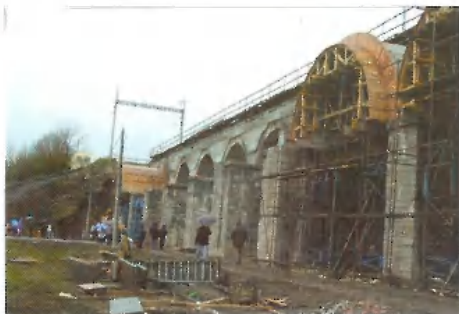
4. ábra. Jazernice viadukt felújítása vasbeton nyereggel (Csehország)
