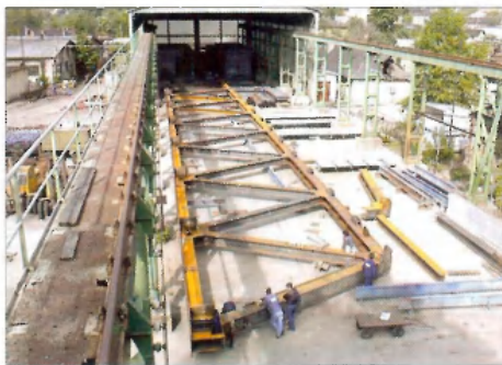
2. kép. Mederszerkezet főtartójának próbaszerelése
