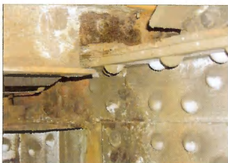
A szolnoki Tisza-híd erős, de még teherbírást nem befolyásoló korróziós károsodása
