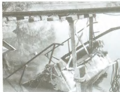
12. ábra. Vasúti pálya alátámasztó műtárgy nélkül (1974)
