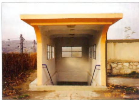
Alsógalla MÁV aluljáró felújított épülete
