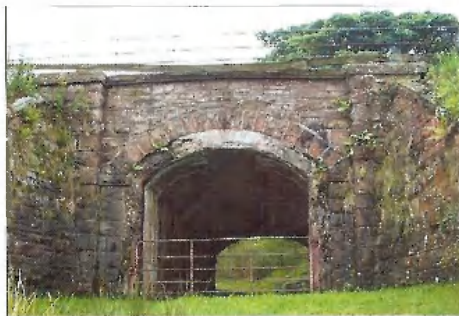
5. ábra. Megerősítés „vastag” vasbeton kéreggel. (Angol – baloldali és magyar – jobboldali példa)
