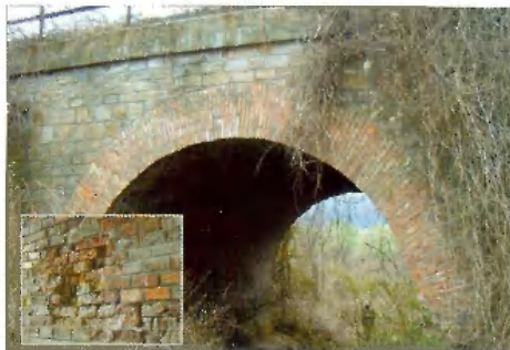
10. ábra. 5,70 m nyílású boltozott híd felújítása, 2002. (Kivitelező: Vertikor-Alpin Kft.) a) Felújítás előtt . b) Felújítás után
