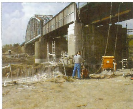
15. ábra. Alámosás veszélyes támasz megerősítése
