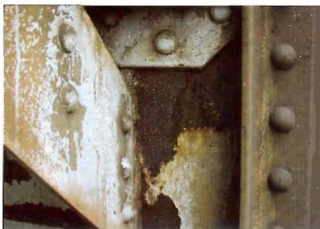
A szolnoki Tisza-híd erős, de még teherbírást nem befolyásoló korróziós károsodása
