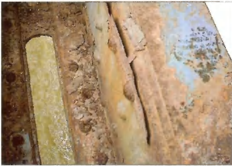
Gubacsi úti Duna öbölgyi híd korróziós károsodása
