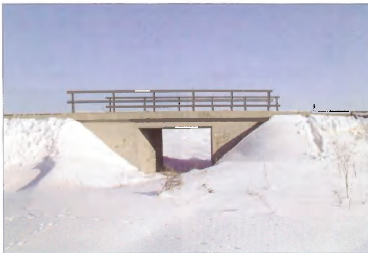
11. ábra. 2003. februári télben a Kisvasút kótaji teknőhídja...
