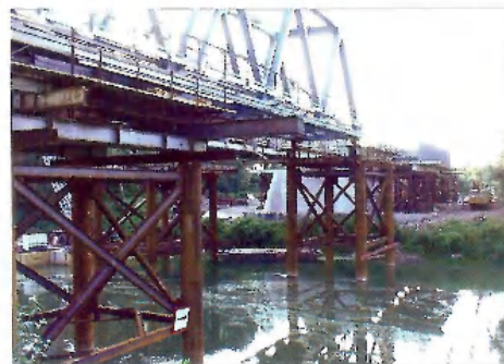
6. kép. „8b” és „9a” jelű mederjáromok a hosszirányú betolás folyamán
