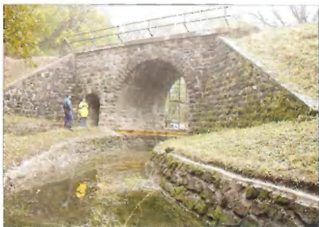
Berkenye vasúti alagút felújítás előtt
