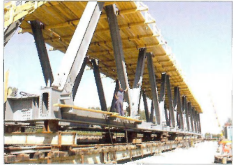
7. kép. Mederszerkezet szerelése a szerelőtéren
