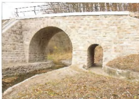
Berkenye vasúti alagút felújítás után
