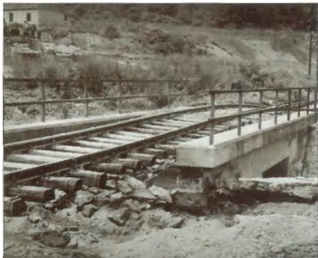
4. ábra Bükkösd-patak egyik hídjánál történt pályaelmosás (1967)
