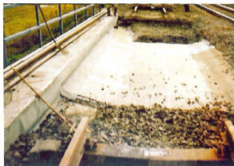
6. ábra. A beépített szigetelés a jobb vágányban
