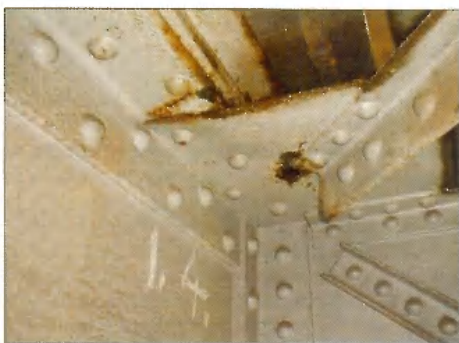
A szolnoki Tisza-híd erős, de még teherbírást nem befolyásoló korróziós károsodása
