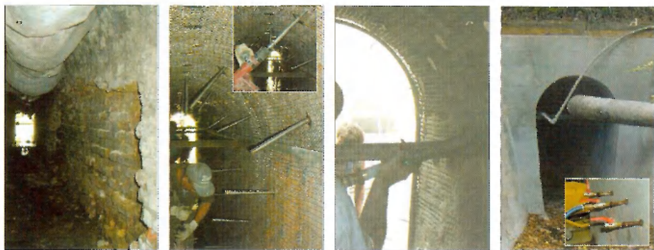
12. ábra. 1,20 m nyílású boltozott átéres felújítása, 2002. (Kivitelező: Vertikor-Alpin Kft.) a) Felújítás előtt b) Horgonyok elhelyezése c) Lőttbetonozás d) Injektálás, kész állapot
