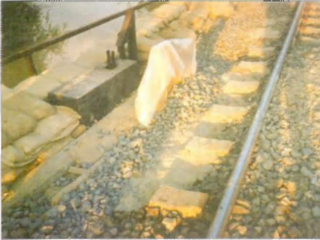
16. ábra. 6 m-es fényőpallók, fólia és homok zsákok zárják el a víz útját
