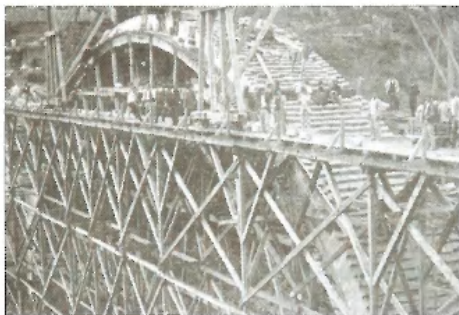
1. ábra. Boltozott viadukt építése (Franciaország)
