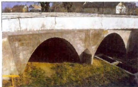
1. kép. A solti Monier-rendszerű vasbeton boltozat
