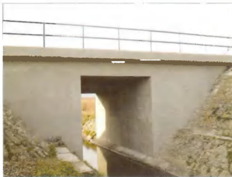
9. ábra. A 2657+14 szelvényben lévő teknőhid külső felújított felülete
