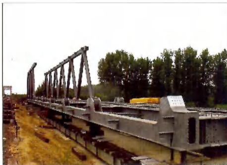
4. kép. A mederszerkezet helyszíni szerelése
