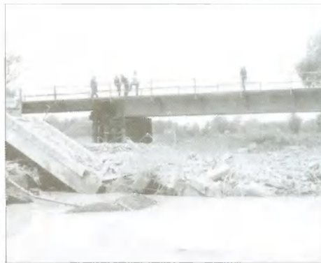
11. ábra. Az árvízűl összenyomott tekinőtűd maradványa
