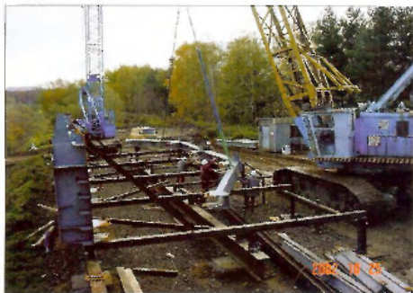
14. ábra. A kiéltetett szakasz gyártásának befejezése a helyszínen
