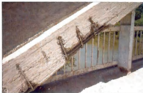
2. kép. Vasbeton ív korróziós károsodása
