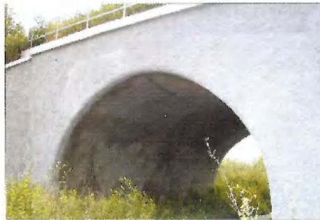
5. ábra. Megerősítés „vastag” vasbeton kéreggel. (Angol – baloldali és magyar – jobboldali példa)
