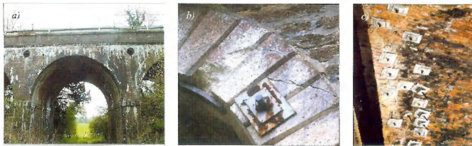
6. ábra. A keresztirányú (térbeli) merevség biztosítása feszítő elemekkel.
