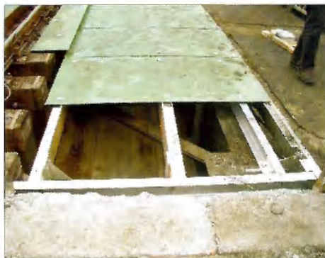
13. ábra. A műanyag járólemez beépítése
