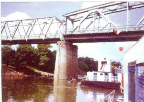
Algyői Tisza-híd pillérbiztosítási munkái
