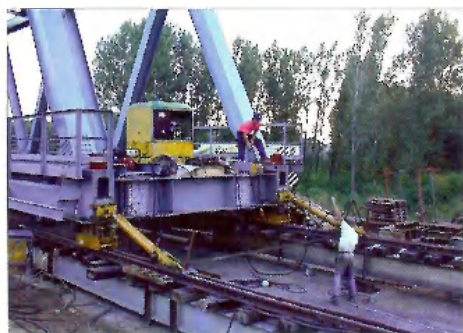
5. kép. Mederszerkezet hosszirányú betolása
