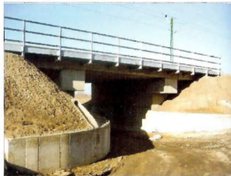
10. ábra. Átépített híd fényképe
