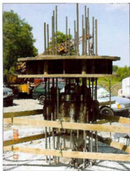
5. ábra. Próbacölöpözés
