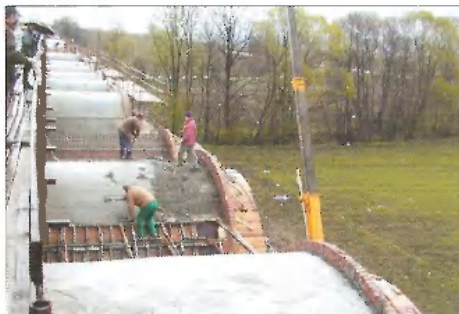
4. ábra. Jazernice viadukt felújítása vasbeton nyereggel (Csehország)
