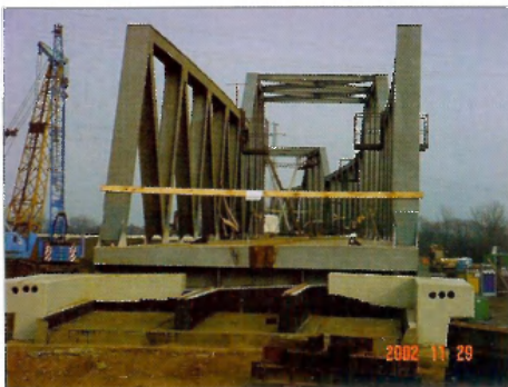
3. ábra. Íves, nyitott, részben zárt keresztmetszetű felszerkezet
