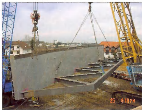
9. ábra. Egy hidvégi szerelési egység leemelése a trailerről
