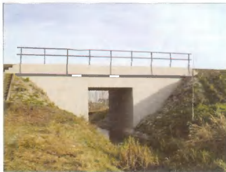
10. ábra. A szelvényezés szerinti bal oldali külső felületének betonvédelme
