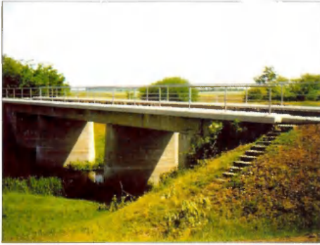
2. ábra. 172+68 szelvényben lévő teknőhid a helyreállítás után
