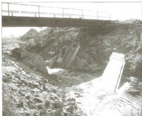
2. ábra. Átszakadt árvízvédelmi töltés miatti teknőhid elmosás
