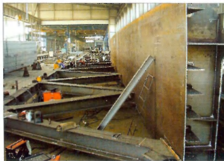
13. ábra. A rácsostartó szereléséhez oldalára fordított pályaszerkezet a pályalemezen átbújtatott csomólemezekkel
