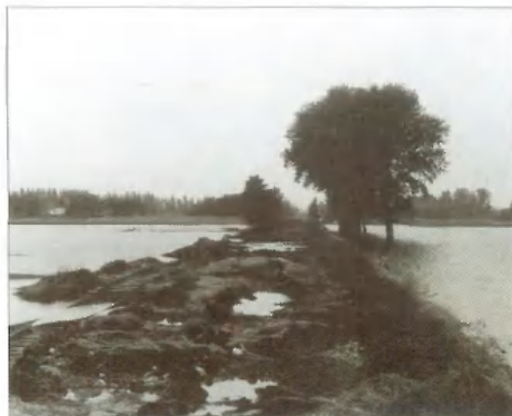
5. ábra Elmosott, nyomvonalból eltolt vasúti pálya (1974)
