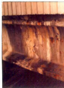
3. kép. Előregyártott szélső híderenda korróziós károsodása
