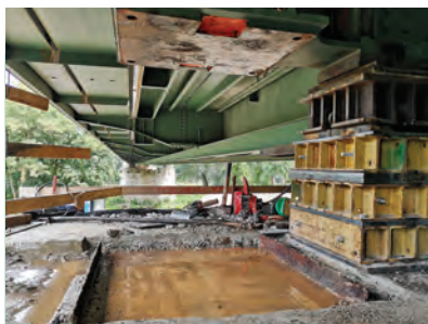
2. ábra. A sarucseréhez kiemelt szerkezet
