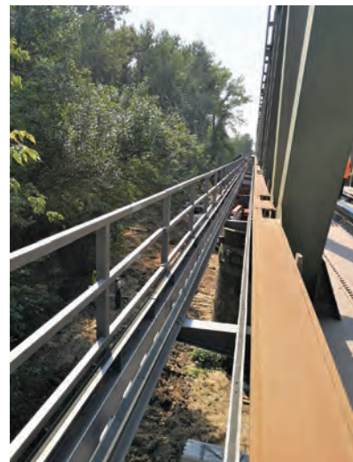
6. ábra. Gyalogjárakonzol szerelése
