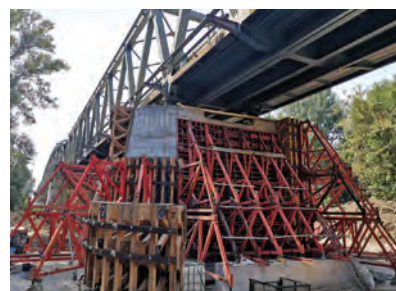
4. ábra. A IV. pillér köpenyezési munkái
