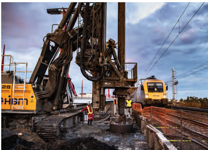
2. ábra. A hídfő cölöpözése
