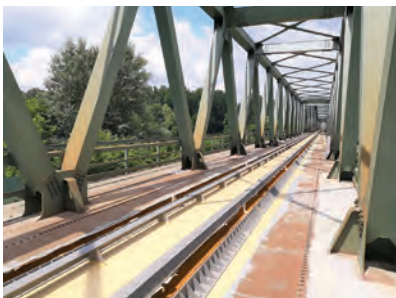
5. ábra. Edilon vályúk a híd pályalemezén
