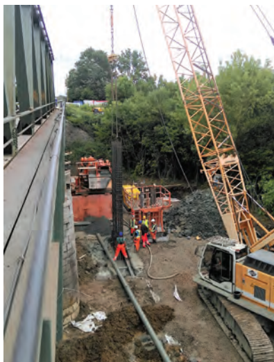
3. ábra. Részfaltábla armatúrájának elhelyezése
