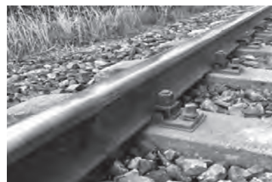
4. ábra. A hosszú hullám [2]
