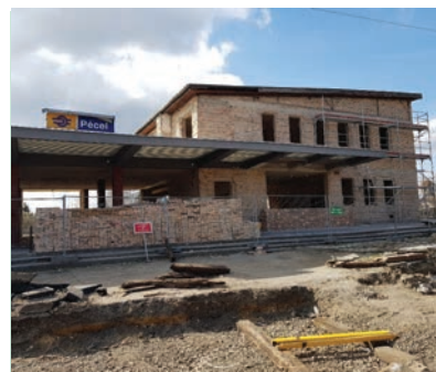
12. ábra. Pécel állomás felvételi épületének felújítása (Fotó: Török Gergely)
