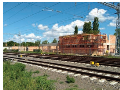
13. ábra. Aszód Pft. és biztosítóberendezési szakasz épülete (Fotó: Bencsik András)
