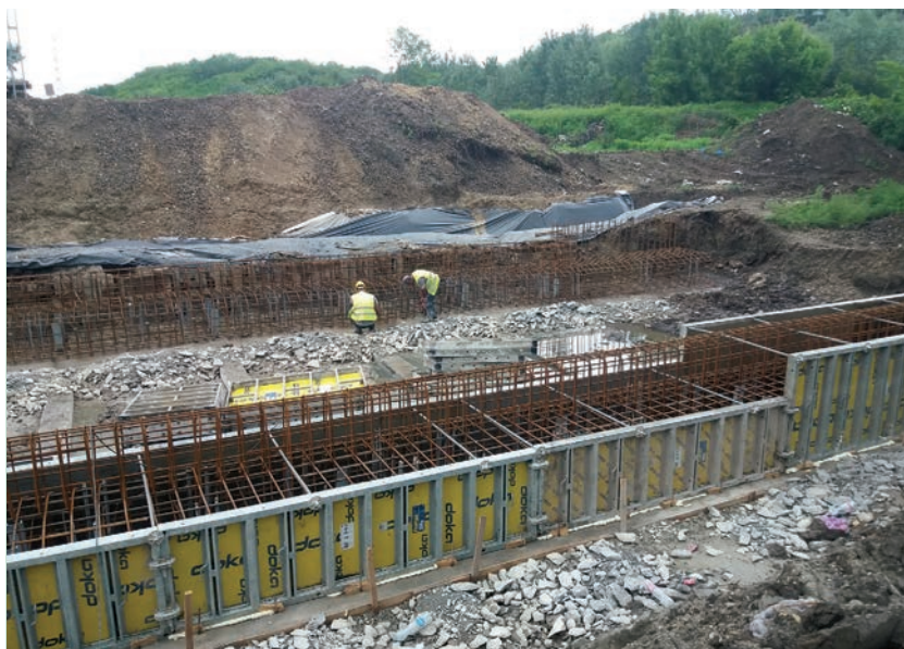
8. ábra. Hídépítés Pécel–Isaszeg között a 218+45 szelvényben (Fotó: Apró Márton)
