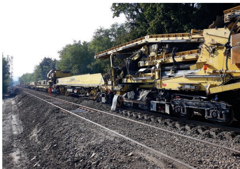
3. ábra. PM 1000 URM munkagép Pécel–Isaszeg között (Fotó: Jäger Dávid)
