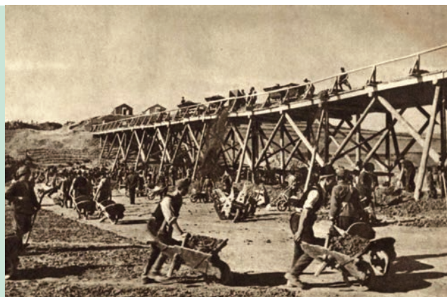
6. ábra. Vasúti töltés- építés döntő- állványokról Szeretfalva- Déda között
