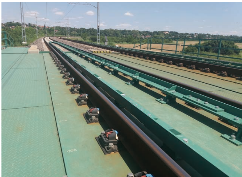
5. ábra. A Galgapatak felsőpályás acélhídja (Fotó: Apró Márton)
