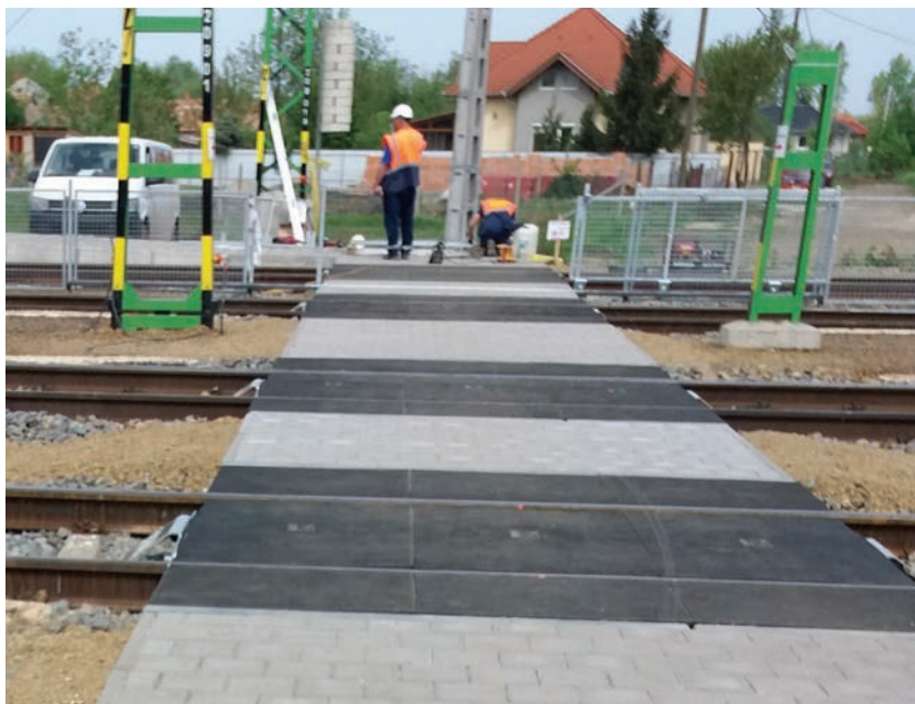
8. ábra. A peronok rámpái közötti szintbeni átvezetés Ebess állomáson (Fotó: Matéz György)
