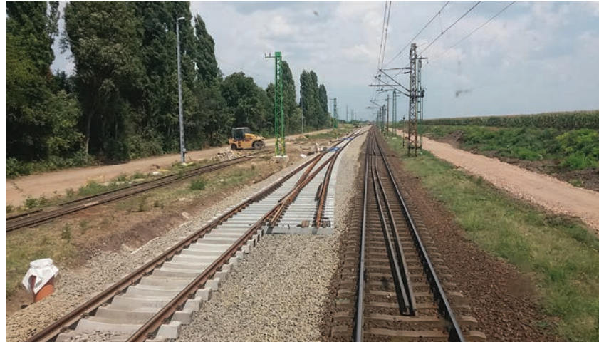
10. ábra. Beépített, új, nagy sugarú kitérő Ebes állomás végponti oldalán (Fotó: Szabó István)
