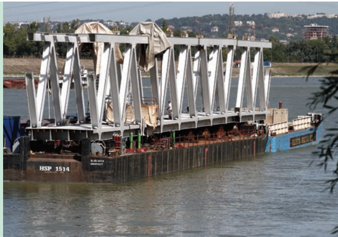
5. ábra. Az úsztatási egység összeállítása (Fotó: Szikszay Ágnes)
