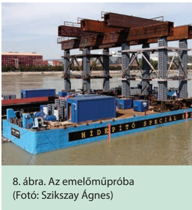
7. ábra. Az átalakított bárka az emelőművel
