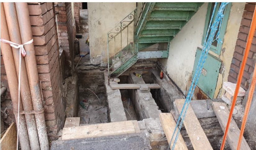
17. ábra. Nyugati pályaudvar II. torony alapjának injektálása
