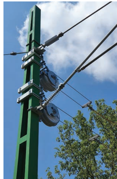
16. ábra. Új típusú felsővezetési feszítőmű
