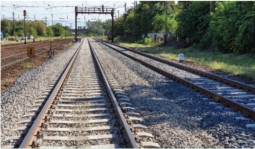
11. ábra. Az elkészült átépítés Nyugati–Városliget-elágazás között
