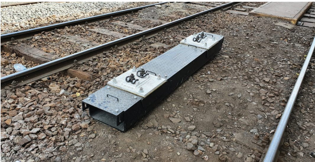
14. ábra. A beépítés előtt álló új típusú vályúalj a vonóvezeték elhelyezése Nyugati II. körzetben
