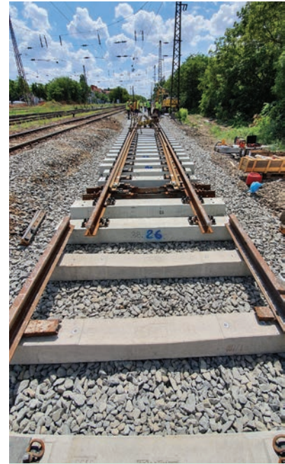
12. ábra. A Városliget-elágazásban új kitérő beépítése
