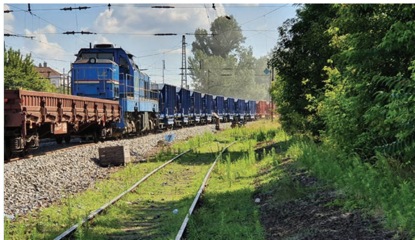
9. ábra. Zúzott kő ürítése Nyugati–Városliget-elágazás jobb vágányban
