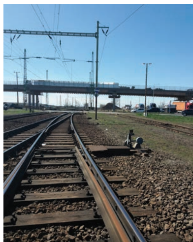
3. ábra. Kaba páros végén épülő közúti felüljáró (Fotó: Matéz György)
