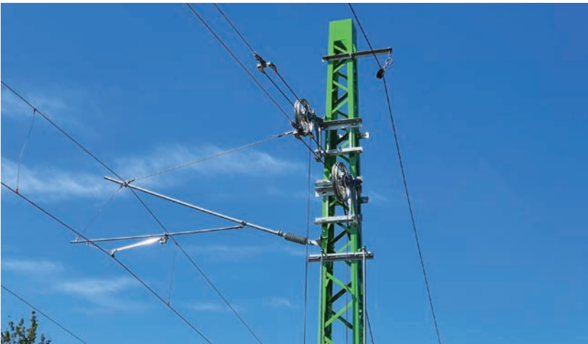
15. ábra. Új felsővezetési oszlop, feszítés, és tartószerkezet
