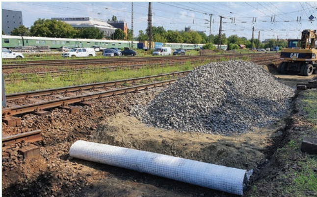
7. ábra. A jellemző új alépítményi rétegrend
