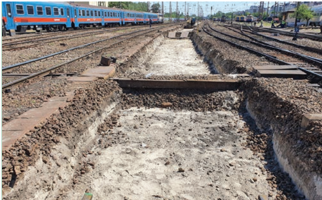
6. ábra. A régi vágány elbontva az alépítmény-nyel együtt a Nyugati pályaudvar „ceglédi bal” vágányában
