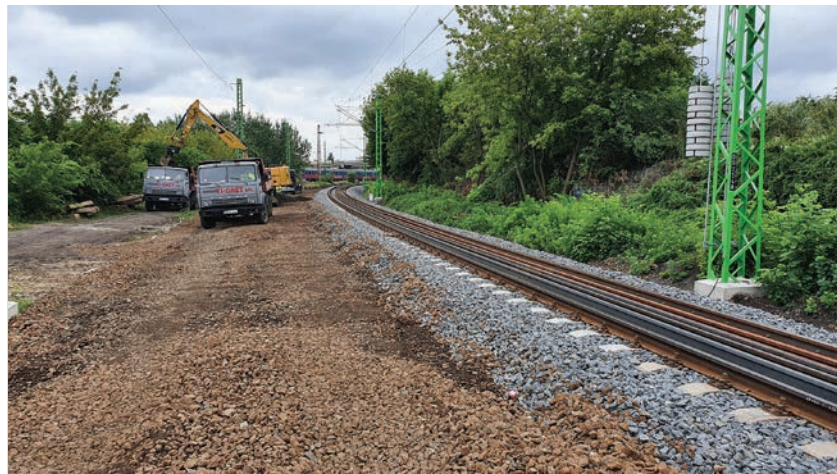
8. ábra. A már átépült jobb vágány, és a bal vágány alépítmenyének bontása Nyugati–Városliget-elágazás között
