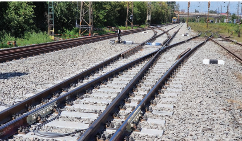
13. ábra. Városliget-elágazás új kitérői beépítve
