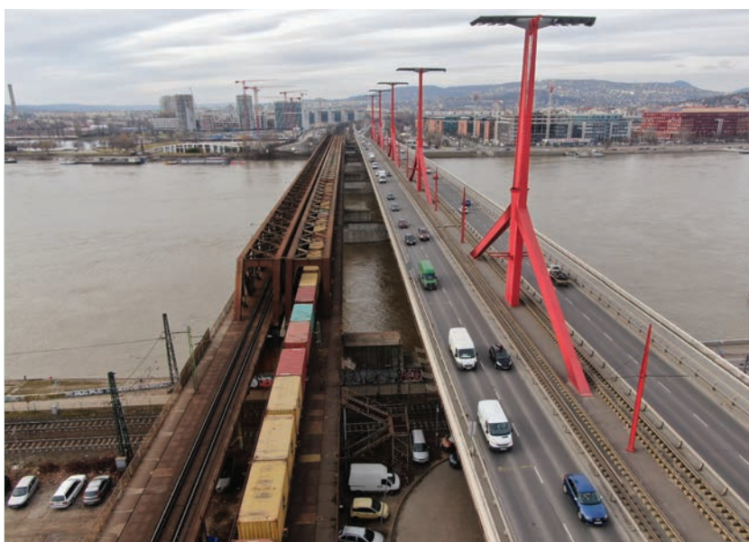
1. ábra. A nagy forgalmú Déli összekötő vasúti Duna-híd
