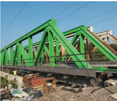
14. ábra. A Keleti-főcsatorna-híd munkaközi állapotban (Fotó: Erdei János)
