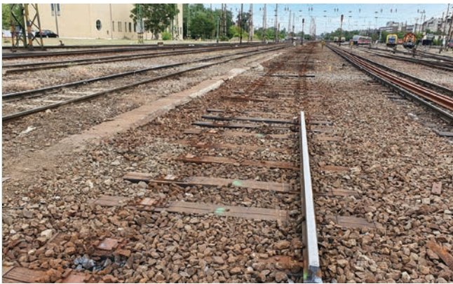
5. ábra. A régi, 48 rendszerű, hevederes vágány bontása a Nyugati pályaudvar „ceglédi bal” vágányában
