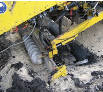
12. ábra. Alépitmény-javítás georács beépítésével (Fotó: Szabó István)
