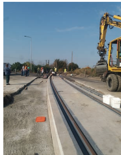
9. ábra. Az Edilon szerkezetű útátjáró építése közben (Fotó: Szabó István)
