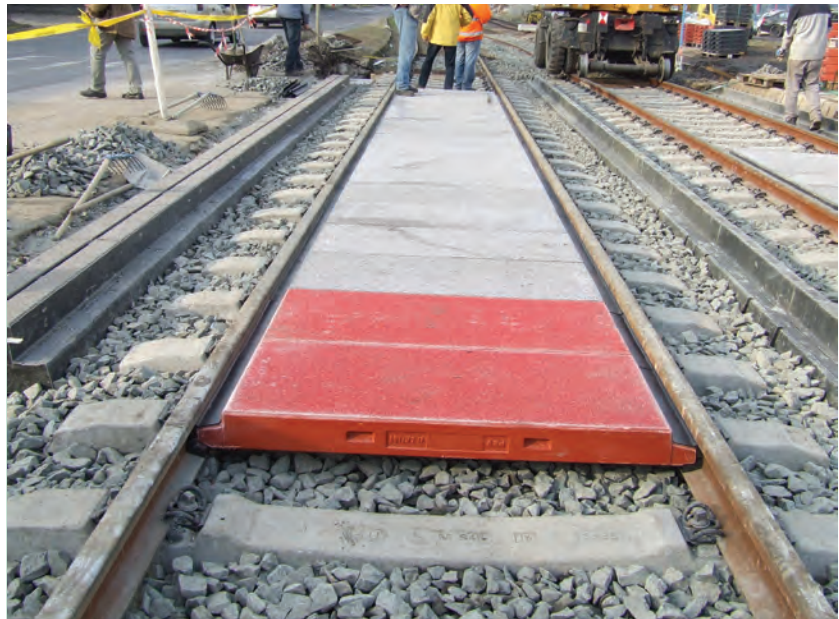
4. ábra. Épülő villamosátjáró a Maglódi úton
