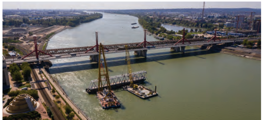
Készülődés az első elem beemelésére
