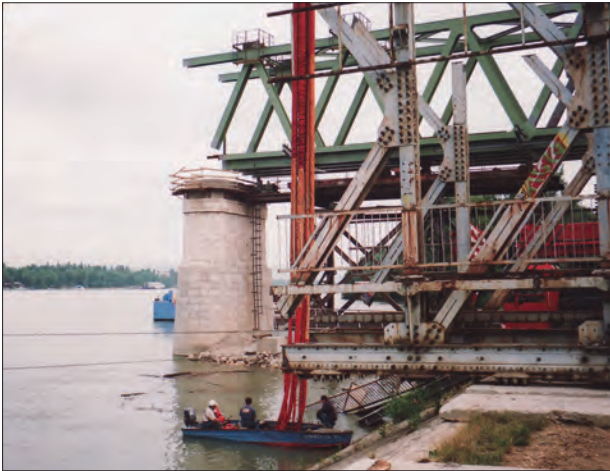
25. ábra. Az Északi összekötő vasúti híd bontása és építése
