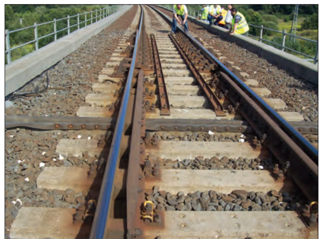
24. ábra. Kísérleti szakasz előkészítése a völgyhídon
