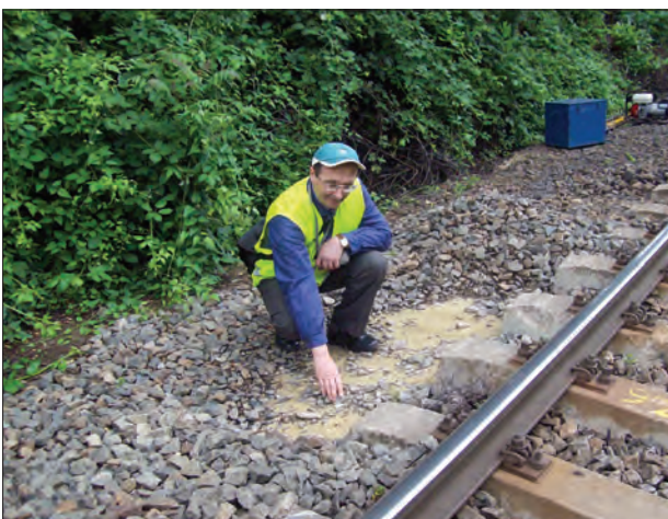
20. ábra. Alépítményhibás szakasz, Bp.-Kelenföld–Budaörs jobb vágány (148–149 szelv.)
