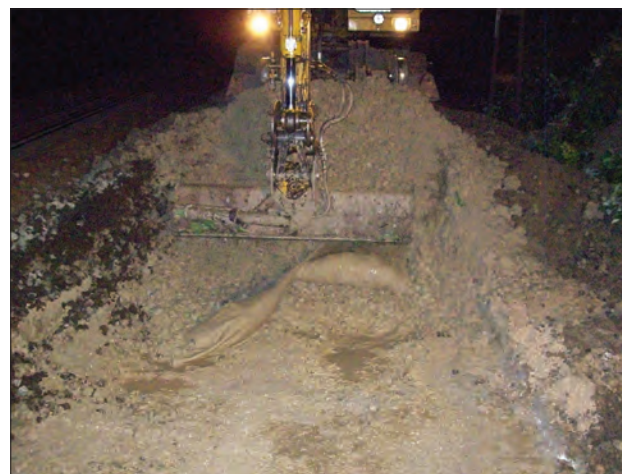
21. ábra. Alépítményhibás szakasz, Bp.-Kelenföld–Budaörs jobb vágány (148–149 szelv.) – a régi ágyazati anyag és a tautex eltávolítása
