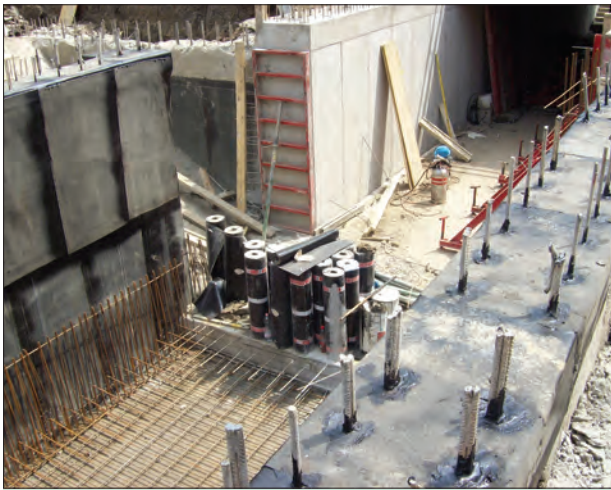
33. ábra. Karcag állomáson aluljáró építése
