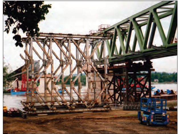
26. ábra. Az Északi összekötő vasúti híd bontása és építése
