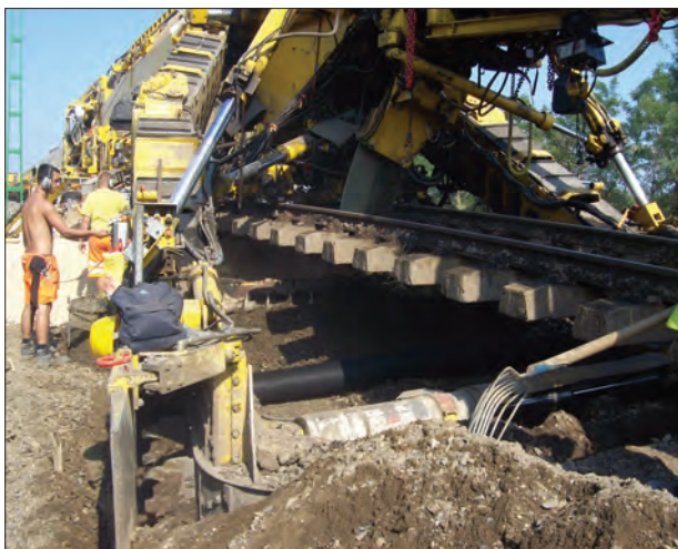
31. ábra. A PM-1000-es alépítmény-javító géplánc munka közben
