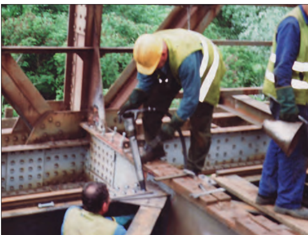
27. ábra. Gyoma – a Hármas-Körös vasúti híd szegecselése
