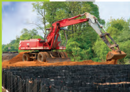
Töltésalapozás épített geocellával
