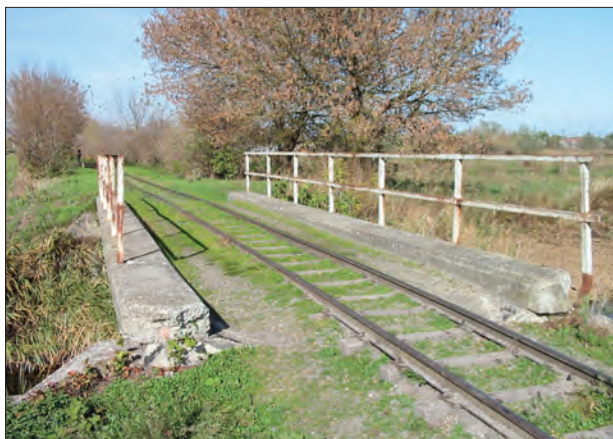
14. ábra. A 12+66 hm szelvényben levő teknőhíd (Fotó: Boros Hajnalka Márta)
