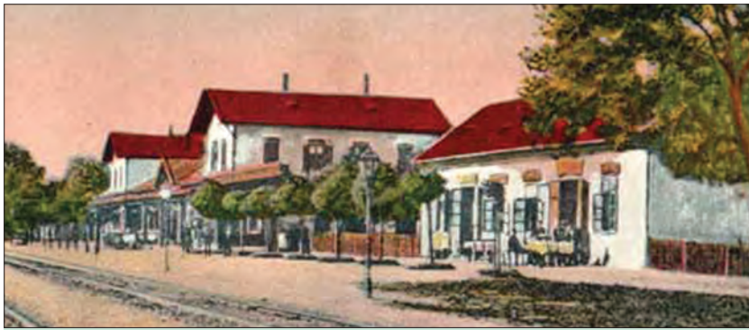
2. ábra. Déli Vasút balatonszentgyörgyi állomása, előtérben az étterem épülete
