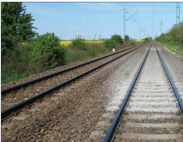
17. ábra. Alépítményhibás szakasz, Lébény-Kimle jobb vágány (1622+63,10 – 1622+69,40 szelv.)
