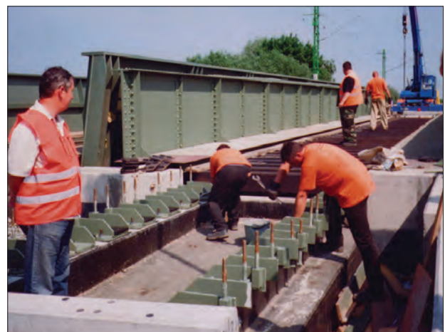
28. ábra. Mezőtúr – Hortobágy–Berettyó vasúti híd átépítése
