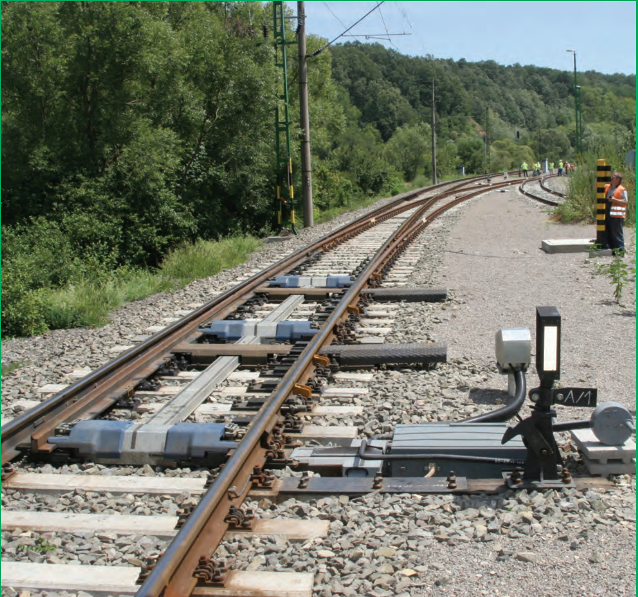
HVH-01/K típusú váltóállítómű a Bükkösd nyíltvonalai kiágazásnál lévő B60-800-as típusú váltón
