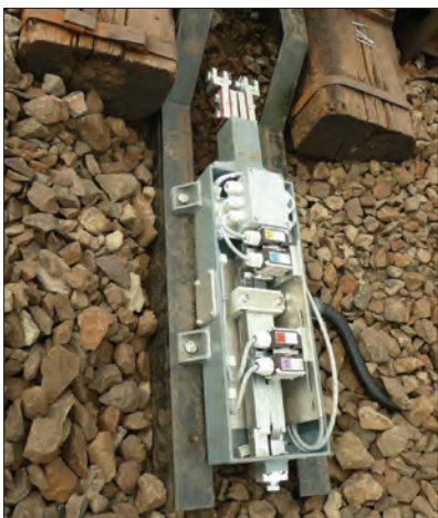
8. ábra. Közbenső végállásérzékelő egység önálló tartószerkezete
