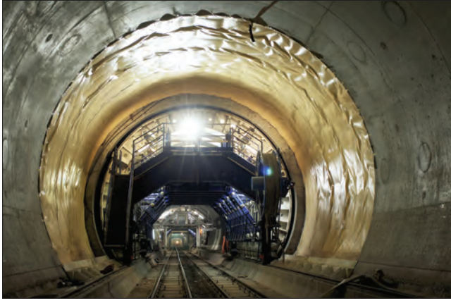
3. ábra. A rétegszerkezet készítése
