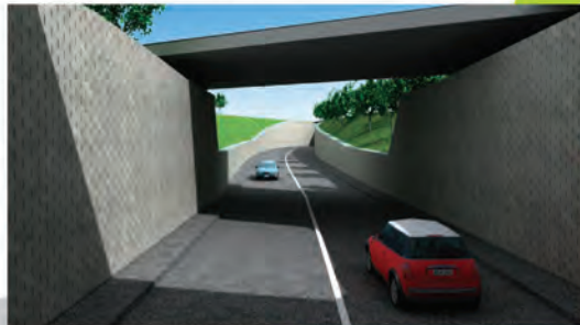
Georáccsal erősített hídháttöltések
