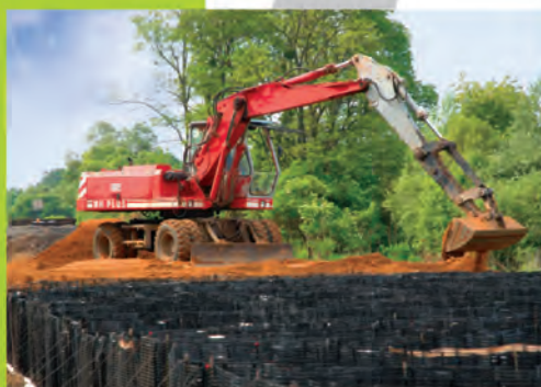
Töltésalapozás épített geocellával
