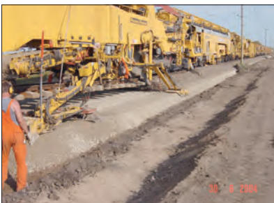
5. ábra. Átépítő vonat a Kecskemét-Városföld vasútvonal átépítésénél (Fotó: Szijjártó István)
