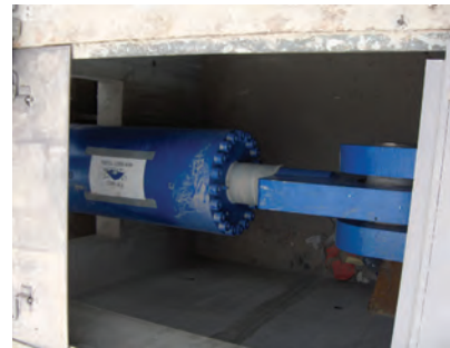
3. ábra. Hidraulikus féktámasz a hídfőkamrában
