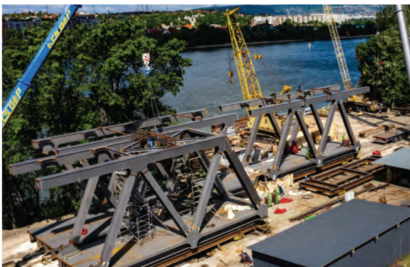
1. ábra. A legyártott acélszerkezet szerelése (NIF-archívum)
