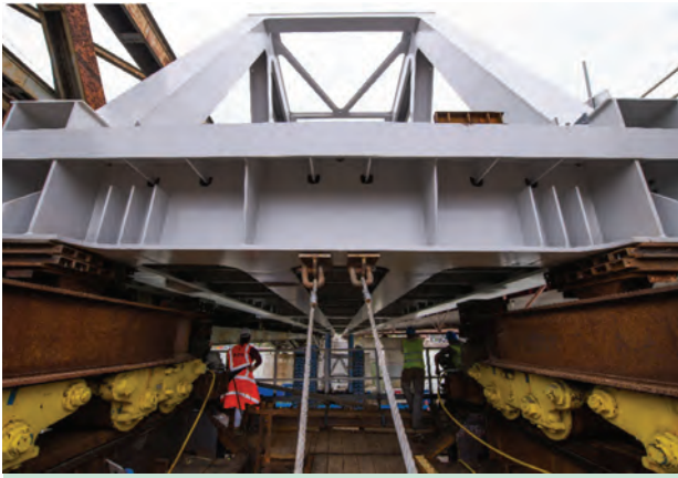
11. ábra. Az első elem hosszirányú mozgatása (Fotó: Nagy Mihály, Magyar Építők)
