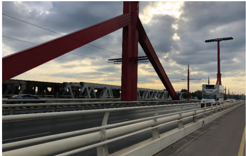
5. ábra. Az építkezés alatt forgalomban levő közúti és vasúti hidak (Fotó: Maller Tibor)
