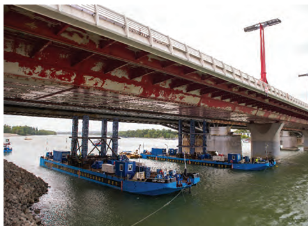
9. ábra. A felemelt hídelem (Fotó: Nagy Mihály, Magyar Építők)
