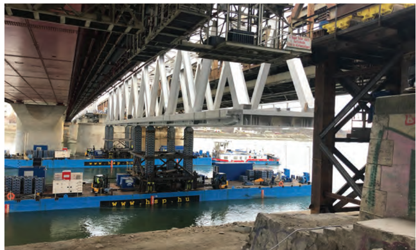
16. ábra. A pesti oldal felőli szakasz utolsó elemének a beemelése (Fotó: Maller Tibor)
