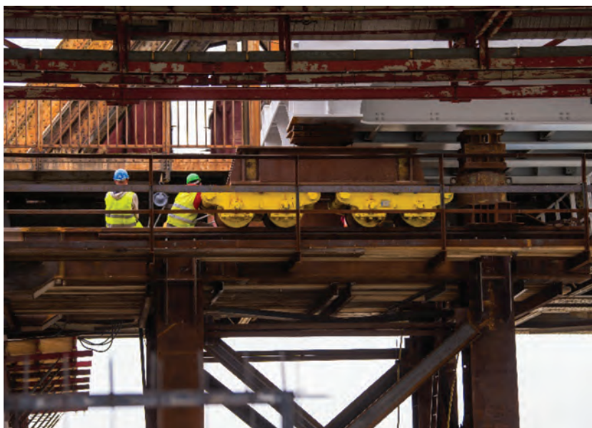
10. ábra. A hídvég átterhelése a behúzó kocsikra (Fotó: Nagy Mihály, Magyar Építők)
