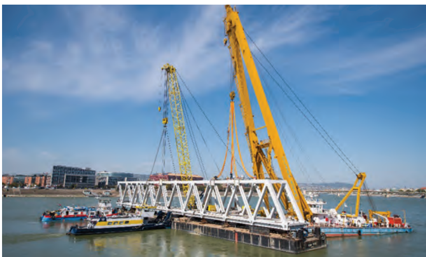
2. ábra. Az úszódaruk előkészülnek az emelésre (Fotó: Nagy Mihály, Magyar Építők)
