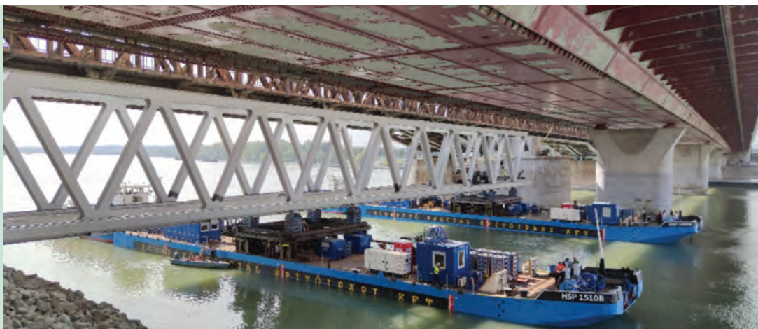
7. ábra. Az emelőtor- nyokra emelt szerkezet beúsztatása az emelési helyre (Fotó: Kovács Rezső)
