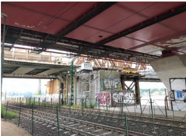
13. ábra. A behúzás előkészítése idején a HÉV-forgalom zavartalan (Fotó: Nagy Mihály, Magyar Építők)
