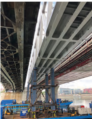
15. ábra. A második hídelem emelése (Fotó: Maller Tibor)
