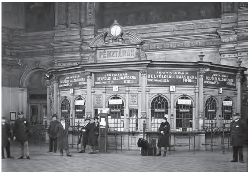
9. ábra. Keleti pályaudvar pénztár csarnokáról (Lotz-csarnok) készült fotó (üveglemez) az 1940-es évek első felében
