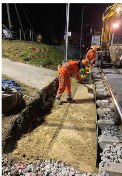
13. ábra. Alépitmény-előkészítés B-széles szegélygerendához
