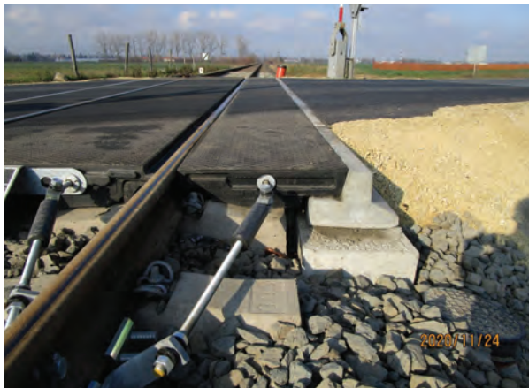
4. ábra. STRAIL útátjáró fektetőgerendával és T-szegélygerendás kialakítással
