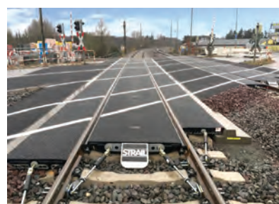
14. ábra. STRAIL útátjáró B-széles szegélygerendával
