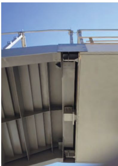
7. ábra. Felszerkezetbe betonozott acélkonzolok
