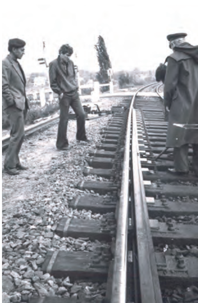
3. ábra. Csajág állomás 2. számú 48-800-as kitérőben csúcscsínkere
