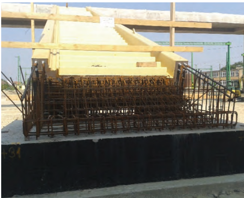
8. ábra. Lépcsőkar befogása a cölöpöket összefogó gerendába
