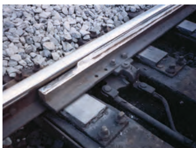
4. ábra. Új csúcscsínhegy kialakítása
