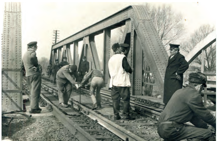
5. ábra. A Zala-hídon a terelősínek cseréje
