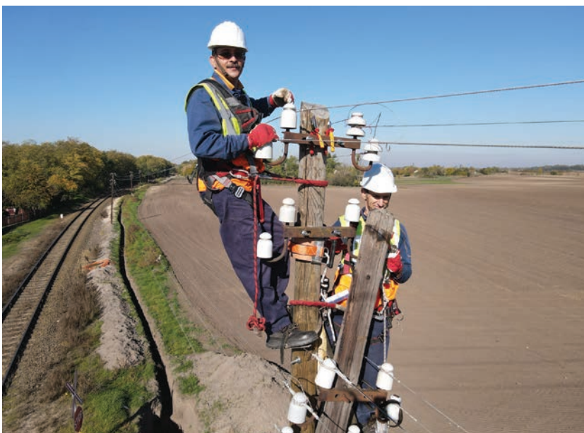
1. ábra. Egy 1911-es támfás oszlop élő légvezetési áramköreit szereli át új faoszlop-ra Botos György távközlő mester és Szedlák Ferenc beosztott mester 2023. október 14-én, a 142-es vasútvonalon Miklóstelep megállóhely közelében
