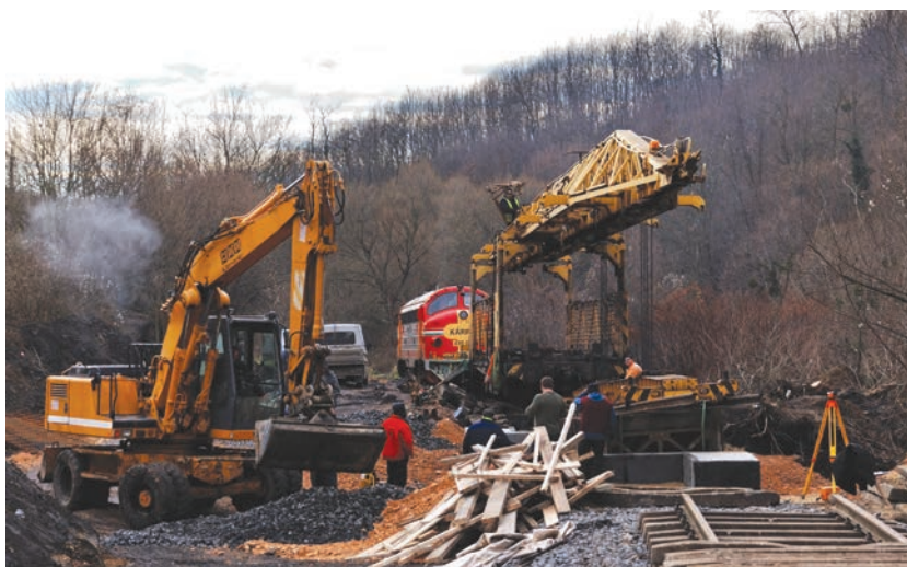
4. ábra. Hídprovizórium beépítése a megrongált szakaszon. (Fotó: Harmati Marcell)
