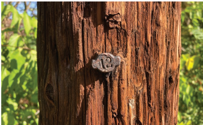
3. ábra. 1912-es telítésű faoszlop Hetényegyháza közelében
