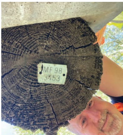
10. ábra. 1998-as faoszlop jelölése műanyag táblával
