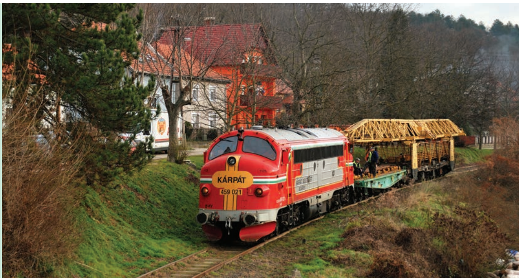
4. ábra. Hídprovizórium beépítése a megrongált szakaszon. (Fotó: Harmati Marcell)
