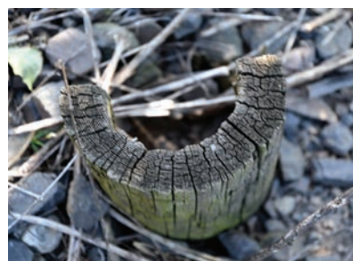
2. ábra. Betongyám nélküli oszlop- csonc
