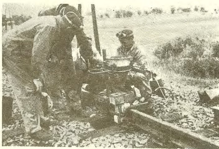
Thermogénhegesztés elő- készítése.
