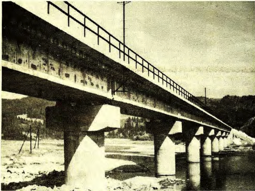
3. ábra. Egyvágányú vasuti hid előregyártott vasbeton pillérekkel a CSD-nél
