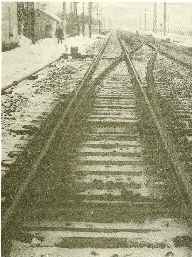
2. ábra: R-65 típusú 1:11 hajlásszögű mozgó csucsbetétes keresztezésű kitérő a váltó felől
