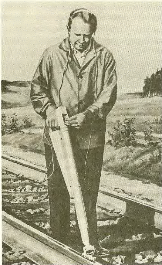
Kézi sinvizsgáló készülék /URDO-3 típus/
