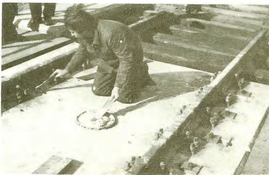
12. ábra: A kész vasbeton pályalemezes hid
