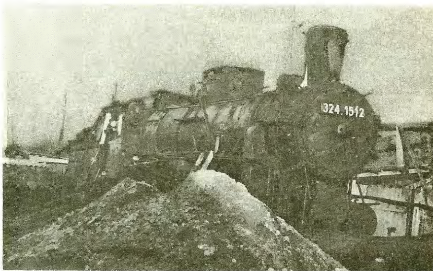
A régi munkásszálló "hőközpontja"
