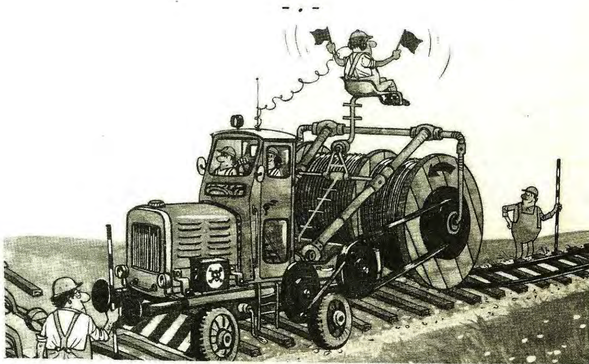
Hézag nélküli vágány építése
