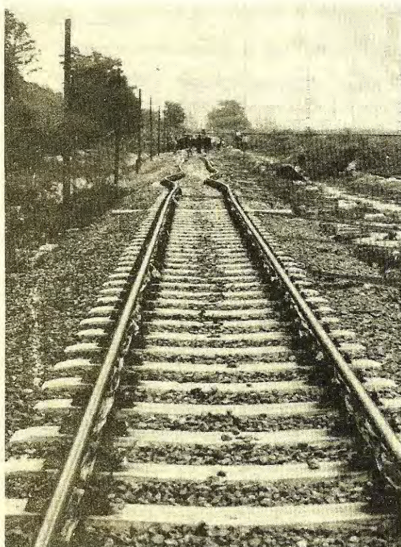
3. ábra: A IV. kísérlet során kivetődött vágány távlati képe
