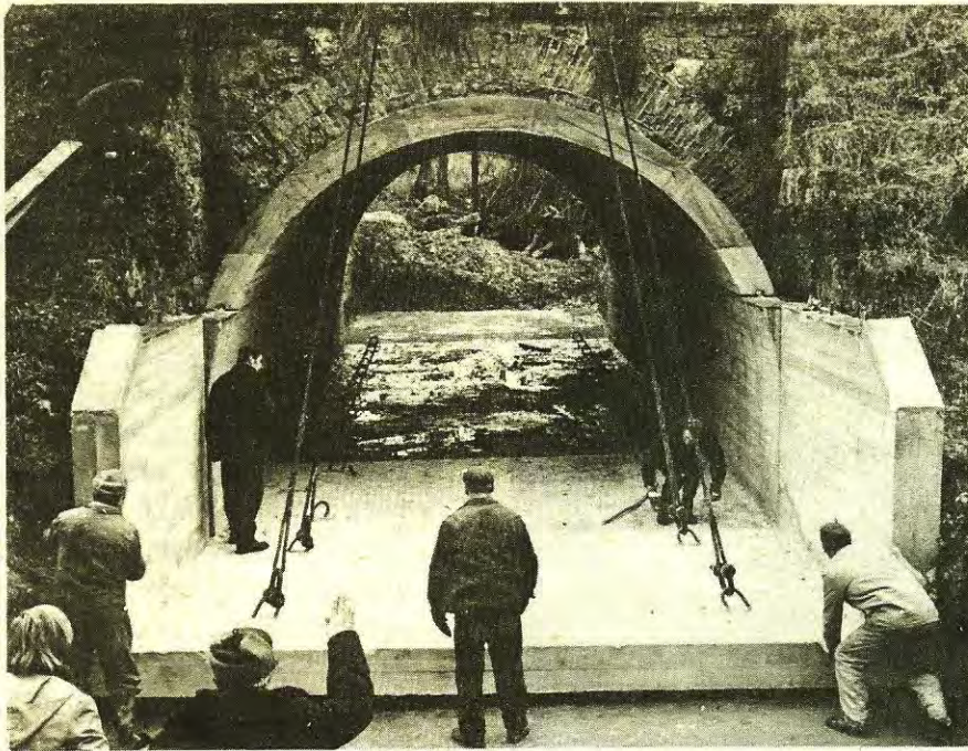
15.ábra: Avult téglaboltozat bélelése előregyártott vasbetonelemekkel
