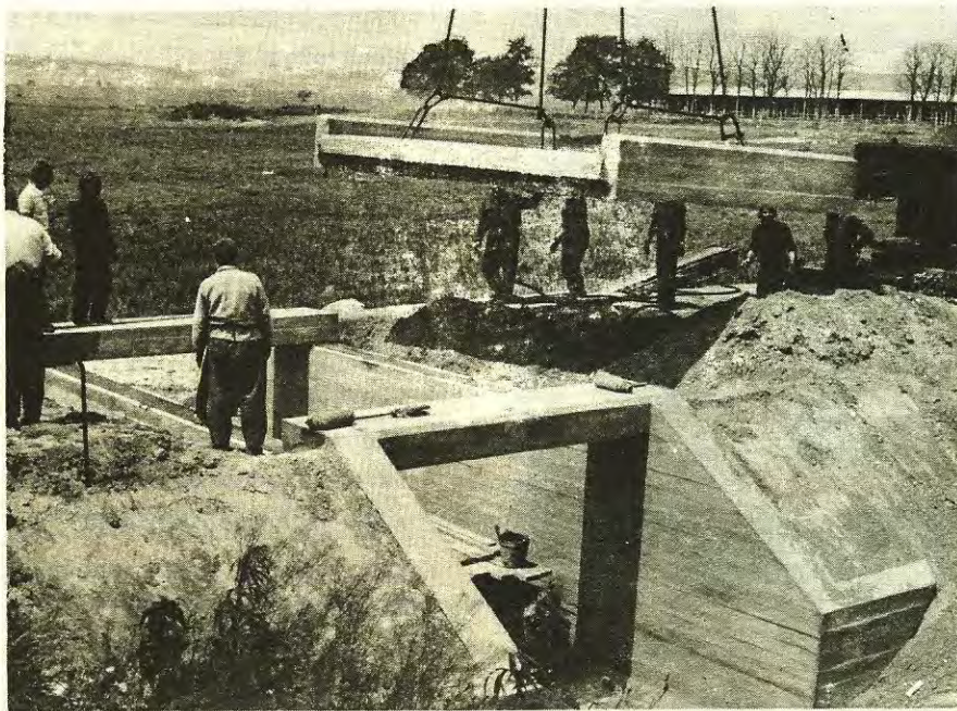
10. ábra: Helyszínen betonozott, kitámasztott U-keret előregyártott áthidalószerkezettel
