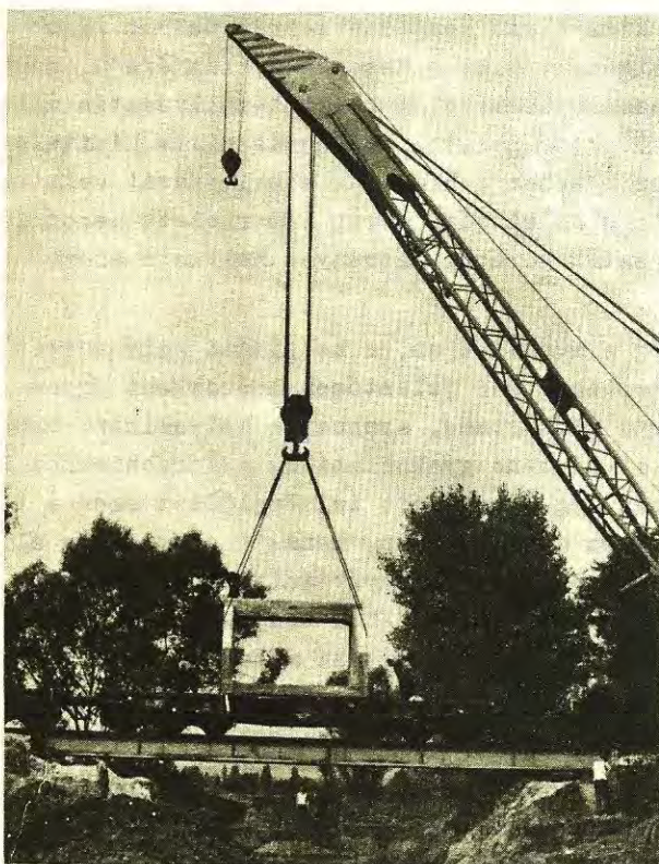
6. ábra: Keretszerkezet beemelése EDK 1000 vasúti daruval
