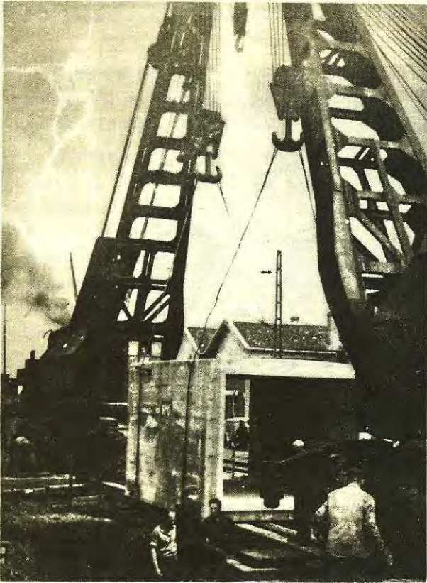
7.ábra: Vasbeton keretelem beépítése két vasúti daruval
