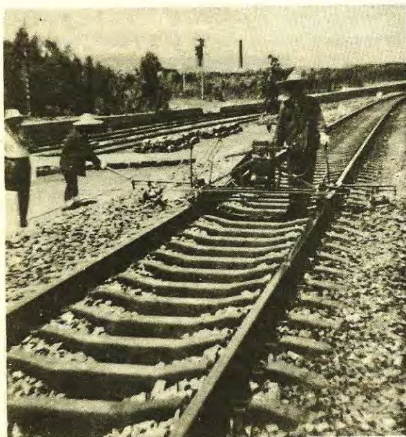
4. ábra: Ágyazatszéltömörítő kiscsiga
