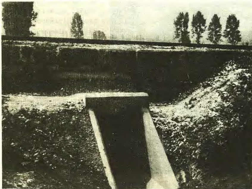
14. ábra: Kisnyílású tartóbetétes teknőhid toldása előregyártott keretelemmel
