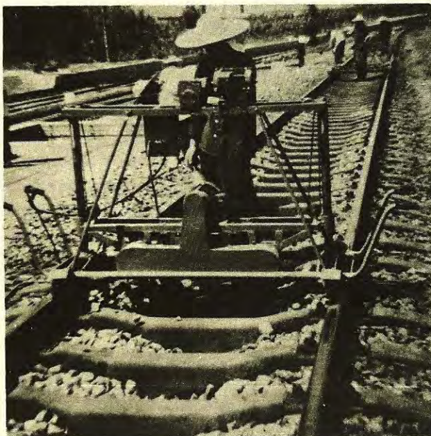
2. ábra: Takarékküreg-készítő kigép
