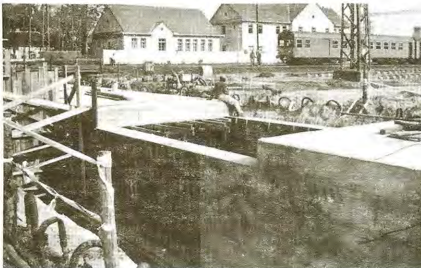
4.kép Műtárgy zsaluzása és lefedése
