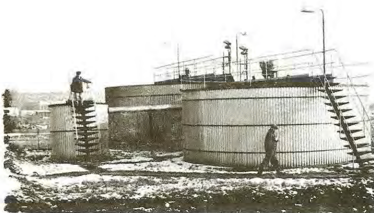
4.kép Tartályos rendszerű házi szennyvíztisztító
