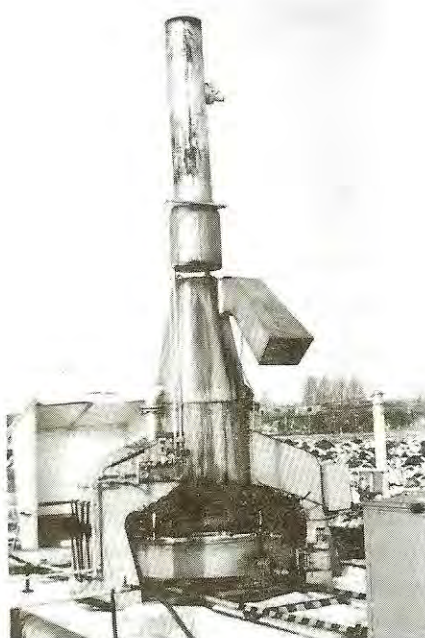
3.kép SUS 11-es hulladékégető
