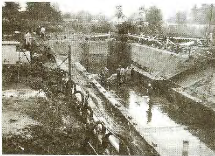
3.kép Fenékszigetelés, talajvízszint süllyesztés mellett
