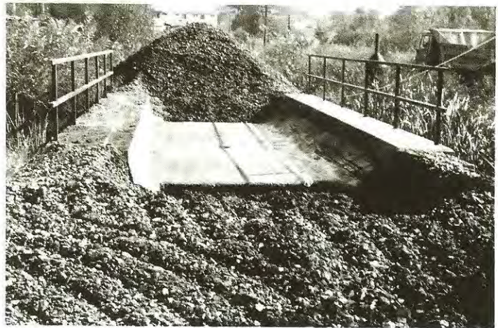
2. ábra Az 5,0 m nyílású teknőhíd a végpont felőli oldalról fényképezve
