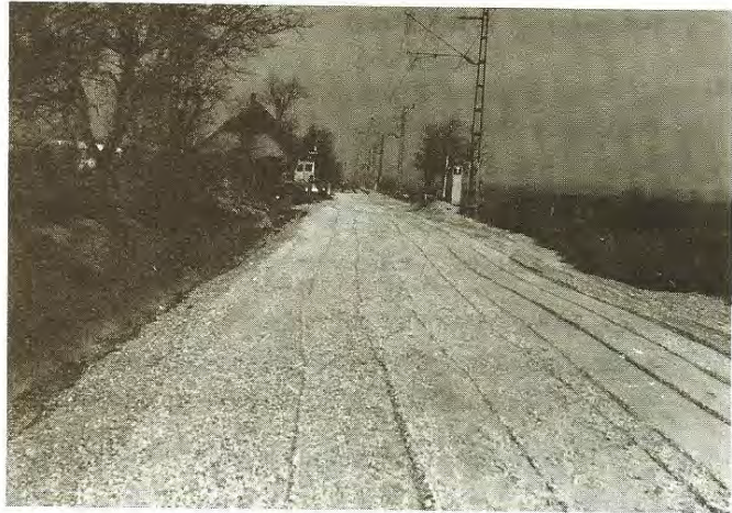
2. ábra Sárbogárd-Nagylók javítóréteg terítés
