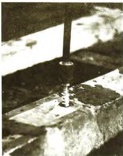
1. ábra Vortok spirál behajtása hullámos fabetetű vasbetonaljba
