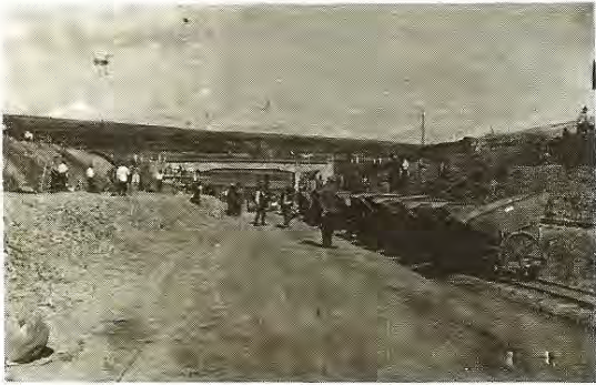
9. ábra Földszállítás keskenynyomtávolságú munkavágányon
