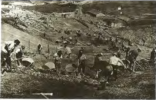
7. ábra Földkitermelés kézi erővel
