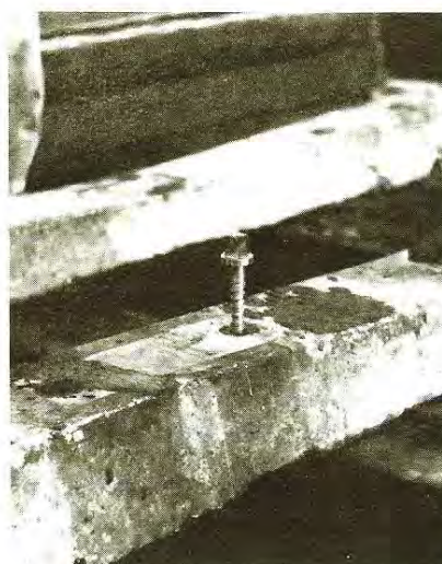
2. ábra Behajtó segédeszköz kivétele
