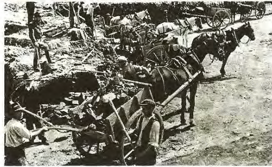
8. ábra Földszállítás kordéval
