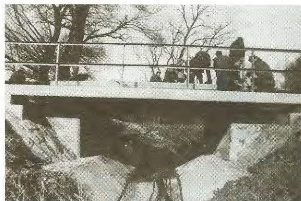
6. ábra: Diósjenő - Romhány vonal 27 + 19 sz. -ben elkészült közvetlen sínleerősítésű vb. lemezhid utómunkái
