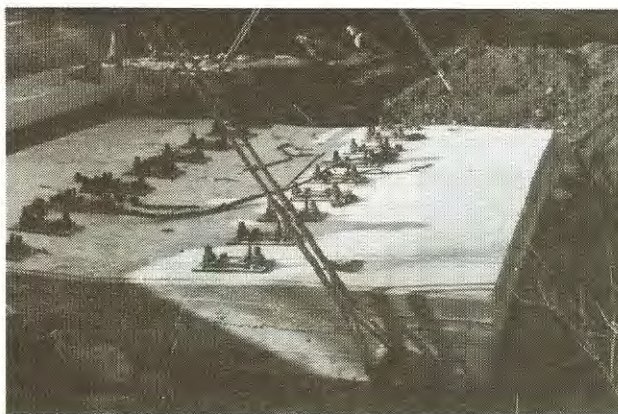
5. ábra: Diósjenő - Romhány vonal 27 + 19 sz. felszerkezet beemelése vasúti daruval
