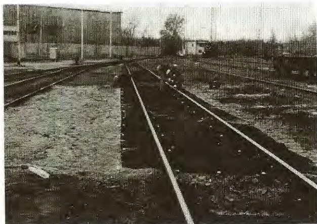
1. kép Olajfogó paplan beépítve
