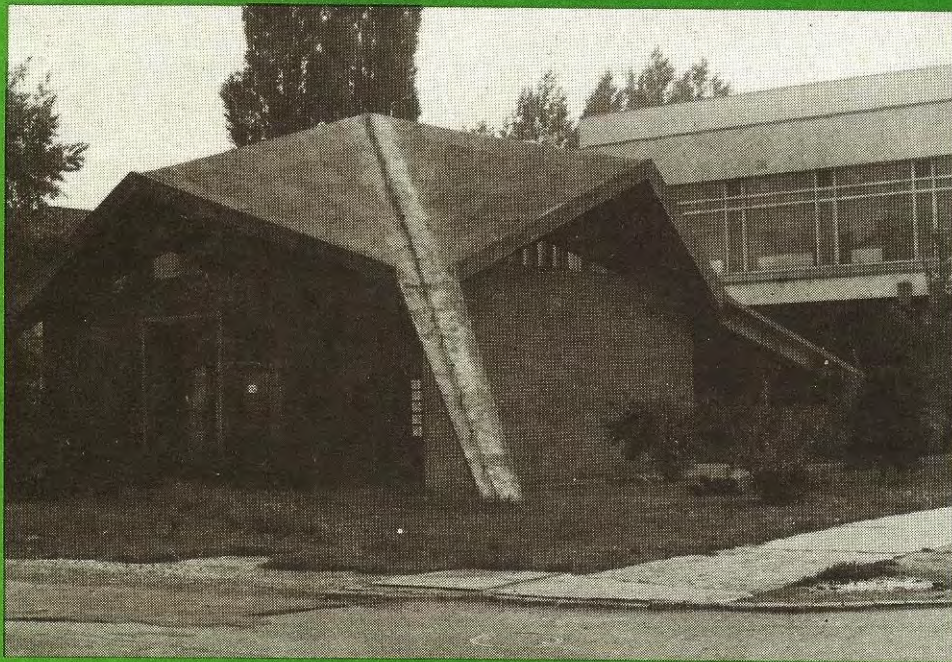
Miskolc Tiszai pu. Trafóház
