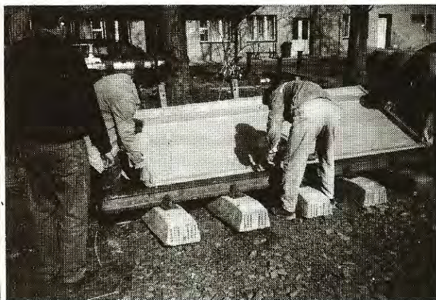
3. kép A tálca beépítése II.
