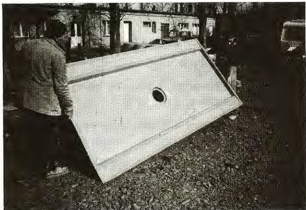
2. kép A tálca beépítése I.
