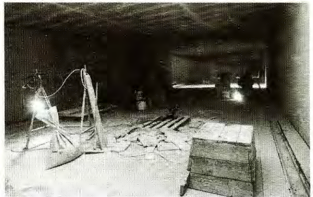
3. ábra Az aluljáró belső burkolása
