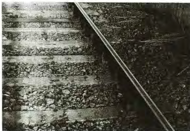
4. ábra C felépítményből 48 rendszerűre átépített vágány
