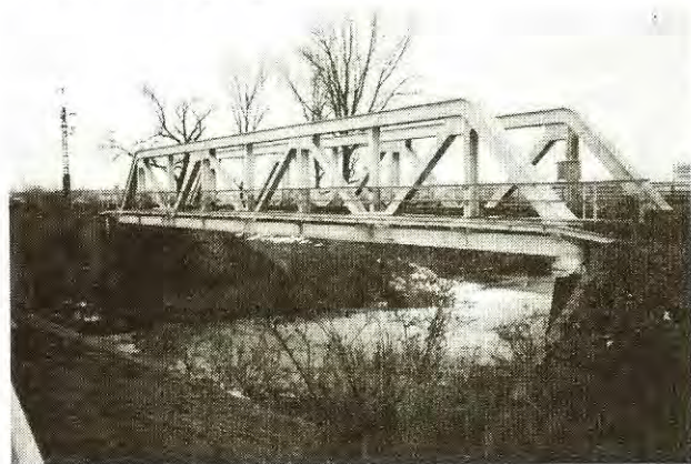
5. ábra Görbe - híd
