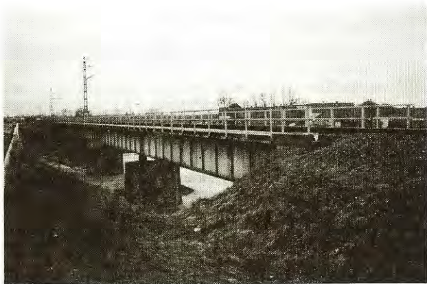
4. ábra Aranyos - híd
