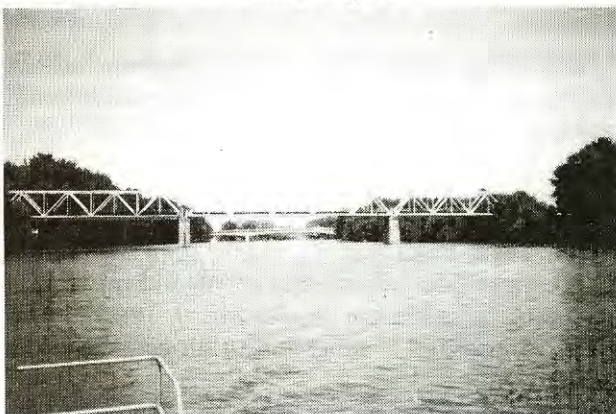
6. ábra tokaji - Tisza híd
