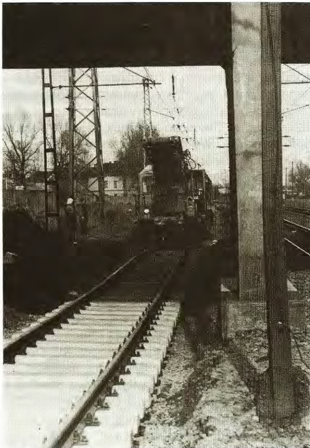
A felüljáró alatti rövid szakaszon földmunka technológiával előre elkészítettük a vágány süllyesztését
