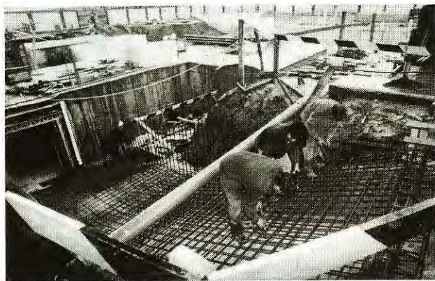
4. ábra Az aluljáró vasszerelése
