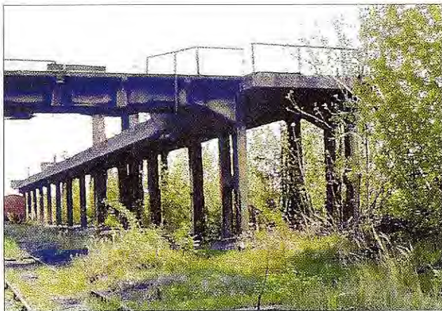
8. kép. A felújítandó szénecsuszda
