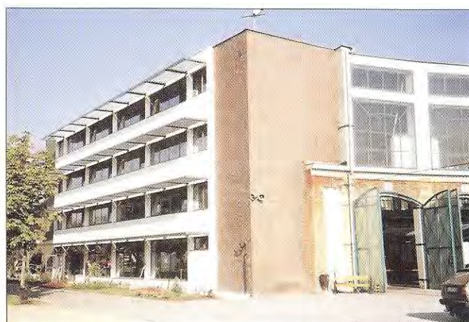
A körfűtőház kiállítási épületeként
