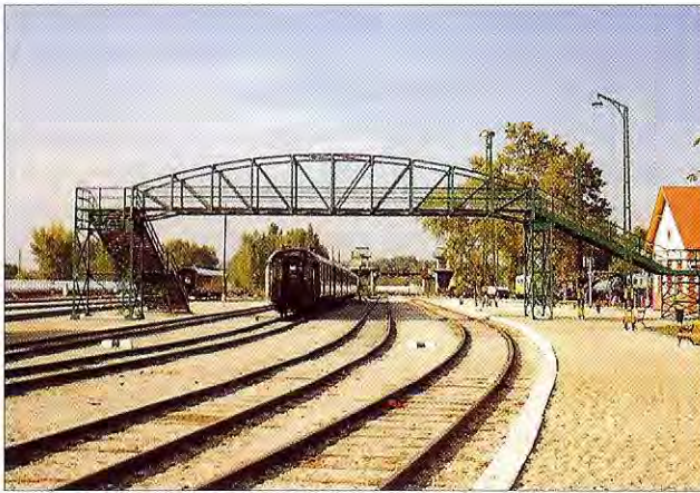
5. kép. A Park képe a felújítás után
