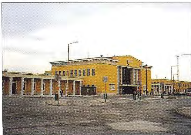
13. kép. A felújított utcai homlokzat
