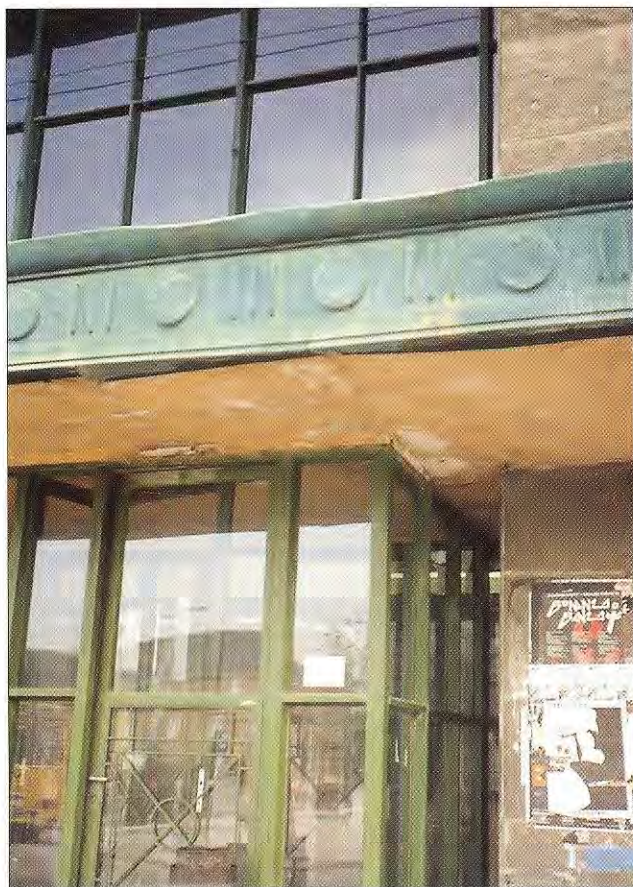
11. kép. Homlokzati részlet a felújítás előtt (bejárati előtető)
