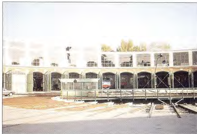
A 3/4 körfűtőház a felújítás után
