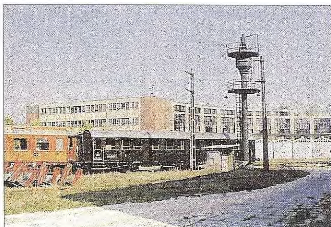
A körfűtőház és a fejpület a felújítás előtt
