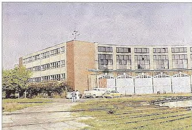
A körfűtőházhoz csatlakozó fejpület a felújítás előtt
