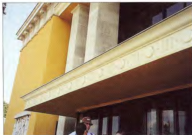
12. kép. Homlokzati részlet a felújítás után (bejárati előtető)
