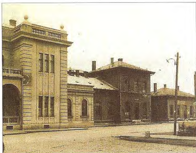
3. kép. A felvételi épület városi homlokzata 1927-ben
