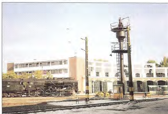
A körfűtőház és a fejpület a felújítás után, előtérben a homokfeladóval
