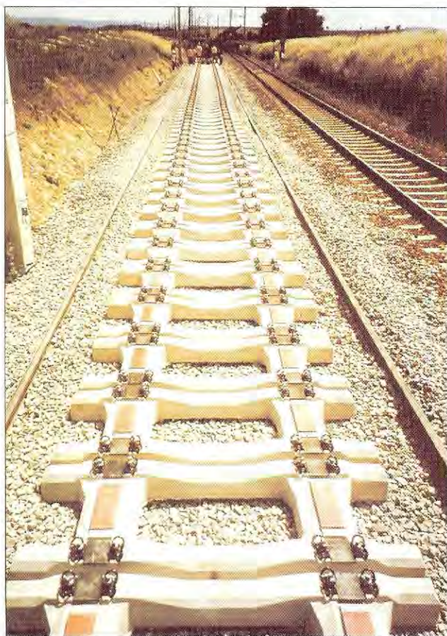
10. ábra. A keret-vasbetonaljas vágány
