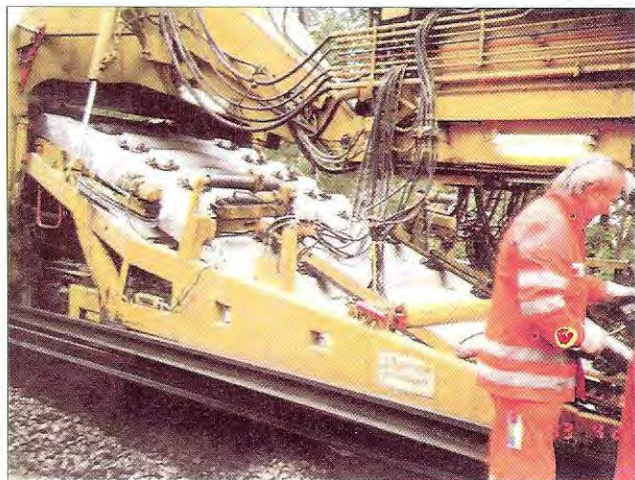
4. ábra. A széles beton-alvasó vágány fektetése átépítő vonattal
