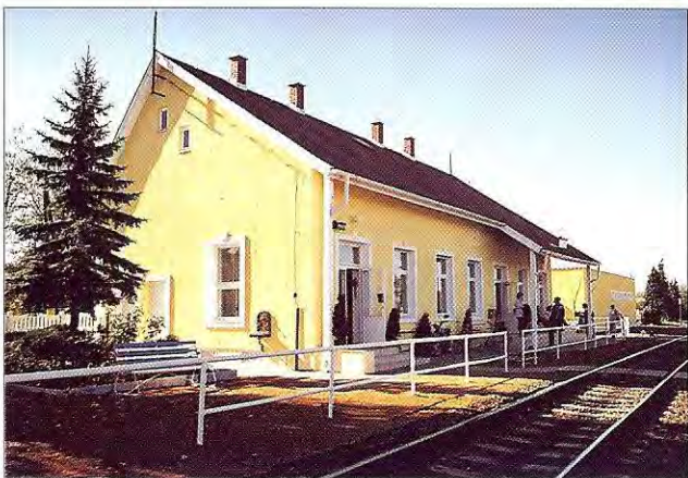
4. ábra. Felvételi épület homlokzata a rekonstrukció után
