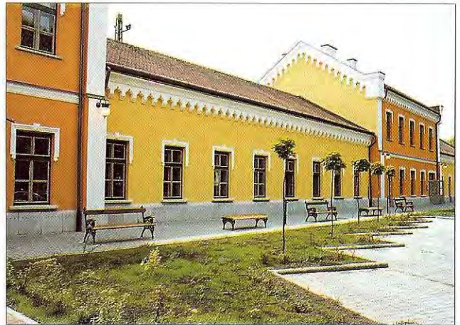
3. ábra. Város felőli homlokzat
