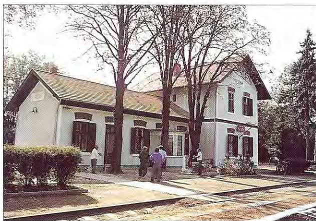
12. ábra. Pácsony – felvételi épület vágány felőli homlokzata
