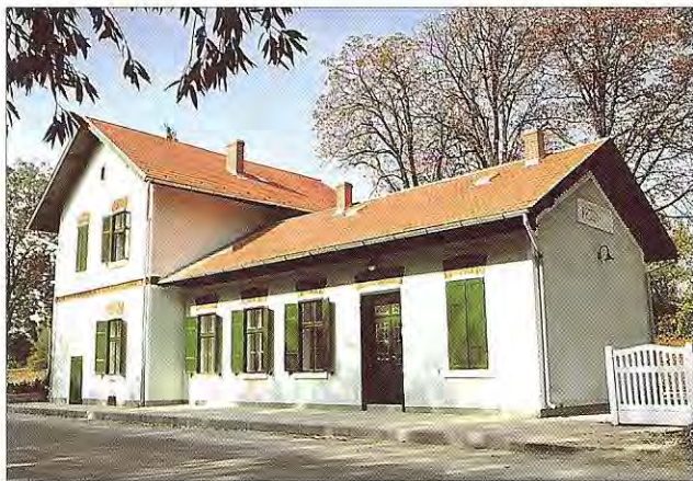
13. ábra. Pácsony – felvételi épület utca felőli homlokzata
