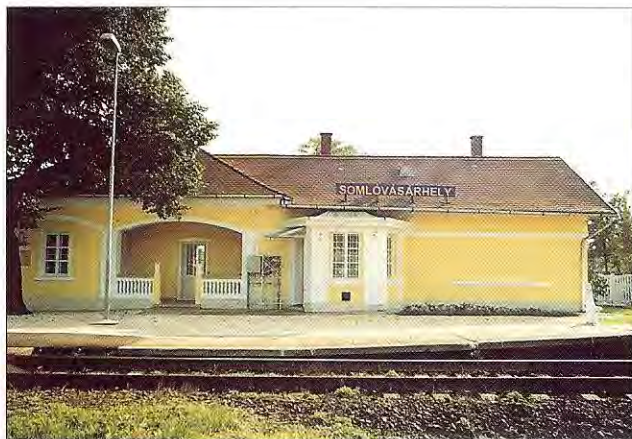
10. ábra. Felvételi épület homlokzata a rekonstrukció után
