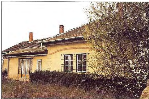
5. ábra. Somlóvásárhely – felvételi épület homlokzata a rekonstrukció előtt
