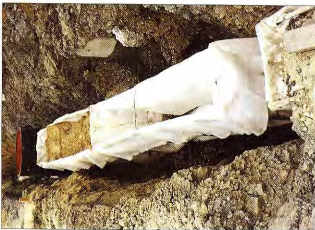
1. ábra. Új típusú mélyszivárgó
