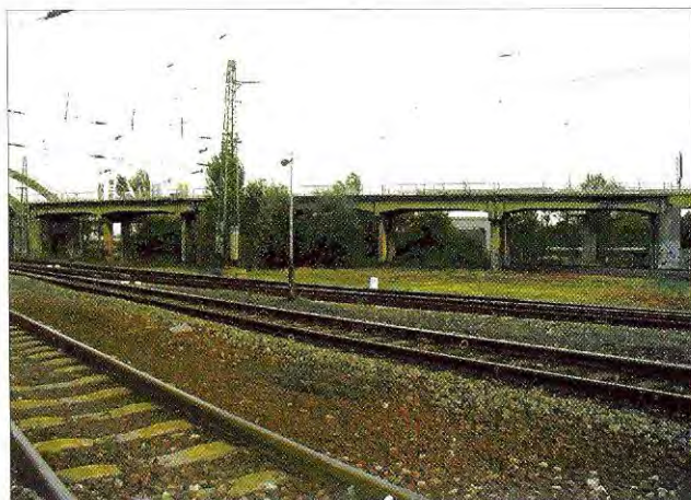
Lajosmizsei vágány és Langer ívhíd közötti szerkezetek képe
