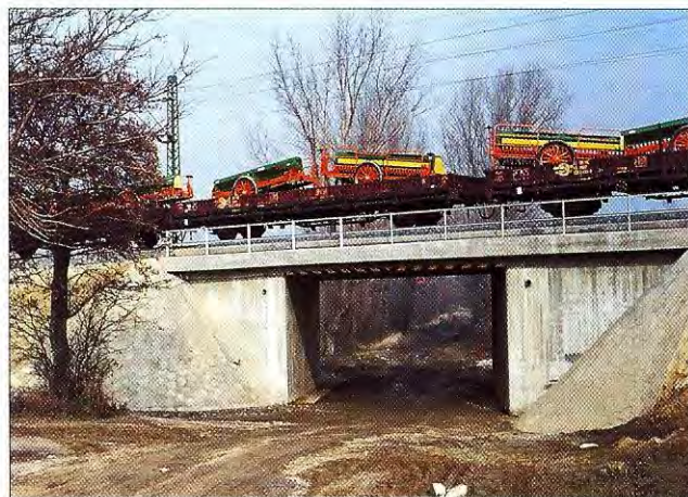
5. ábra. Vasúti felüljáró a 627+93. szelvényben
