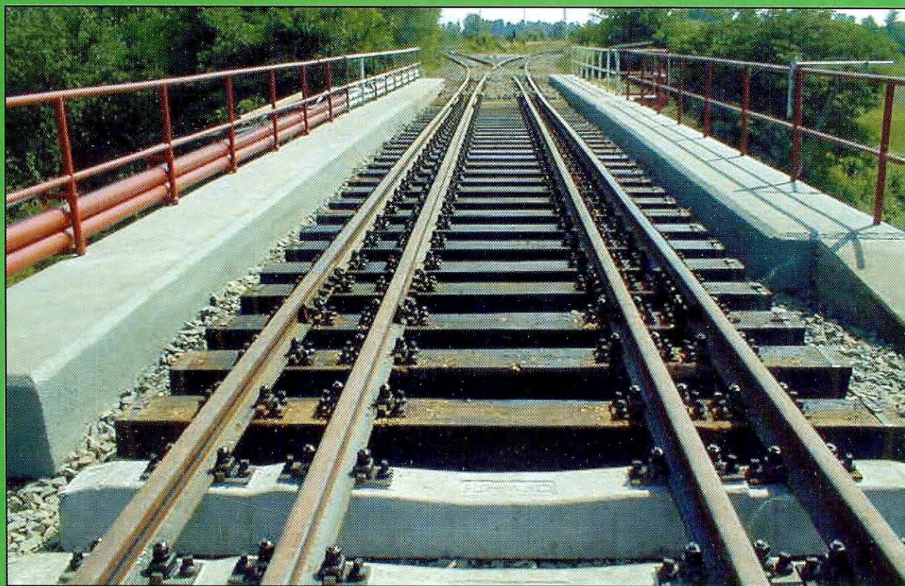
A záhonyi felújított fonódott vágány és hídszerkezet
