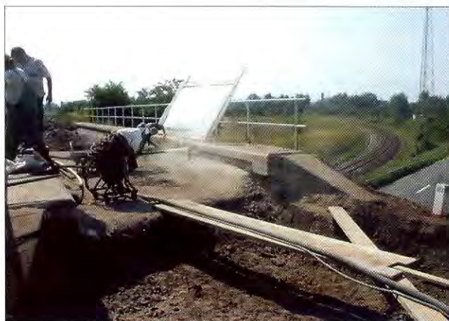
2. ábra. A betonszerkezet tisztítása
