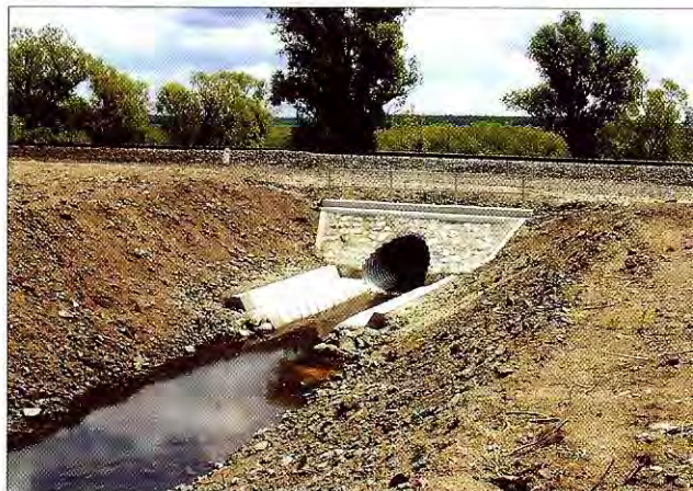
5. ábra. Az elkészült műtárgy
