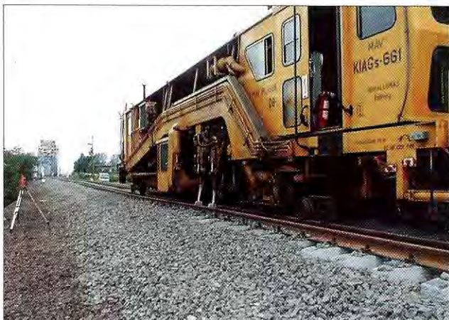
5. ábra. Az új vágány szabályozása
