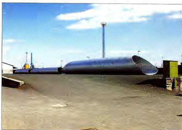
2. ábra. A Tubosider szerkezetek összeszerelése
