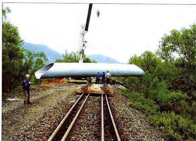
4. ábra. A szerkezet beemelése
