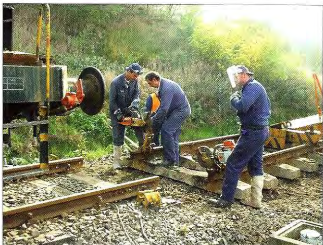
2. ábra. A régi és új vágány csatlakozása
