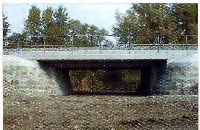
3. ábra. Felújított hídszerkezet
