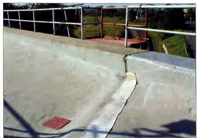
3. ábra. Elkészült szigetelés a hídon
