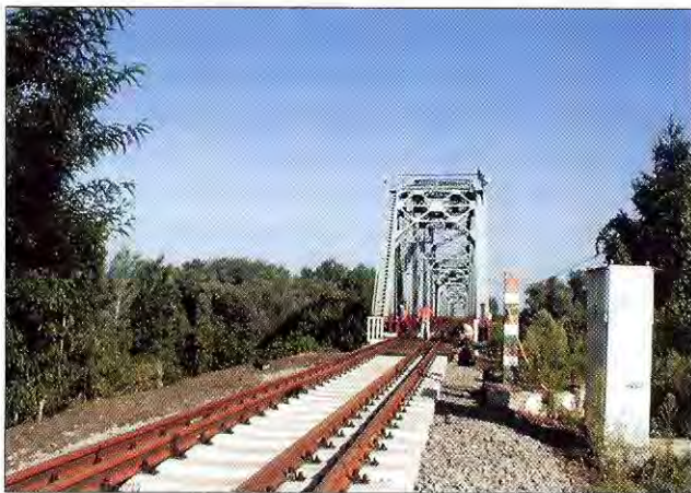
4. ábra. A fonódott vágány csatlakozása a határhídra
