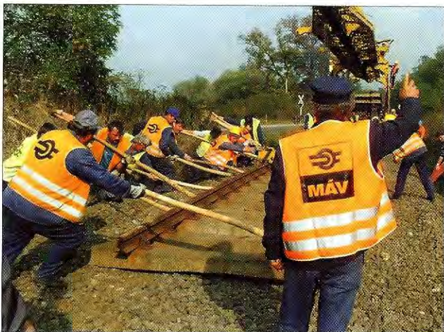
1. ábra. Új vágány fektetése
