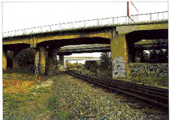
Lajosmizsei vágány hídníjlása
