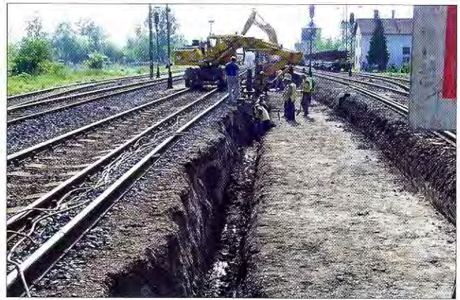
2. ábra. Szivárgó építés Kapuváron
