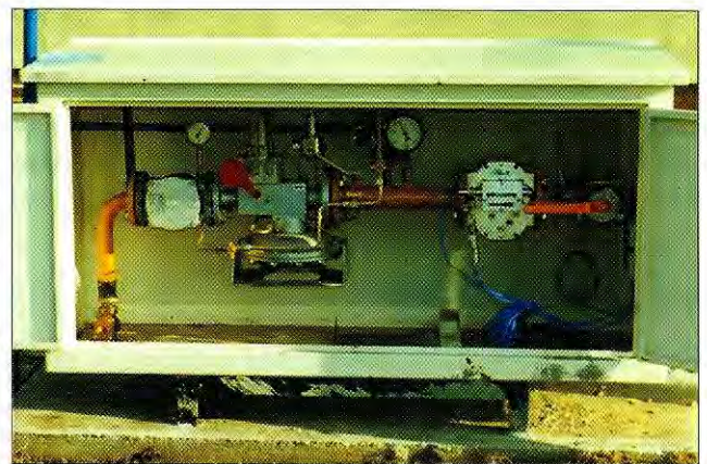
15. ábra. Földgáz-fogadó szekrény szerelvényei
