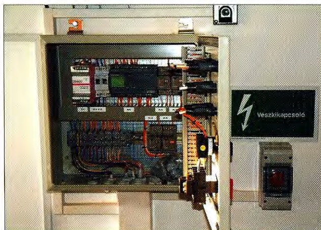
6. ábra. Távvezérlő szekrény szerelvényei
