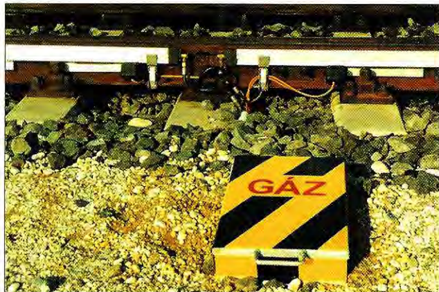
10. ábra. Csatlakozó szekrény
