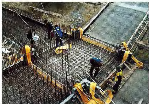
2. ábra. Szerkezet vasszerelése a szigetelt aljzaton
