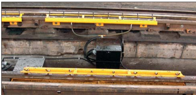
3. kép – Sínkenő berendezés a záhonyi tengelyátszerelőben
