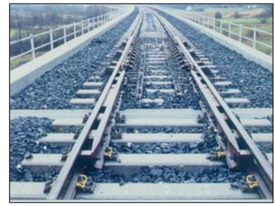
2. kép – Pályaáthidalás és síndilatációs készülék
