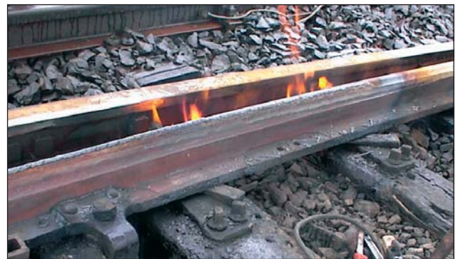
2. kép – Sínvégek hőkezelése ragasztott szigetelt kötésekben
