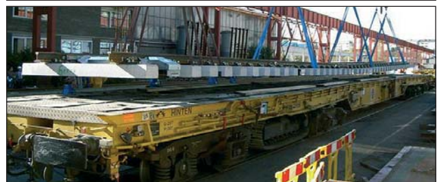
10. és 11. kép – A betonljas szerelt kitérő és váltó kiszállítása a beépítési helyre
