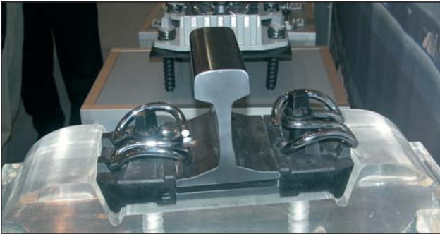
2. ábra – VOSSLOH-gyártmányú, "300"-jelzésű sínleerősítés, Skl-15 típusú szorítórugóval
