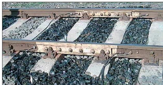
4. kép – Ágyazatragasztás ívekben hézag nélküli pályák létesítése esetén
