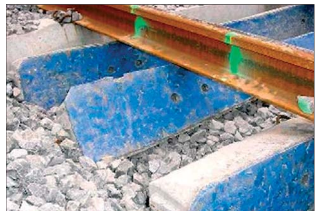
1. kép – Vasbeton aljakra felragasztott rugalmas aljtalpak
