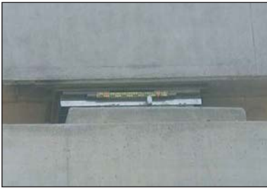
1. kép – Külponosan elhelyezett hídsaru
