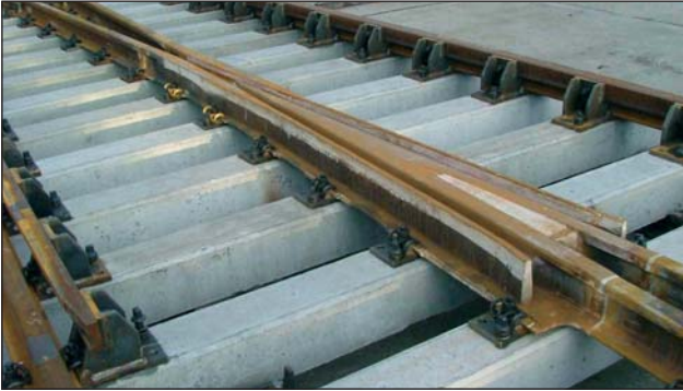
7. kép – Az Mn középblokkos keresztelés hegesztett csatlakozósínekkel
