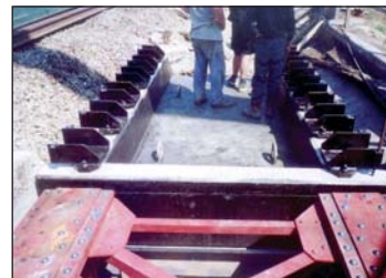
4. kép – Kiegyenlítő tartó beépítése
