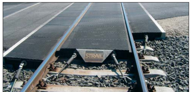
STRAIL vasúti átjáró
