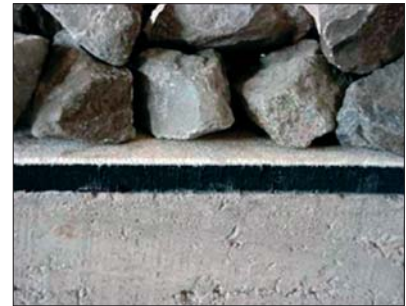
3. kép – CDM-BAM-C típusú alágyazati szőnyeg vasbeton lemezen
