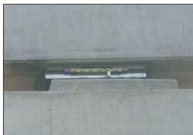
1. kép – Külpontosan elhelyezett hídsaru
