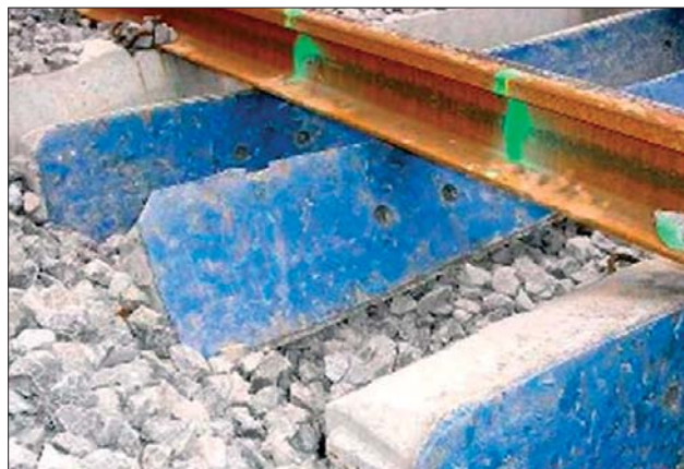
1. kép – Vasbeton aljakra felragasztott rugalmas aljtalpak
