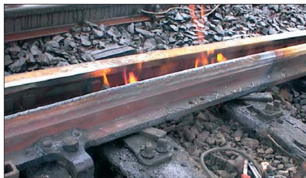
2. kép – Sínvégek hőkezelése ragasztott szigetelt kötésekben
