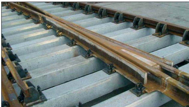
7. kép – Az Mn középblokkos keresztelés hegesztett csatlakozósínekkel
