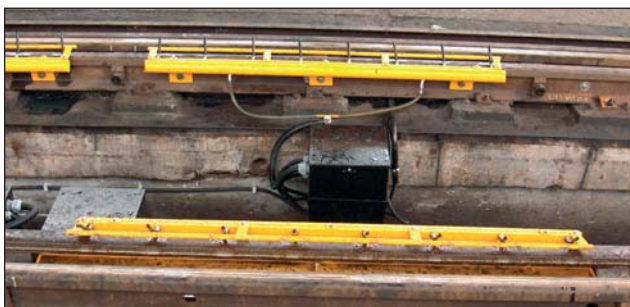
3. kép – Sínkenő berendezés a záhonyi tengelyátszerelőben
