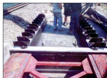
4. kép – Kiegyenlítő tartó beépítése
