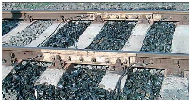
4. kép – Ágyazatragasztás ívekben hégzag nélküli pályák létesítése esetén
