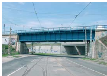
3. kép – A Gubacsi úti híd távlati képe
