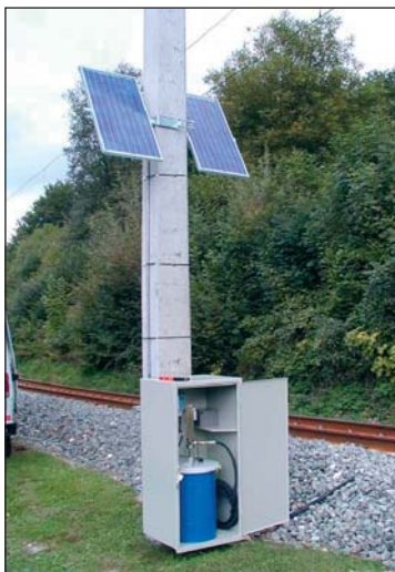
1. kép – A sínkenő berendezés
