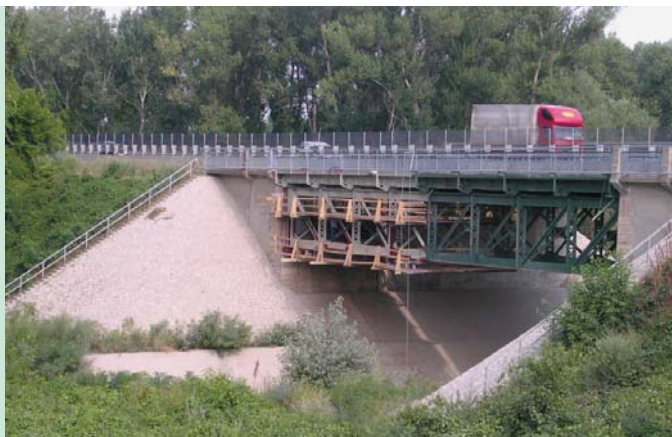
12. kép – A hullámtéri híd, a 2001- ben mellé- épült közúti hídon áthala- dó járművel, víz nélkül (fotó: Kiss Józsefné 2003. 07.22., szerkezetmá- zoláskor)
