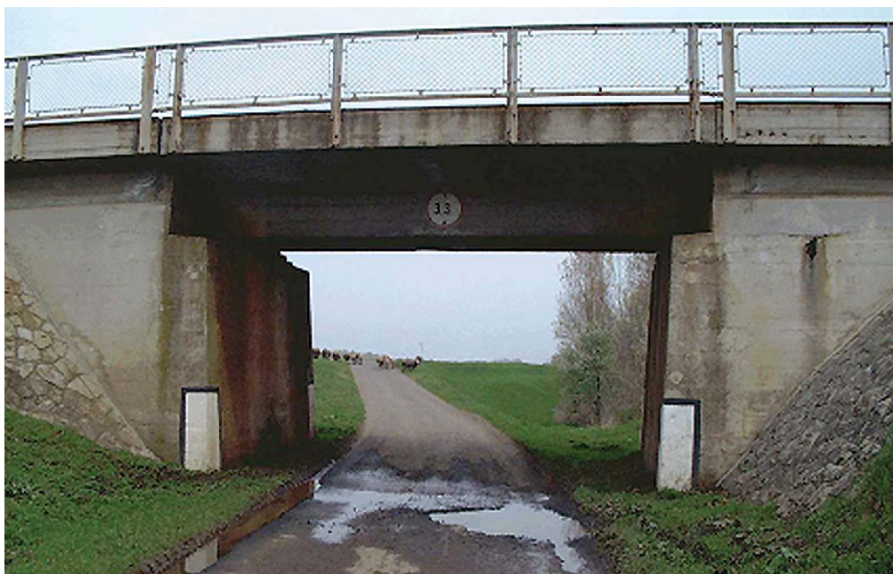
5. kép – Kiskörei közös közúti-vasúti Tisza-híd Abádszalók felőli hídfő, a mentett oldalra folyik a Tisza vize az aluljáró-háttöltés szivárgóján keresztül
