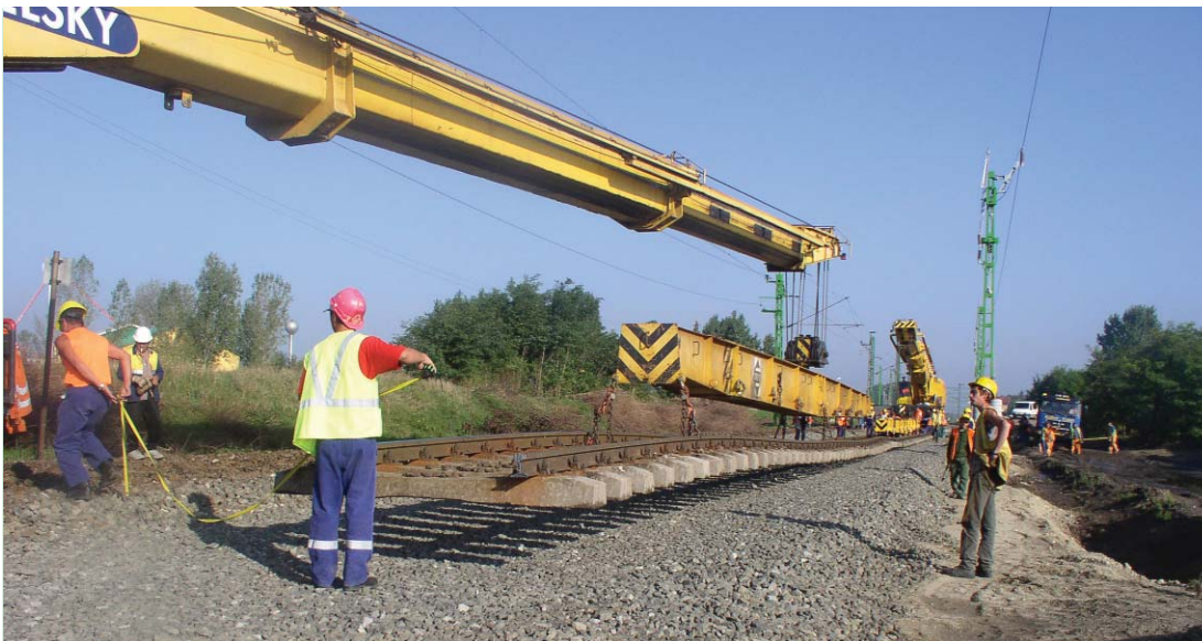
4. kép – Vágányfektetés az elkészült ágyazaton
