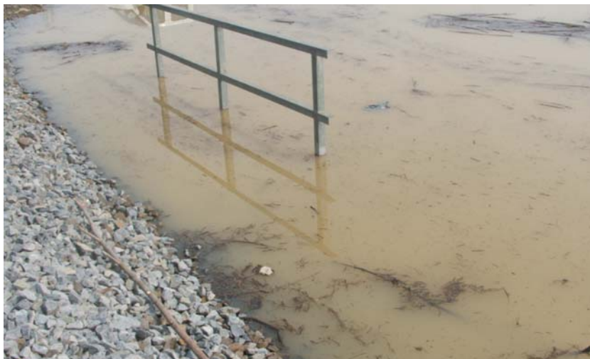
2. kép – A 4,16 m-es mederfenék-pályaszint különbségből csak az ágyazat látszik
