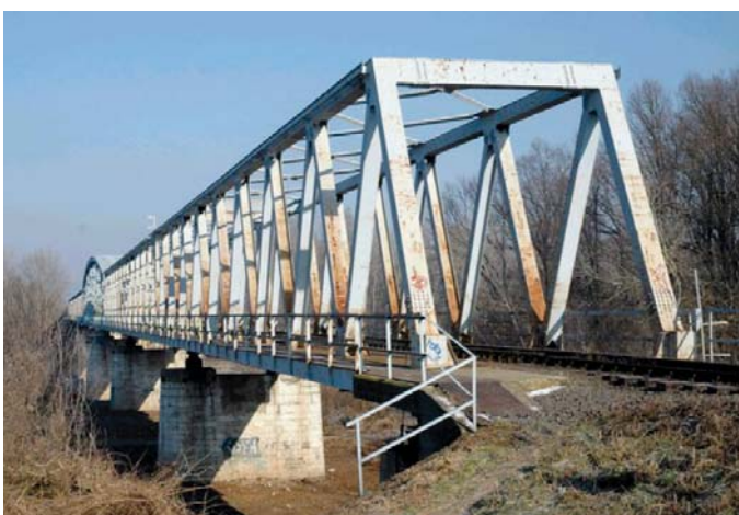
7. kép – Az algyői Tisza-híd pillérei jól láthatók az árvíz előtt (fotó: Lakatos István 2006.03.01.)
