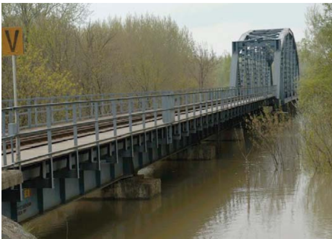
13. kép – A híd a fakadó vizekkel átáztatott védőgátról nézve (fotó: Lakatos István 2006.04.20., vízállás 960 cm)
