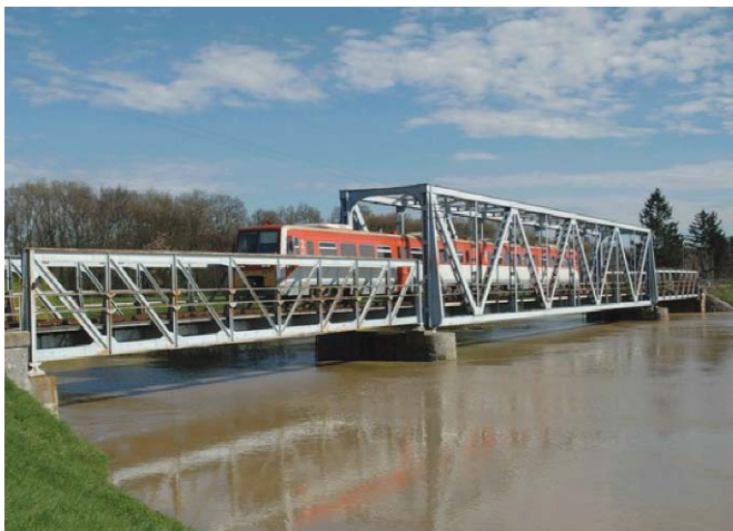
18. kép – Remetei Fekete- Körös-híd (fotó: Lakatos István 2006.04.17., vízállás 692 cm)
