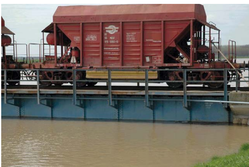
4.kép – A tetőzések nem látszanak az eredetileg 1890-ben épült ártéri hidak sarui (fotó: Lakatos István 2006.04.17.)
