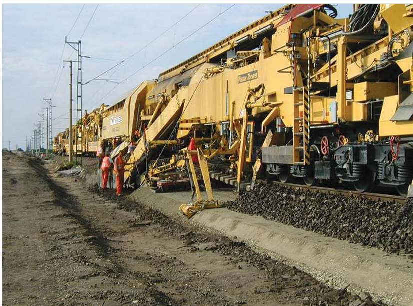
1 kép – Az átépítő vonat munka közben
