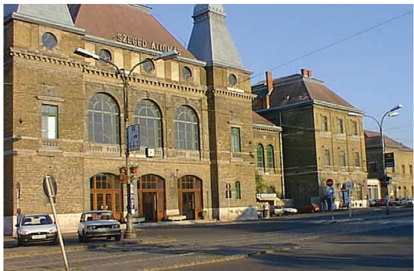
8. kép – a homlokzat felújítás előtt
