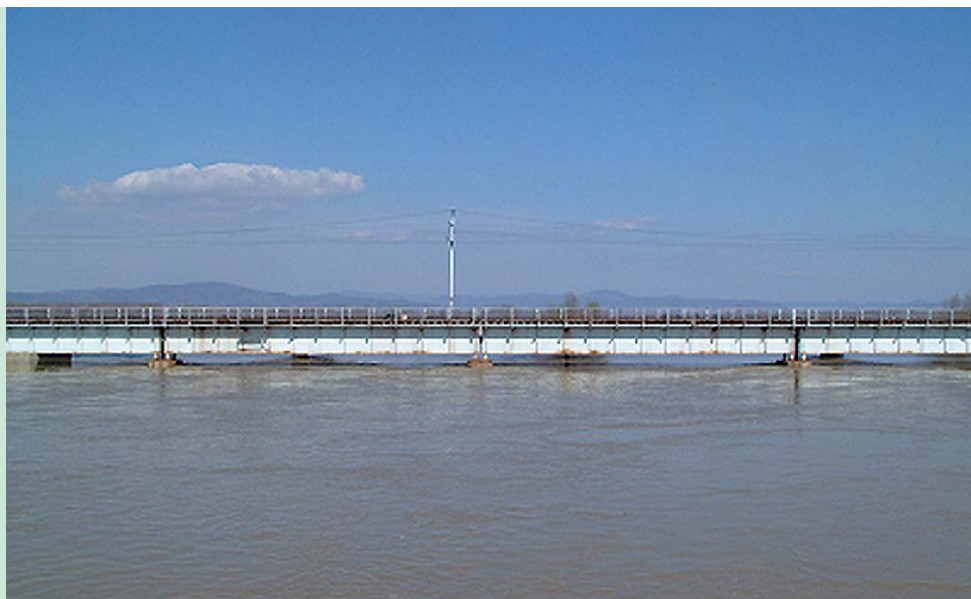
2. kép – Tokaj–Rakamaz állomásköz Aranyospatak híd
