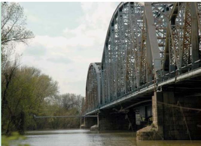
10. kép – Tiszaug vas- úti híd me- derszerkeze- te (fotó: Laka- tos István 2006.04.17., vízállás 908 cm)
