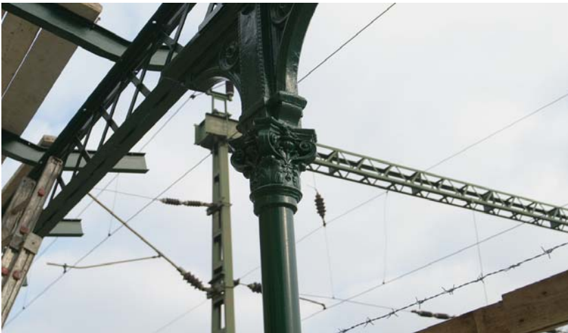
12. kép – új peronoszlop
