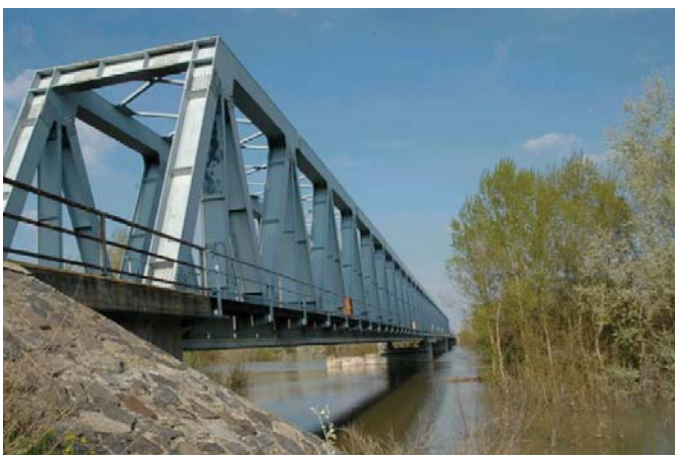
9. kép – Az ország legnagyobb nyílású vasúti hídja Csongrádnál (fotó: Lakatos István 2006.04.25., vízállás 994 cm)
