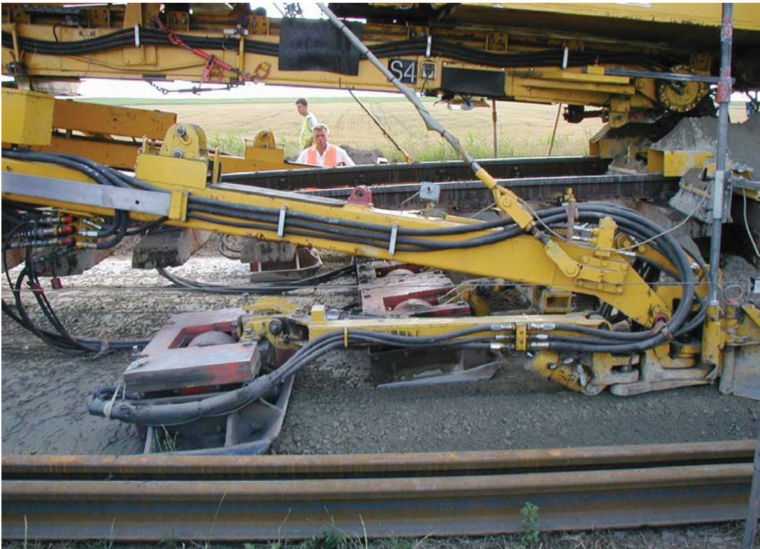
1. kép – Alépítmény tömörítése nagy teljesítményű vibrolappal
