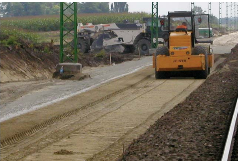
1. kép – Munkavégzés a 81 óras vágányzárban
