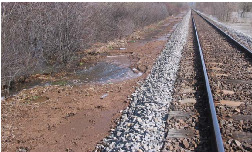
4. kép – Az ágyazathiány pótlására folyamatosan anyagoltuk a zúzottkővet
