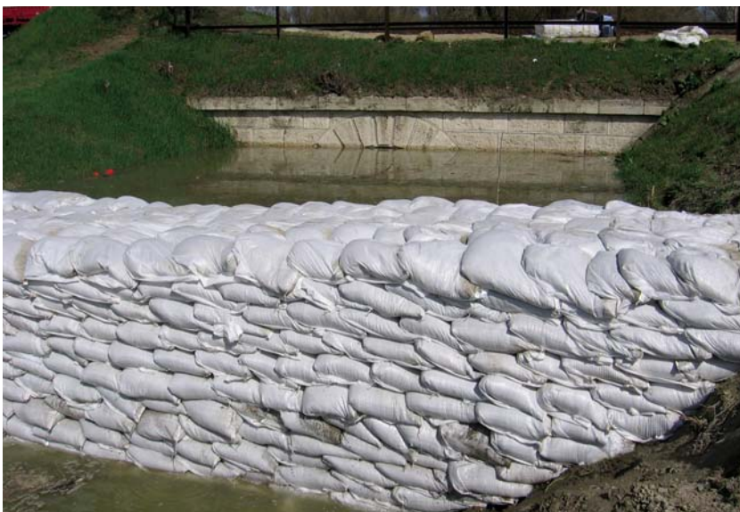
1. kép – A 993+36 szelvényben lévő zsilip mentett oldala az ellennyomó medencével 04. 01-én. (Fotó: Boros Sándor)
