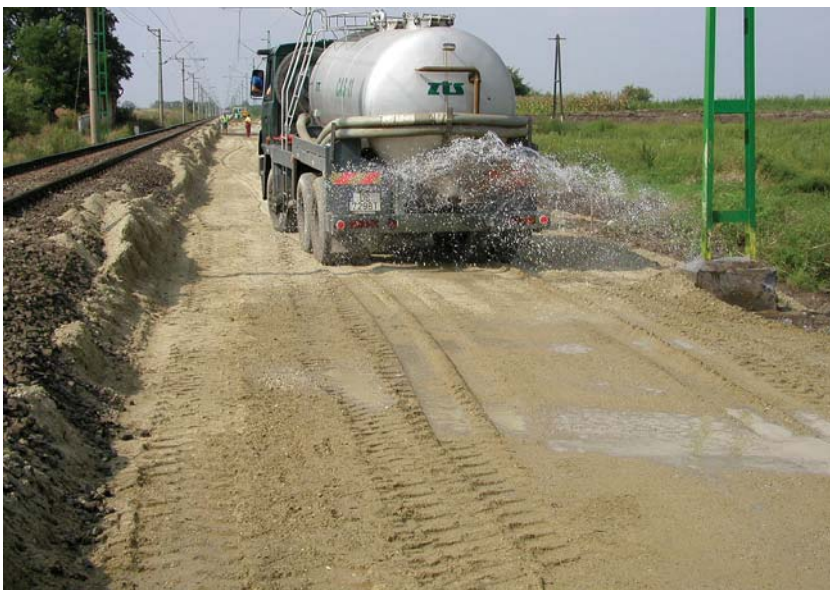
3. kép – Talajstabilizáció készítése
