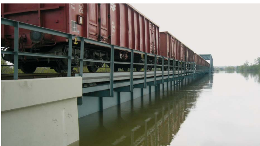
5. kép A kunszentmártoni Hármas-Körös-híd leterhelése az ártéri szerkezetek felől nézve (fotó: Füle Attila 2006.04.20.)
