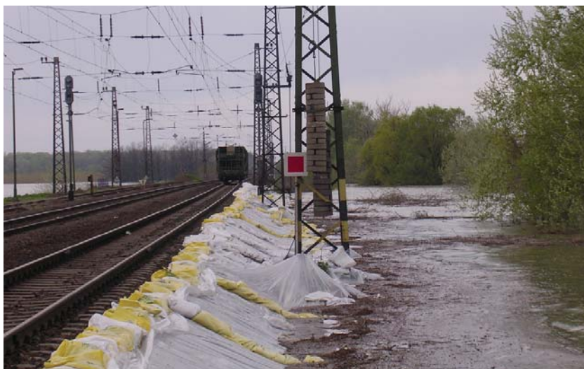
4. kép – Hullámverés elleni fóliatakarás, homokzsák megtámasztással, Szajol bejáratánál (Fotó: Muhari Zoltán)
