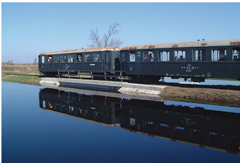
1. kép – Nyíregyháza–Balsa vasútvonal 155+12 szelvény, Kótaj
