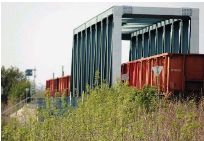
6. kép – A kunszentmártoni Hármaskörös-híd meder-szerkezetének leterhelése (fotó: Lakatos István 2006.04.25.)
