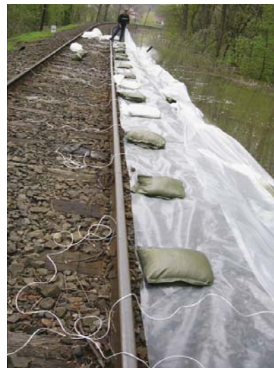
20. kép Az alépitmény fóliás védelme (fotó: Füle Attila 2006.04.24., vízállás 932 cm)
