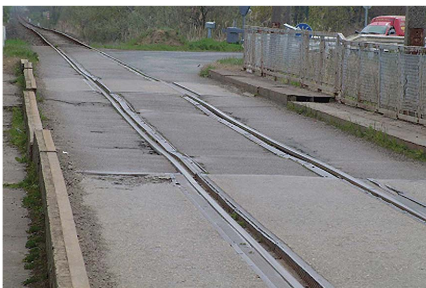
4. kép – Kiskörei közúti-vasúti Tisza-híd megsüllyedt Abádszalók felőli hídfője
