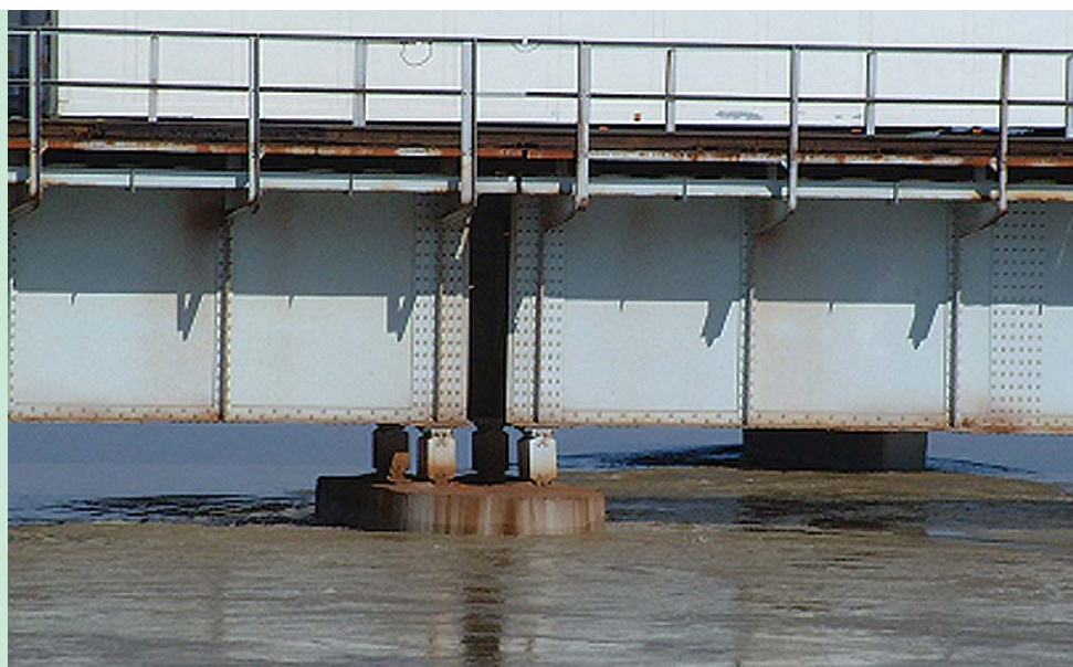
3. kép – Aranyospatak híd pillére
