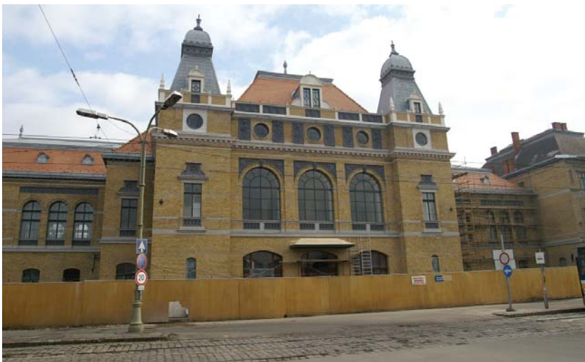
9. kép – a felújított homlokzat
