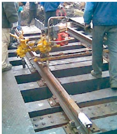
19. kép – Felépítmény lekötése a hídon
