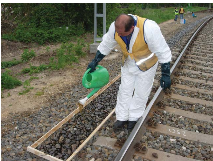
6. kép – A ragasztóanyag felhordása kézi módszerrel
