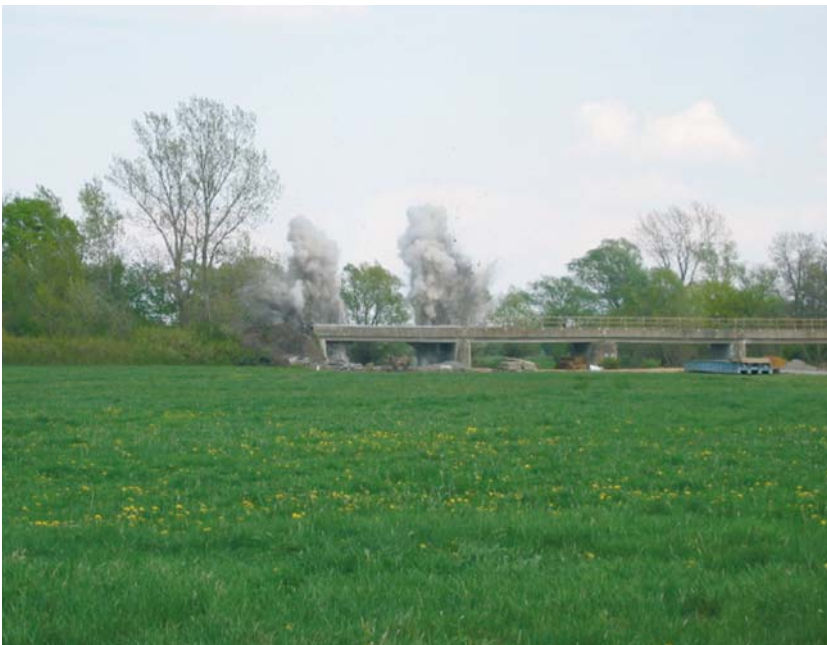
22. ábra – A kezdőpont felőli nyílás robbantása
