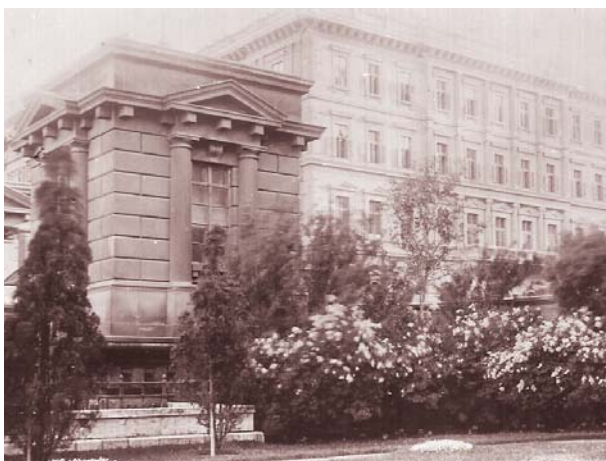
1. ábra Kereskedelemügyi Minisztérium épülete a Lánchíd mellett (1935)
