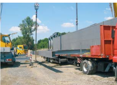
27. ábra – A kiszállított szerkezet leemlése a trélerről
