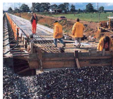
15. kép – A teherbírás növelése érdekében ragasztott ágyazatú vasúti pálya
