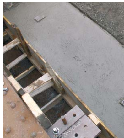
15. kép – A kiegyenlítő lemez finombeállítása két ponton
