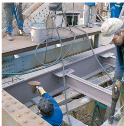
16. kép – Az új pályatartók beépítése
