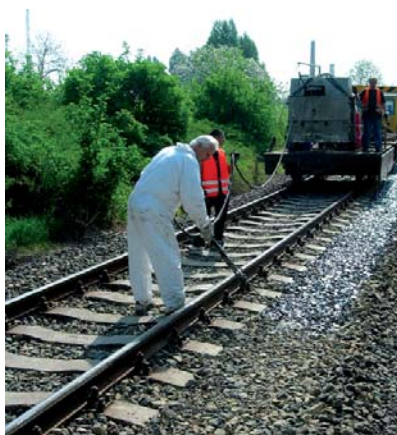
3. kép – A ragasztóanyag felhordása TVG-re telepített nagygéppel
