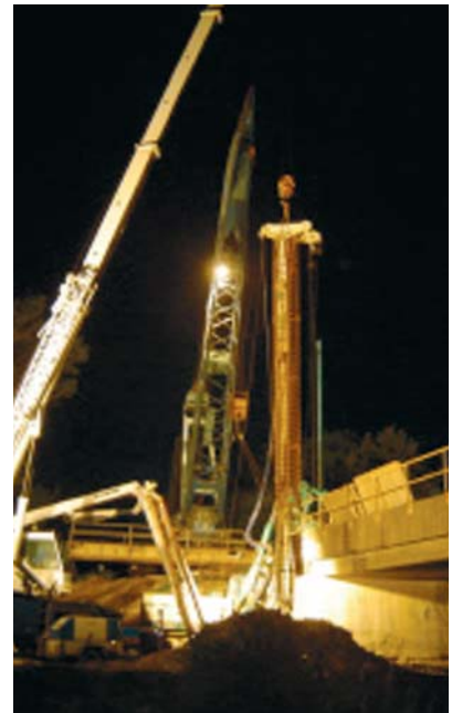
24. ábra – Éjszakai cölöpkészítés
