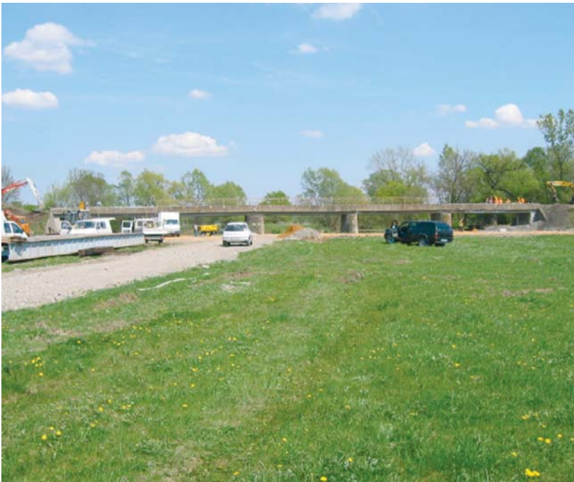
21. ábra – Az ártéri híd az átépítés előtt
