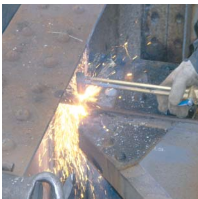
7. kép – A hossztartó szélrács levágása
