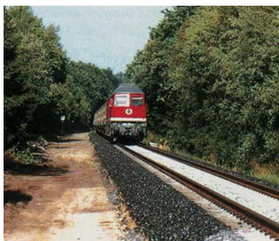
11. kép – Vállrészének megerősítése érdekében ragasztott ágyazatú vasúti pálya
