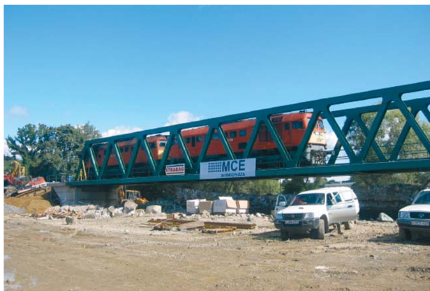
29. ábra – A híd próbaterhelése
