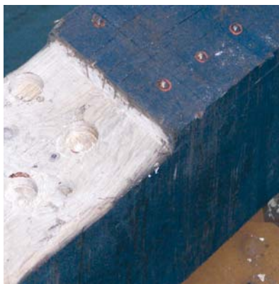
11. kép – Csomólemezek szegecsfejének jelölése a hídfán
