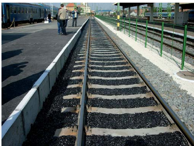
9. kép A tisztítás könnyítése érdekében ragasztott ágyazatú vágány
