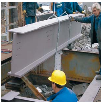
10. kép – Az új jobb oldali hossztartó beemelése
