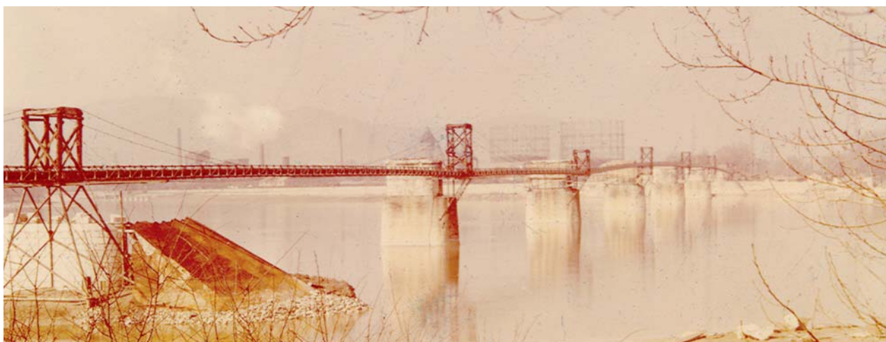
7. ábra – Függőhíd a gázcső átvezetésére
