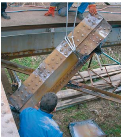
9. kép – A kibontott hossztartó eltávolítása
