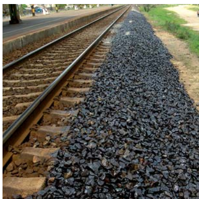
10. kép – Letaposás elleni védelem érdekében ragasztott ágyazatú megállóhely
