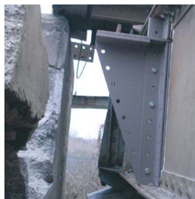
13. kép – A végkeresztartó konzol rögzítése szegeccselés előtt
