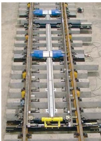
6. kép – Spherolock-zárszerkezet (ÉME-köteles)
