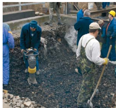
14. kép – A háttöltés tömörítése
