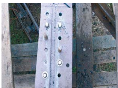
12. kép – Átkötés rögzítése tüskékkel, csavarokkal
