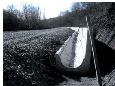
7. kép – Gyöngyös–Lajosháza kisvasút-felújítás, Jász-Vasút Kft.
