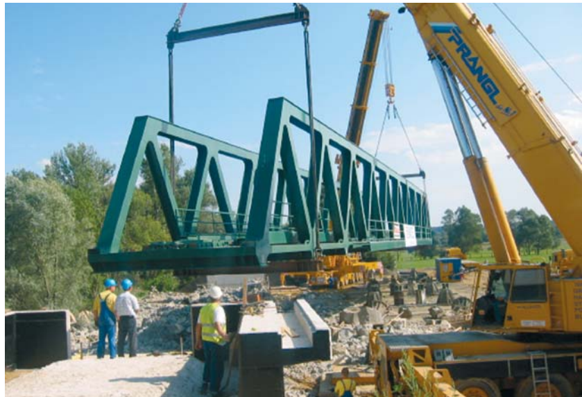
28. ábra – Az acélszerkezet beemelése
