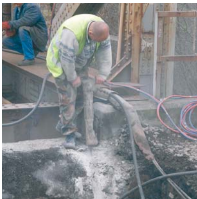
8. kép – A térdfal bontása
