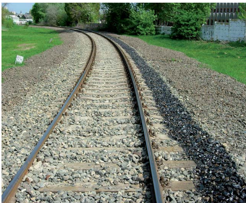
13. kép – A kissugarú ív oldalirányú ellenállásának növelése érdekében ragasztott ágyazatú vasúti pálya
