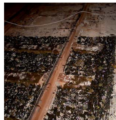
12. kép – Átmeneti szakasz zúzottkő ágyazatú és szilárd pályarészek találkozásánál
