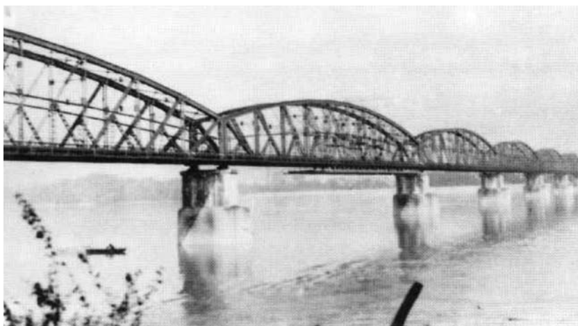
3. ábra – Az eredeti híd képe
