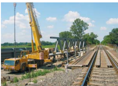
26. ábra – Az acélszerkezet szerelése a szerelőtéren
