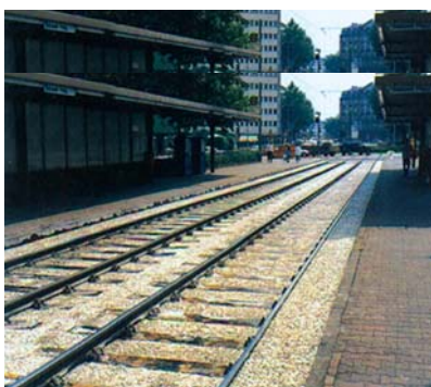
8. kép – A tisztítás könnyítése érdekében ragasztott ágyazatú megállóhely
