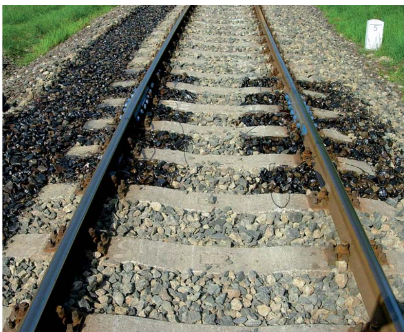
14. kép – A szigetelt sínillesztés élettartamának növelése érdekében ragasztott ágyazatú vasúti pálya
