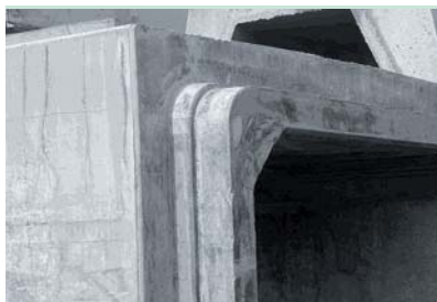
3. kép – Csap kialakítása a gumigyűrű nélkül
