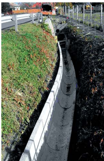
9. kép – Hevesvezekény, kissugarú ív meredek töltésének megtámasztása és vízvezetés megoldása Csomiép–Mócsán-elemmel
