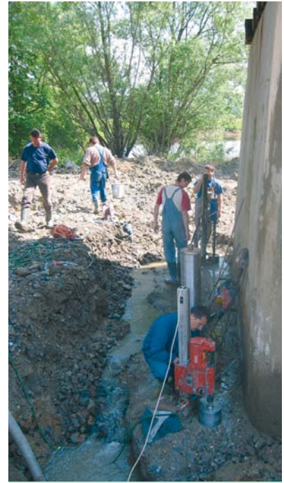
23. ábra – A jet-grouting alkalmazása a pillérnél
