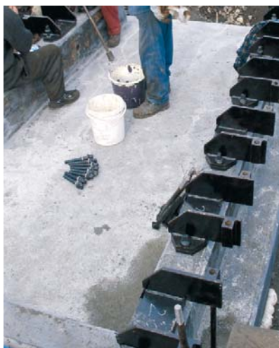
17. kép – Bordás úszólemez a felhelyezett acélpapucsokkal
