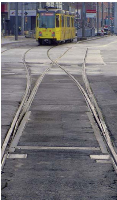
Villamosvágányba épített nagy sugarú, ívesített kitérő
