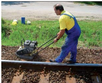
1. kép. Az oldalirányú ágyazati ellenállás növelése tömörítéssel
