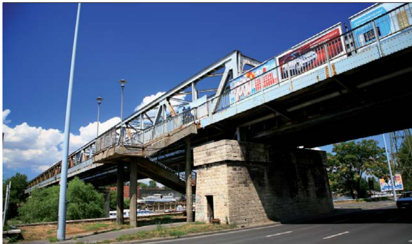
Az Északi Vasúti Duna-híd Váci úti felüljárója
