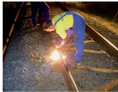
25. kép. A sínek elvágása és feszültségmentesítése
