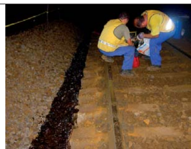
31. kép. Ágyazatragasztás teknőhid utószigetelésénél
