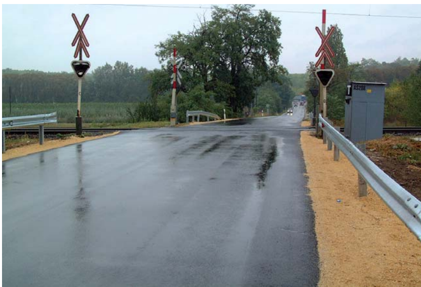
10. kép. Közúti-vasúti szintbeni keresztezés hossz-szelvény-korrektció után
