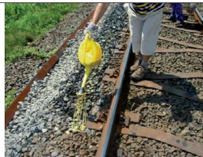
23. kép. Az ágyazatragasztás végrehajtása kézi módszerrel
