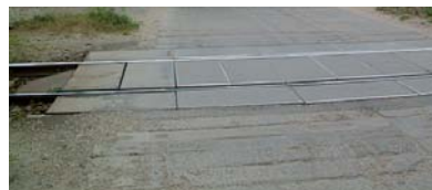
2. kép. BODAN-rendszerű elemes közúti-vasúti átjáróburkolat
