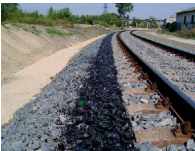
8. kép. Az ágyazatragasztás végeredménye, folyamatos ágyazati gerenda
