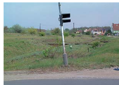
9. kép. Leszerelésre váró fénysorompó
