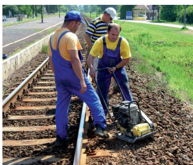
15. kép. Az ágyazatszél vibrolapos tömörítése
