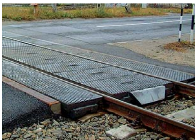
8. kép. TECHNICROSS-rendszerű gumielemes közúti-vasúti átjáróburkolat
