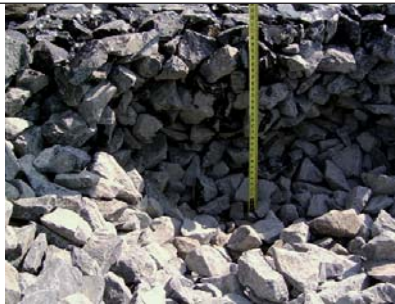
9. kép. Az ágyazatragasztás mélységének ellenőrzése
