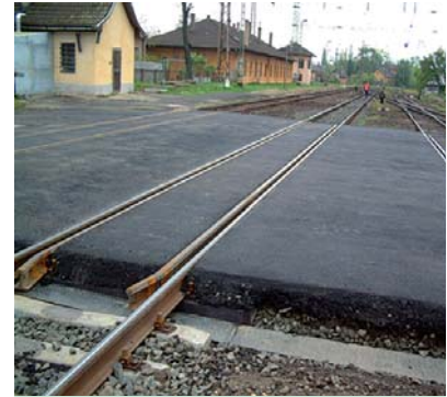
3. kép. Aszfaltburkolatú közúti-vasúti átjáró
