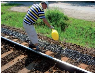
16. kép. Az ágyazatragasztás végrehajtása kézi módszerrel
