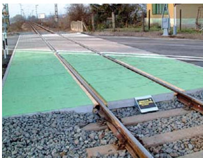
6. kép. Brens-rendszerű, nagy teherbírású közúti-vasúti átjáróburkolat
