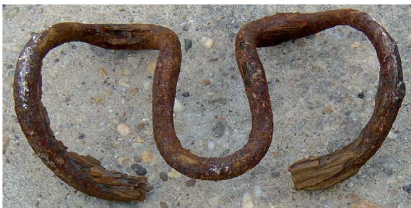
1. kép. Nagyon erősen korrodált Skl 14 típusú leszorítókegyel Komárom állomás páratlan oldali útátjárójából
