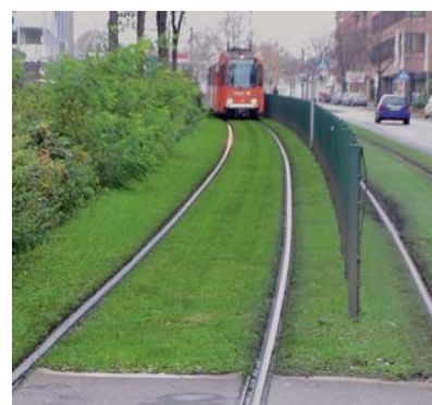
Füvesített villamosvágány Dortmundban
