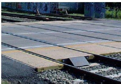
7. kép. Polimer BODAN-rendszerű nagy teherbírású közúti-vasúti átjáróburkolat
