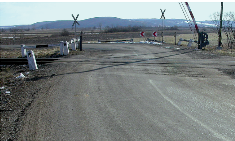
4. kép. Kedvezőtlen közúti csatlakozás a vízszintes és a magassági vonalvezetés szempontjából
