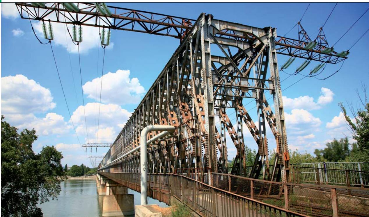
Az Északi Vasúti Duna-híd régi szerkezete
