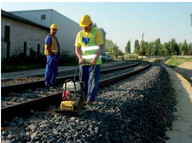
5. kép. Az ágyazatszél vibrolappal történő tömörítése
