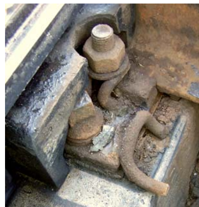
2. kép. Törött leszorítókegyel a Budapest–Hegyeshalom-vonal 1498+65 szelvényében lévő útátjáróban
