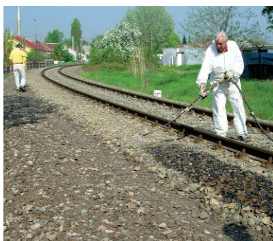
2. kép. Az oldalirányú ágyazati ellenállás növelése ágyazatragasztással
