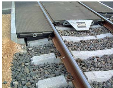
1. kép. STRAIL-rendszerű gumielemes közúti-vasúti átjáróburkolat
