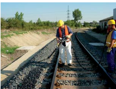
6. kép. Az ágyazatragasztás végrehajtása nagygépes technológiával
