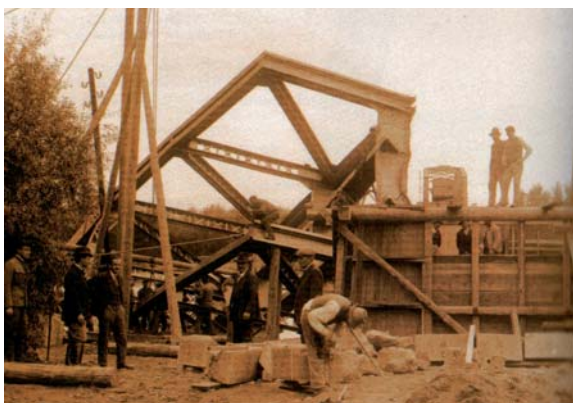
3. ábra. Az áthidaló szerkezetek behúzása 1906-ban
