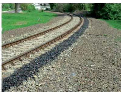
13. kép. A folyamatos ágyazati gerenda
