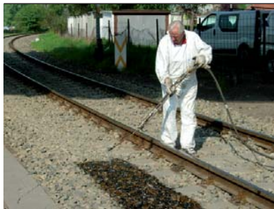
11. kép. Az ágyazatragasztás végrehajtása
