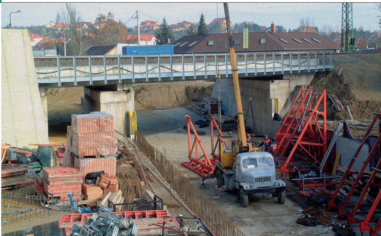
8. kép. Külön szintű keresztezés kialakítása
