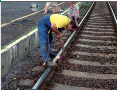
18. kép. A sínek elvágása és feszültségmentesítése
