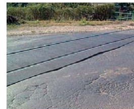
4. kép. Gumielemes közúti-vasúti átjáróburkolat szegélyborda nélkül
