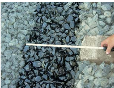
7. kép. Az ágyazatragasztás szélességének ellenőrzése
