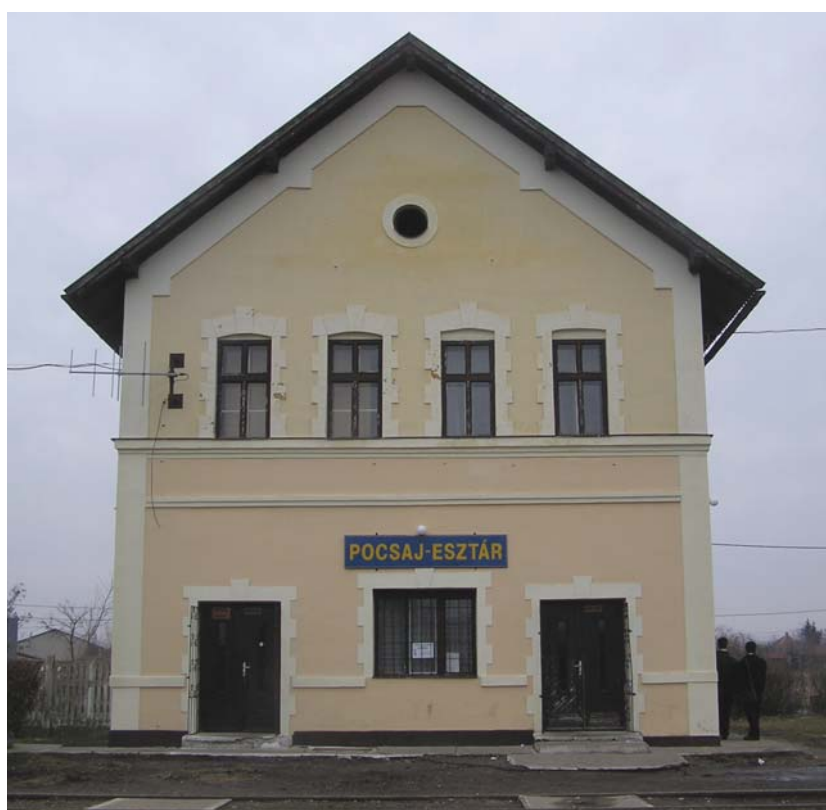
7. ábra. A felújított Pocsaj-Esztár állomás
