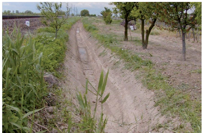
12. kép. A víznyelőhöz csatlakozó új árok
