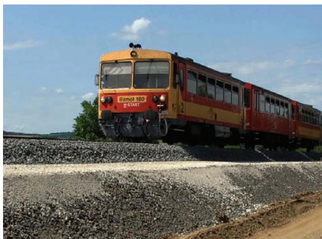
5. kép. Átadott pályatest felújítás után
