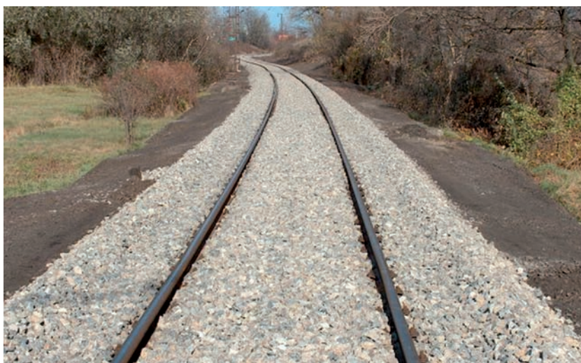
8. kép. A lefektetett vágány az első zúzottkő-leeresztés után
