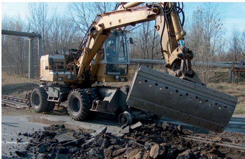
11. kép. Burkolatbontás „kételtű” munkagéppel
