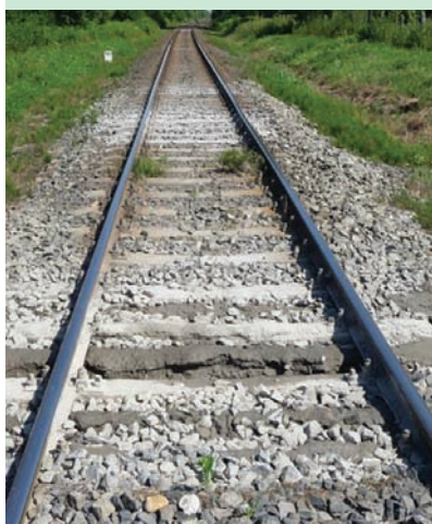
1. kép. Több év alatt kialakult hosszú hullámú fekszinhiba (fent) és a felszínen megjelenő sár (lent) egyaránt tönkrement alépítményre utal
