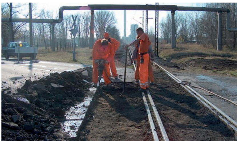
10. kép. Az útátjárók átépítése
