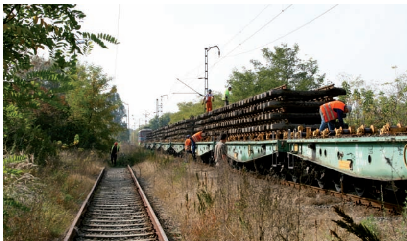
2. kép. A régi vágány bontása Platov-technológiával
