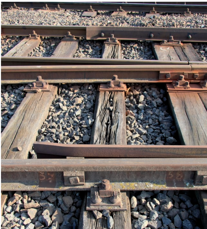
1. kép. Cserére váró kiterő vasútállomáson
