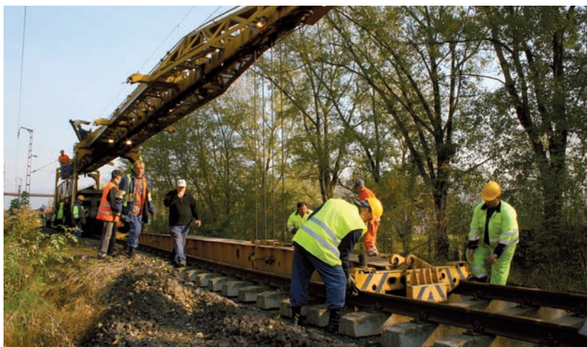
6. kép. Vágányfektetés Platov-technológiával
