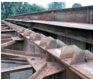
A lecsupaszított hídszerkezet
