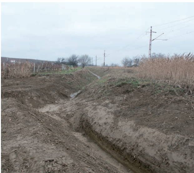
8. kép. A levezető árok takarítás közben
