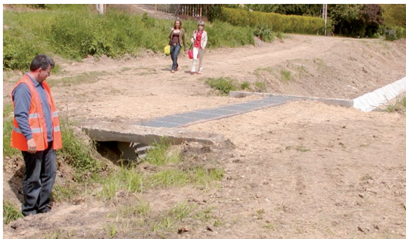
15. kép. A csatornába csatlakozó víznyelő
