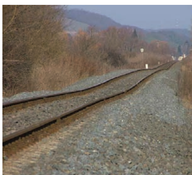
1. kép. Több év alatt kialakult hosszú hullámú fekszinhiba (fent) és a felszínen megjelenő sár (lent) egyaránt tönkrement alépítményre utal
