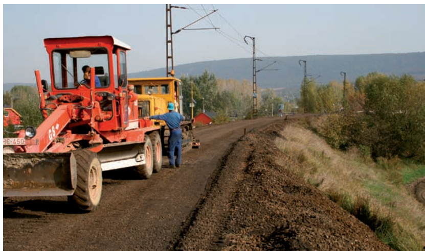
4. kép. Az alsóágyazat tömörítése
