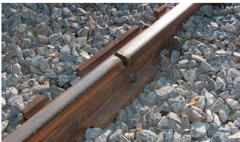
7. kép. A zalai bontásból kapott oldalkopott sínek egyike
