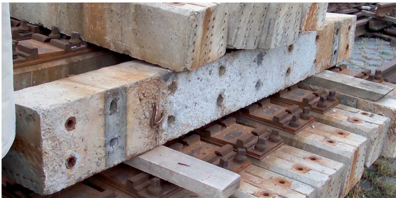
A bontás után deponált TG jelű vasbeton aljak
