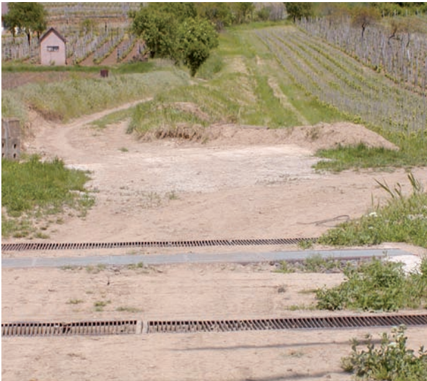
10. kép. A terelőgát és az új víznyelő
